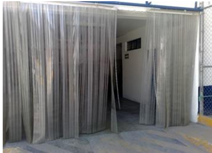
Figura I.29.- Cortinas de plástico para restringir a las aves
