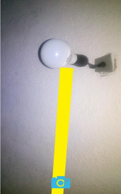
Figura 21 Visualización de la tubería
