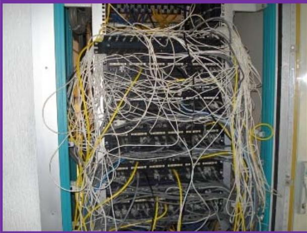
En las gráficas podemos observar que el IDF muestra una saturación e inadecuada organización en el cableado, además de que los nodos no se encuentran identificados.
