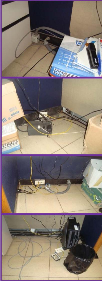
En el área de trabajo del usuario se detectó que muchas de las tomas se encuentran desprendidas, rotas e incluso los jacks están expuestos sin faceplate con riesgo a que el cableado horizontal sufra un daño o provocar un accidente al usuario.
