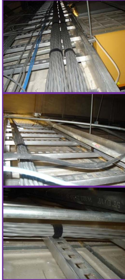
De los trabajos realizados puede observarse la organización acomodo de los cables agrupándolos por mazos, usando cintas de velcro, se ve una escalerilla desahogada y preparada para la instalación de nuevos servicios en caso de requerirse.
