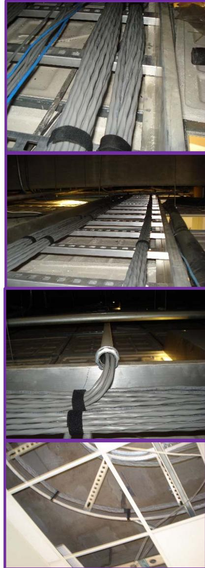
De los trabajos realizados puede observarse la organización acomodo de los cables agrupándolos por mazos, usando cintas de velcro, se ve una escalerilla desahogada y preparada para la instalación de nuevos servicios en caso de requerirse.
