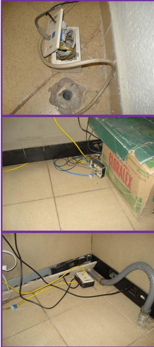
En el área de trabajo del usuario se detectó que muchas de las tomas se encuentran desprendidas, rotas e incluso los jacks están expuestos sin faceplate con riesgo a que el cableado horizontal sufra un daño o provocar un accidente al usuario.
