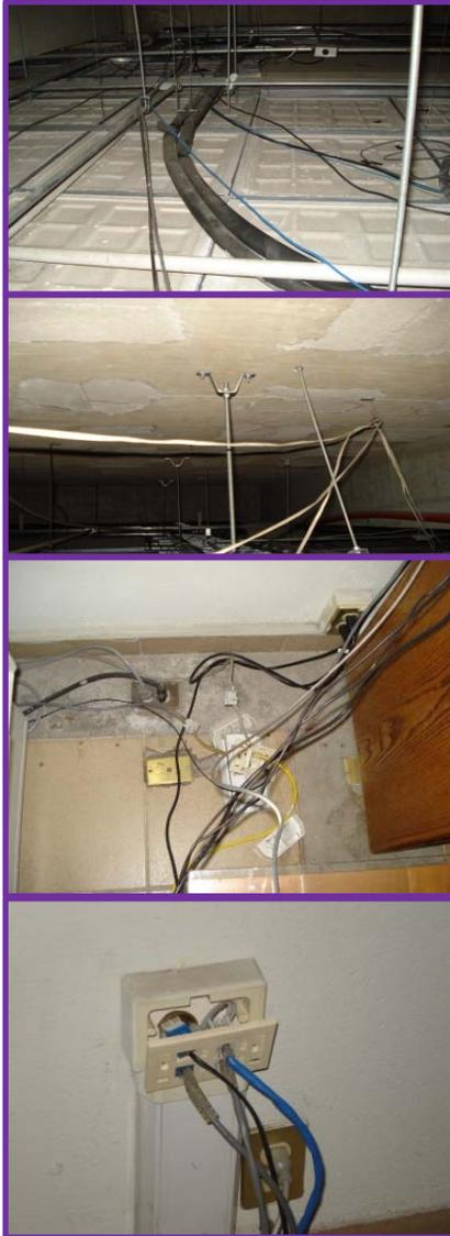
Es evidente la saturación en las charolas, cables mal acomodados y llegada saturada hacia el IDF. En el área de trabajo del usuario se detectó que muchas de las tomas se encuentran desprendidas, rotas e incluso los jacks están expuestos sin faceplate con riesgo a que el cableado horizontal sufra un daño o provocar un accidente al usuario.
