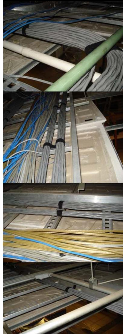
De los trabajos realizados puede observarse la diferencia entre al cableado anterior y el nuevo, el cual ya está organizado y agrupado por mazos, usando cintas de velcro, se ve una escalerilla desahogada y preparada para la instalación de nuevos servicios en caso de requerirse.
