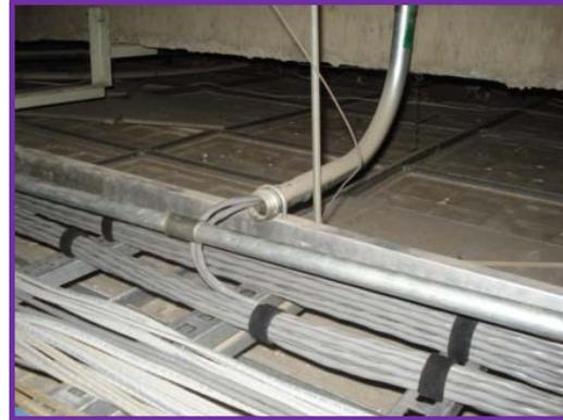
De los trabajos realizados puede observarse la organización acomodo de los cables agrupándolos por mazos, usando cintas de velcro, se ve una escalerilla desahogada y preparada para la instalación de nuevos servicios en caso de requerirse.
