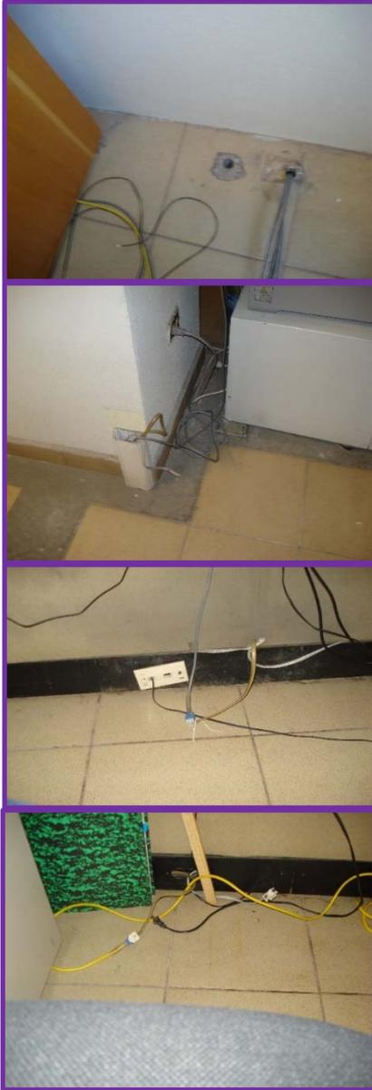
En el área de trabajo del usuario se detectó que muchas de las tomas se encuentran desprendidas, rotas e incluso los jacks están expuestos sin faceplate, con riesgo a que el cableado horizontal sufra un daño o provocar un accidente al usuario.
