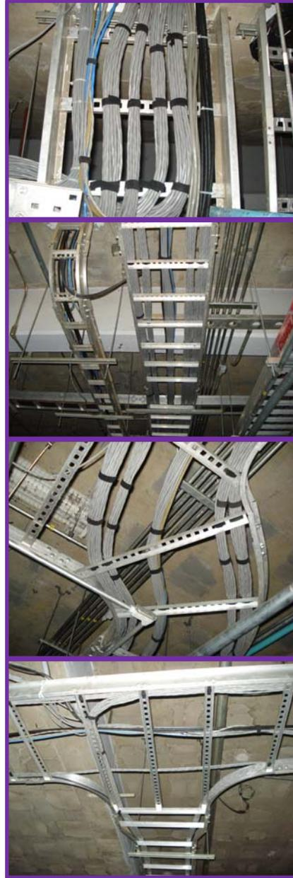
De los trabajos realizados puede observarse la organización acomodo de los cables agrupándolos por mazos, usando cintas de velcro, se ve una escalerilla desahogada y preparada para la instalación de nuevos servicios en caso de requerirse.
