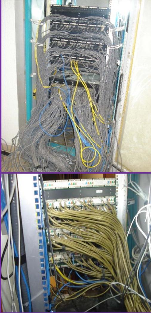
En las gráficas podemos observar que el IDF muestra una saturación e inadecuada organización en el cableado, además de que los nodos no se encuentran identificados.
