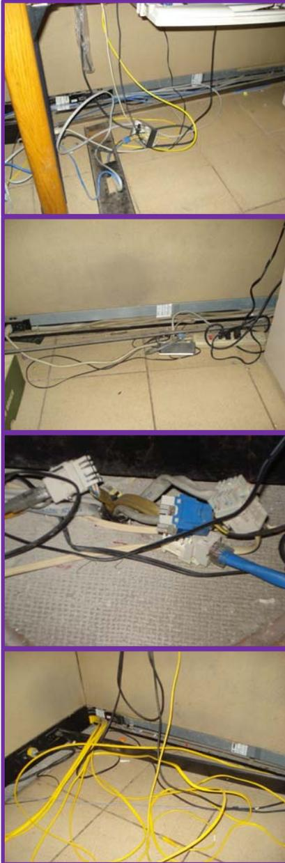
En el área de trabajo del usuario se detectó que muchas de las tomas se encuentran desprendidas, rotas e incluso los jacks están expuestos sin faceplate con riesgo a que el cableado horizontal sufra un daño o provocar un accidente al usuario.
