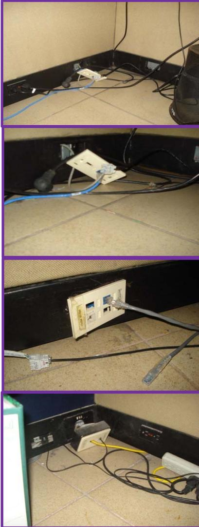
En el área de trabajo del usuario se detectó que muchas de las tomas se encuentran desprendidas, rotas e incluso los jacks están expuestos sin faceplate con riesgo a que el cableado horizontal sufra un daño o provocar un accidente al usuario.
