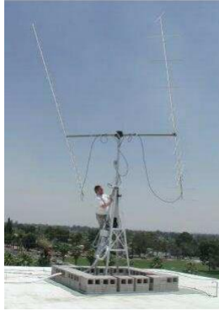
Figura 8. Montaje de la antena Yagui de 2m viii
