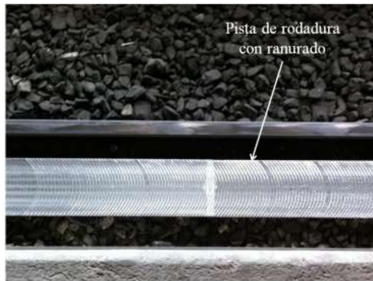
Fig. 1.6. Pista metálica de rodadura con ranurado para mejorar la adhesión.
