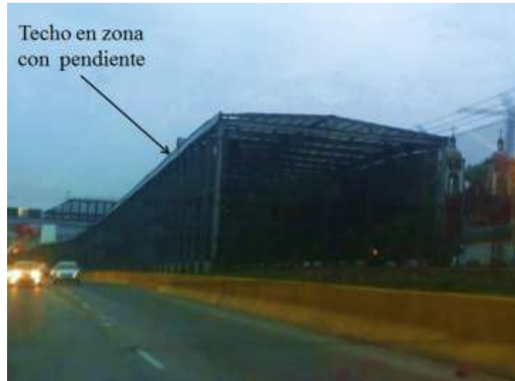
Fig. 1.5. Zona techada en pendiente entre terminales Oceanía y Terminal Aérea.
