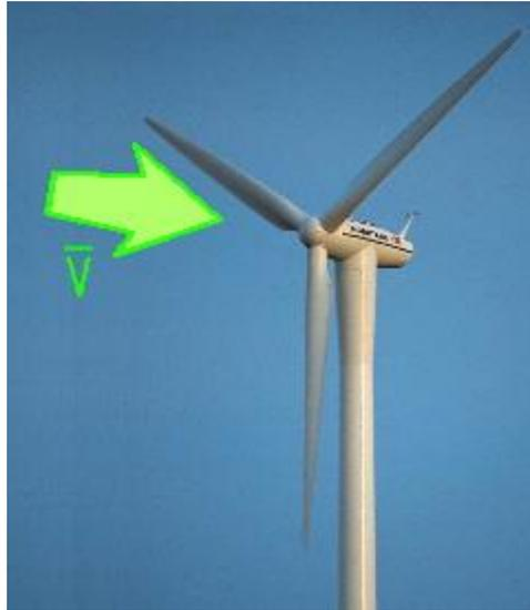
Figura 1.8. Aerogenerador a barlovento [19]
