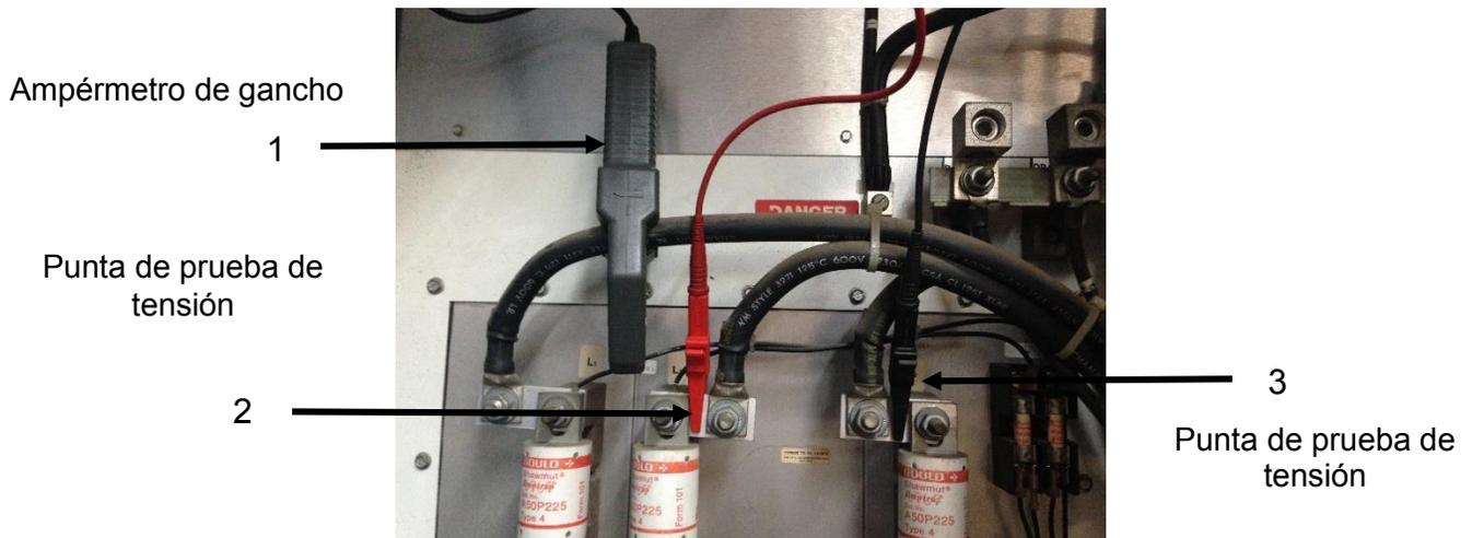
Figura 39: Diagrama de conexión física.
