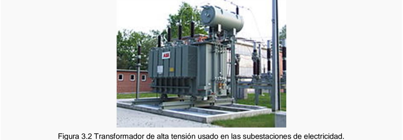
Figura 3.2 Transformador de alta tensión usado en las subestaciones de electricidad.
