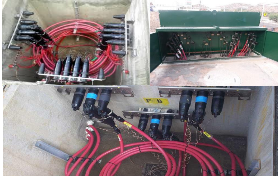
Figura 3. Ejemplo de Distribución Subterránea.
