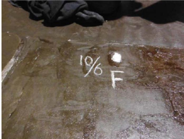
Fig. 50: Imagen de la discontinuidad ubicada en fila 10 placa 6.
