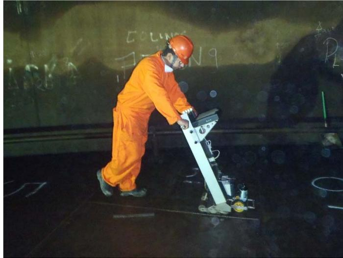
Fig. 37: Inspección de placas centrales por medio de Floormap VS2.
