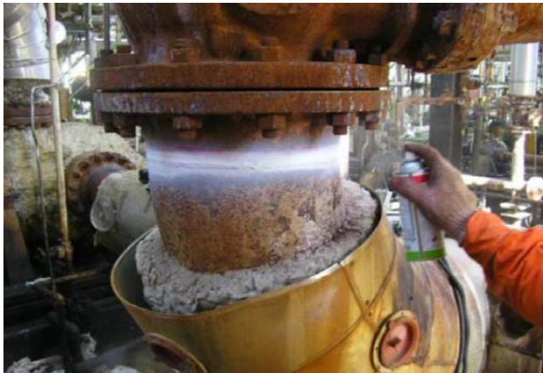
Fig. 16: Inspección mediante Líquidos Penetrantes.
