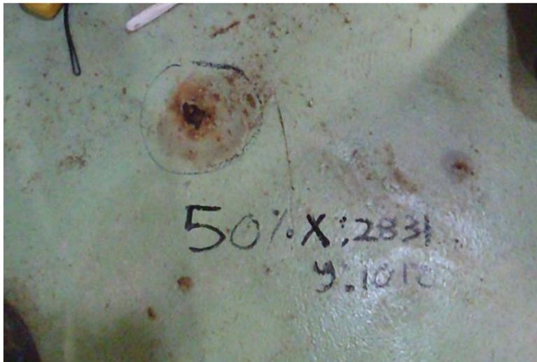
Fig. 45: Corrosión superficial de una placa del fondo del tanque.
