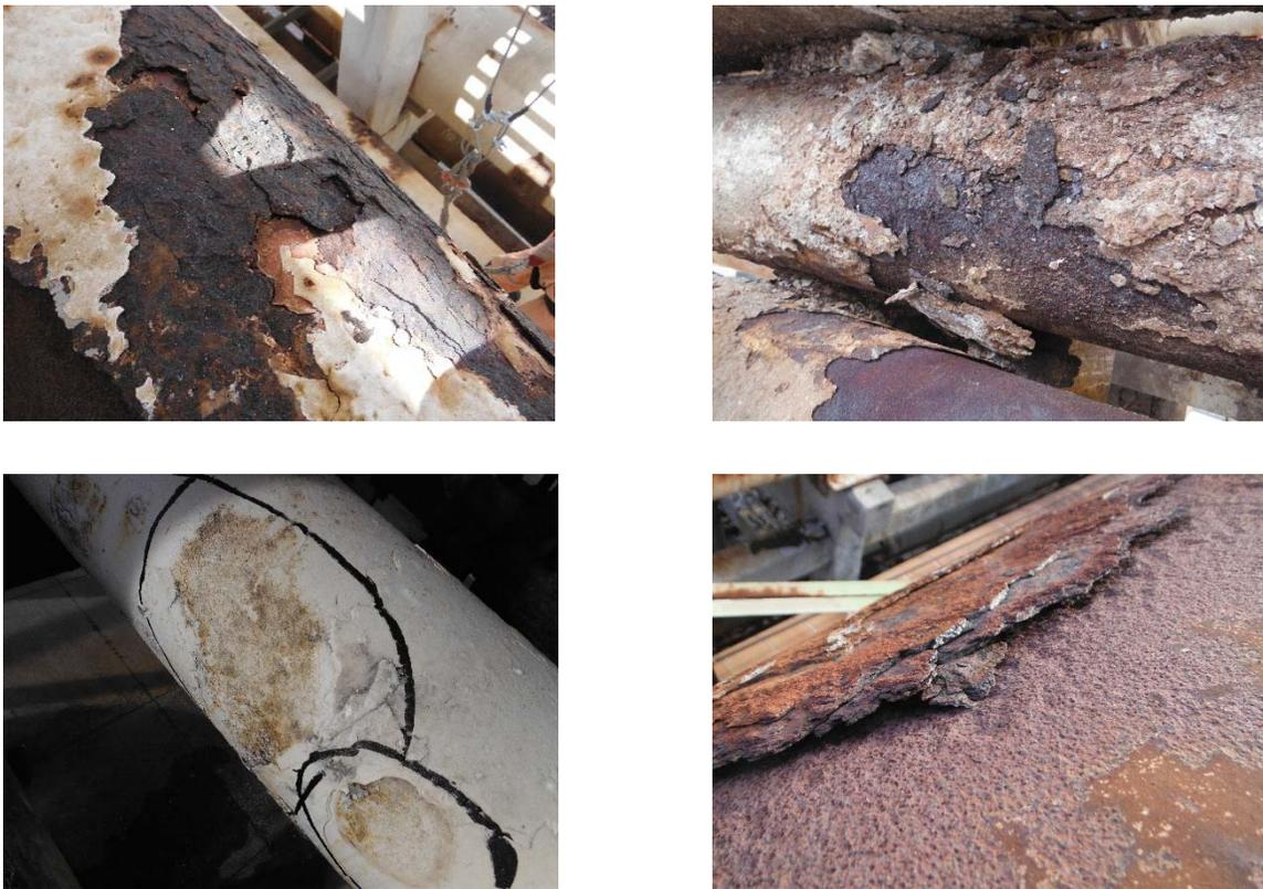
Fig. 2: Ejemplos de corrosión galvánica.
