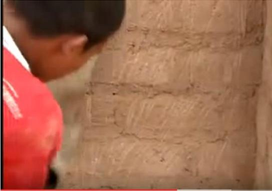
Preparación del muro mediante raspado. imagen tomada de <https://www.youtube.com/watch?v=AawpfceDGeU>.
