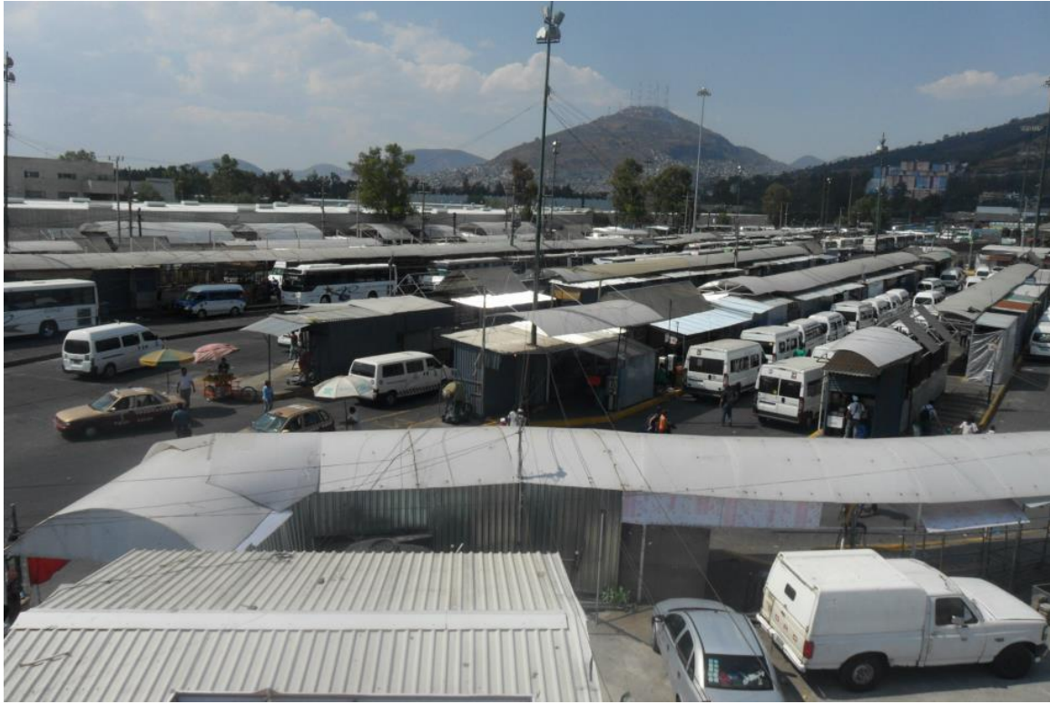
Foto panorámica de todos los andenes.
