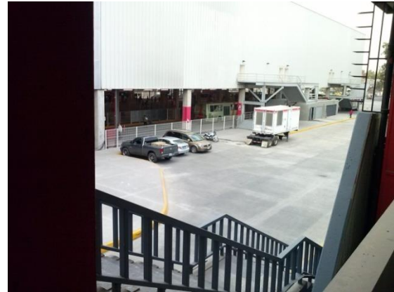
Vista de Patio de maniobras desde área de andenes
