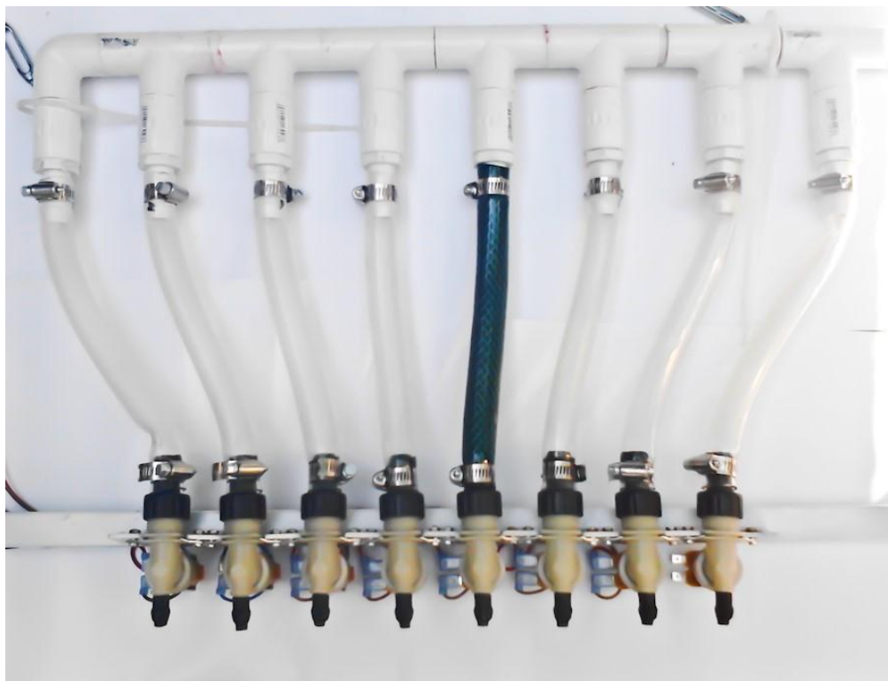
Figura 32. Estructura completa (vista frontal.)
