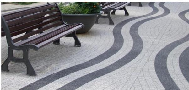
2.- Otra de las soluciones son los hormigones coloreados y/o aplantillados, hormigón de diferentes resistencias características, pero que en su composición introduce un colorante, añadido en central o “in situ”, de forma que se puede conseguir el color deseado.
