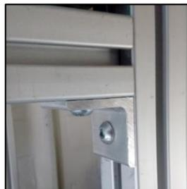
Figura 2.15. Ángulo de unión entre perfiles.
