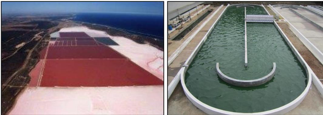
Figura 1.3. Ejemplos de sistemas de cultivo abiertos: laguna (izquierda) y estanque con canales (derecha) (Reyna, 2010).
