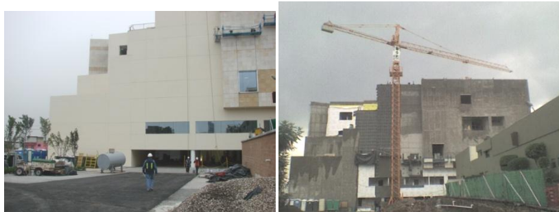
Figura 25 Fotografía de la construcción
