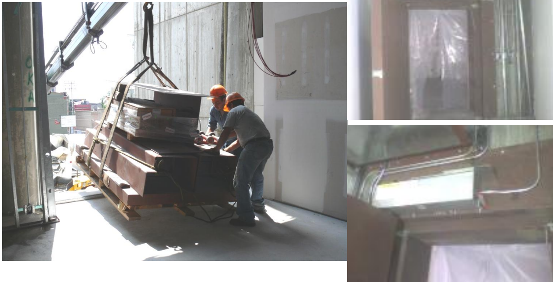
Figura 18. Arriba llegada de la puerta, abajo a la izquierda el control de la puerta a la derecha la puerta instalada.
