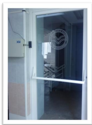
Ilustración 14 Salida de emergencia.
