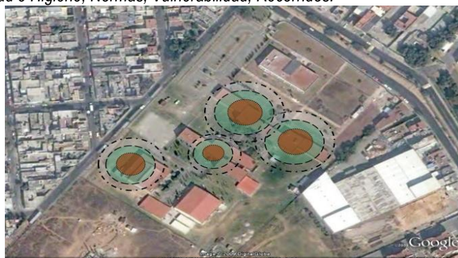
Figura No. 1.- Ubicación de los tanques de almacenamiento de Gas Lp
