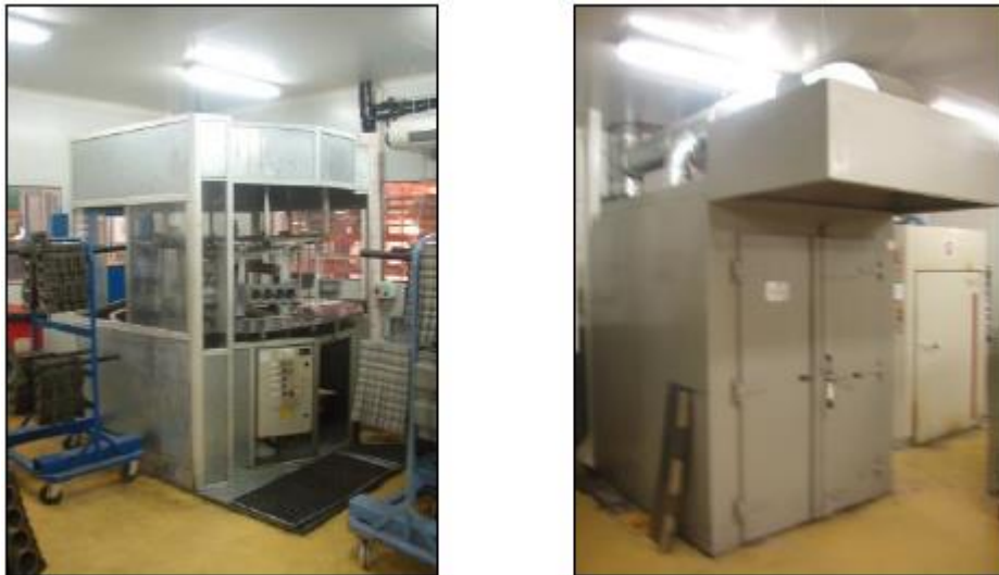
Figura III.3.- Cabina de impregnación y horno estático de curado [III.1]
