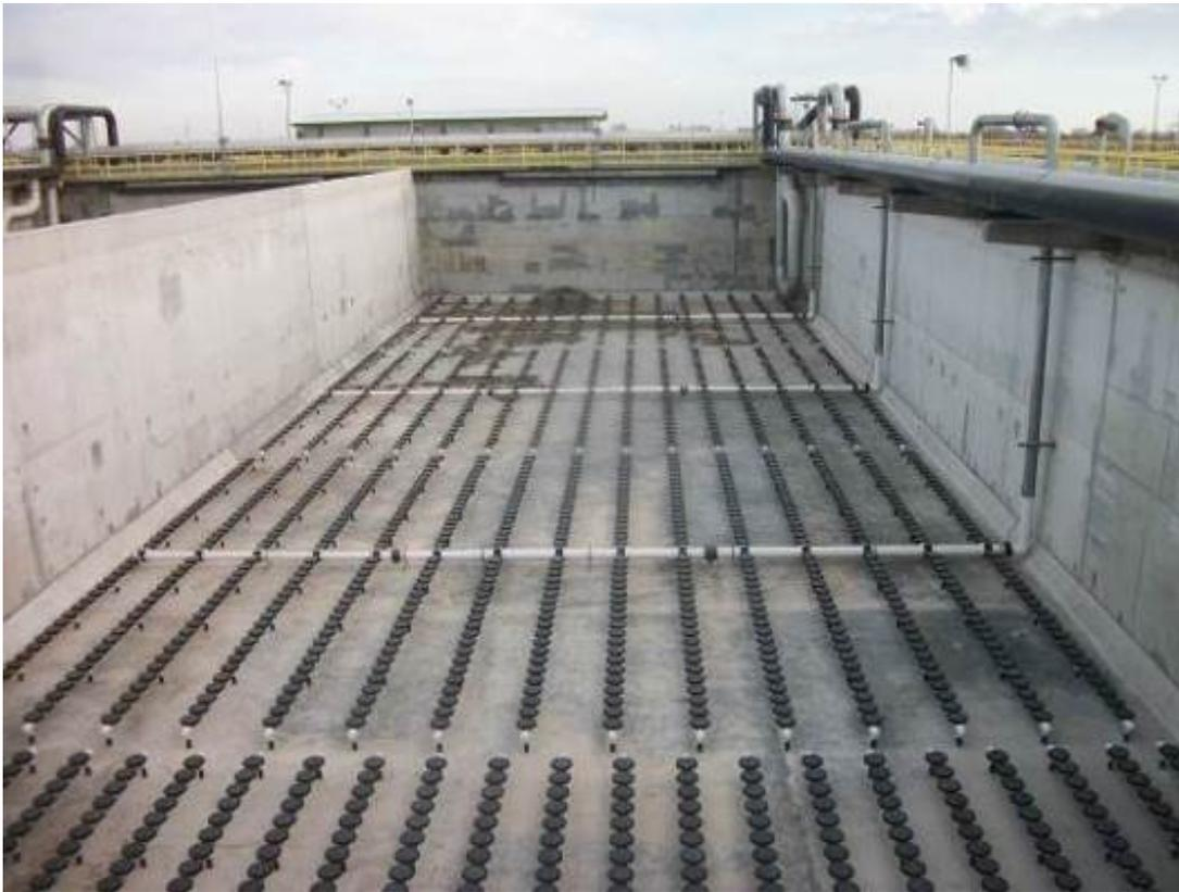
**Figura 1.14 Reactor biológico con red de aire y difusores de burbuja fina.**
