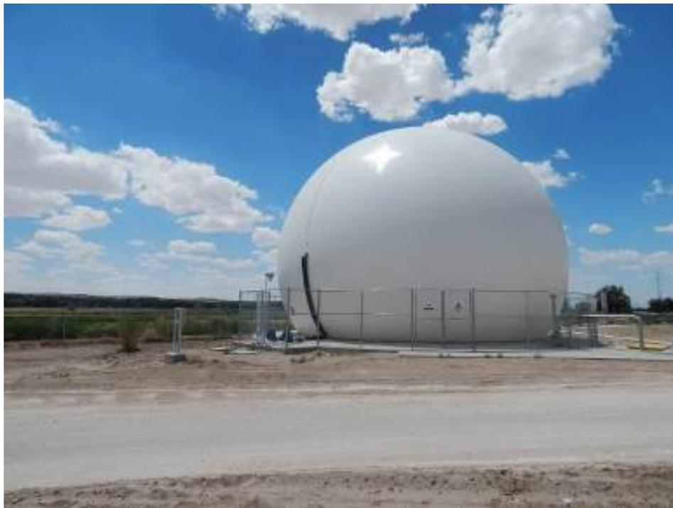
**Figura 1.24 Gasómetro 2,100 m<sup>3</sup> de capacidad**
