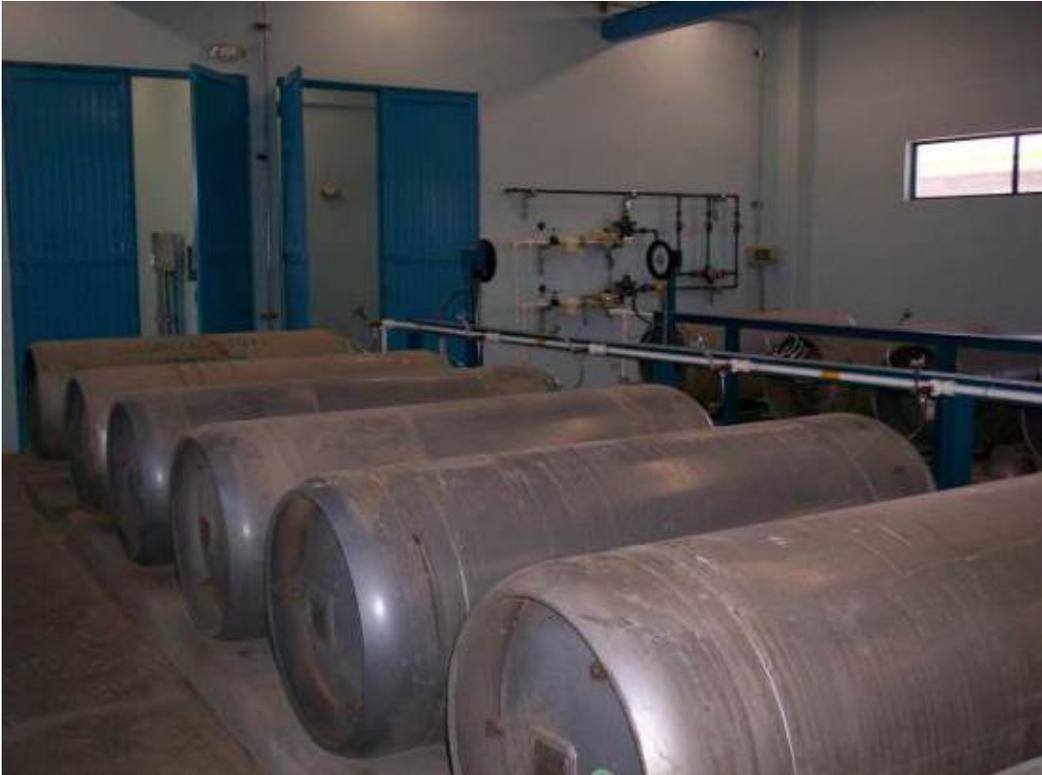
**Figura 1.11 Cilindros de cloro gas**
