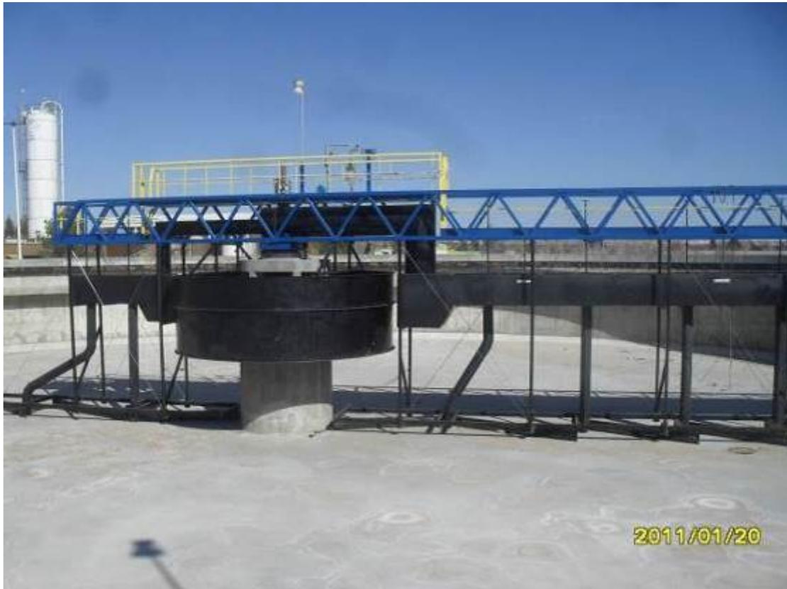
**Figura 1.16 Mecanismo de clarificador: corona central, puente, rastras y tubos verticales con canaleta para extracción de los lodos**
