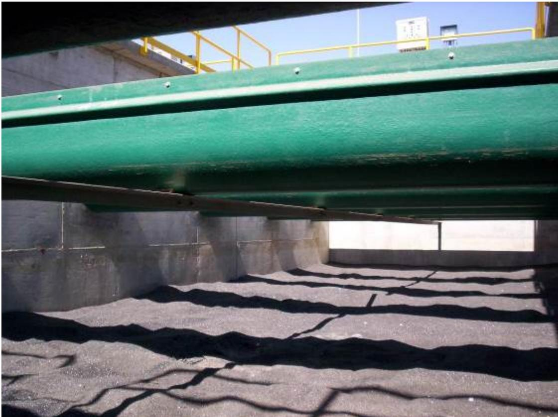
**Figura 1.10 Arena antracita debajo de canaletas de recolección de agua sucia de lavado. Planta Potabilizadora “Xochimilco”, Mexicali**
