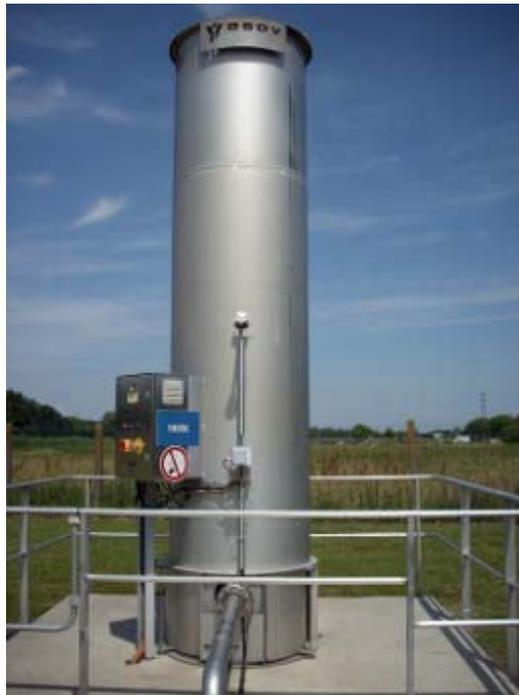
**Figura 1.25 Antorcha para quemar de 150 a 250 N m<sup>3</sup>/hr. de biogás**
