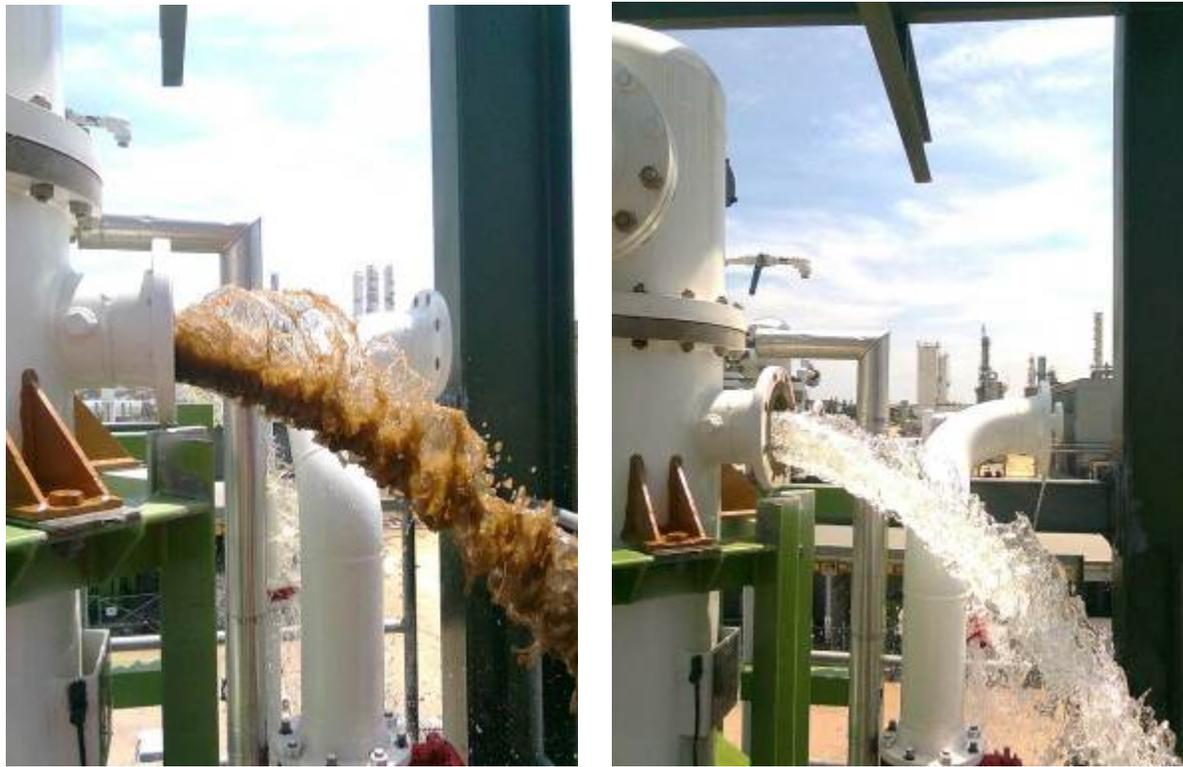
**Figura 5.4 Limpieza de tubería y equipo mediante barrido con agua.**
