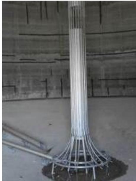
**Figura 1.22 Cañas de inyección de biogás dentro de digestor anaerobio**
