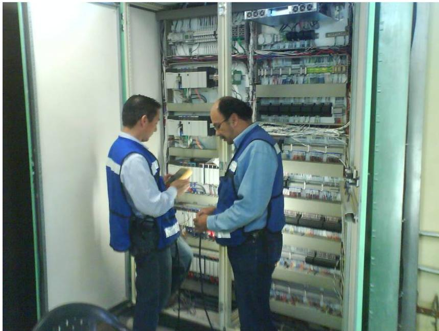
**Figura 5.7 Pruebas de lazo en tablero de control o PLC.**
