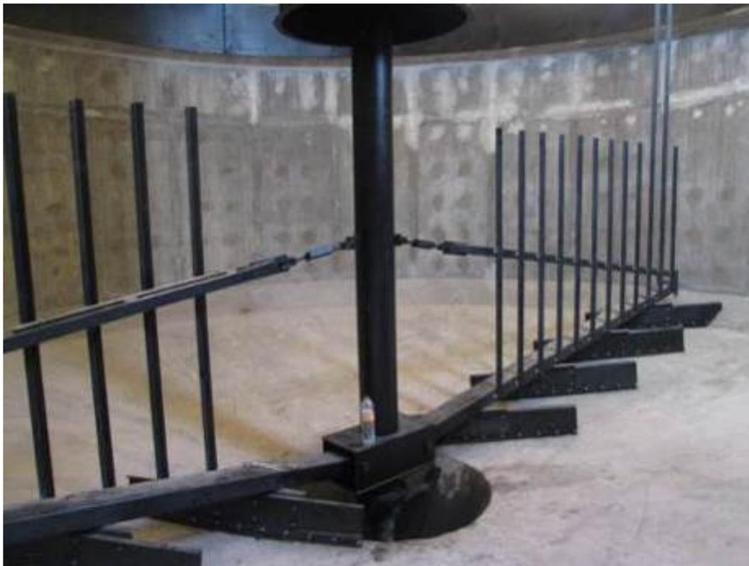
**Figura 1.18 Mecanismo de un espesador de lodos circular a gravedad con fondo cónico y sistema de rastras para orientar los lodos al centro**
