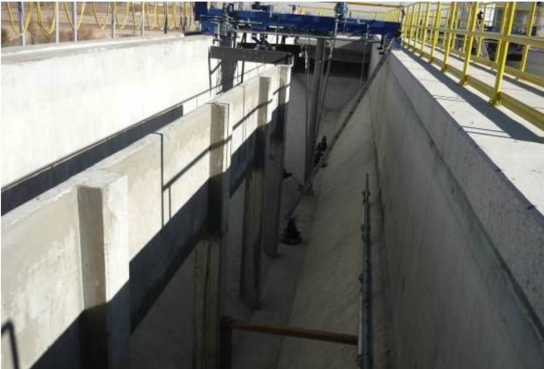
**Figura 1.13 Desarenador – desengrasador rectangular.**
