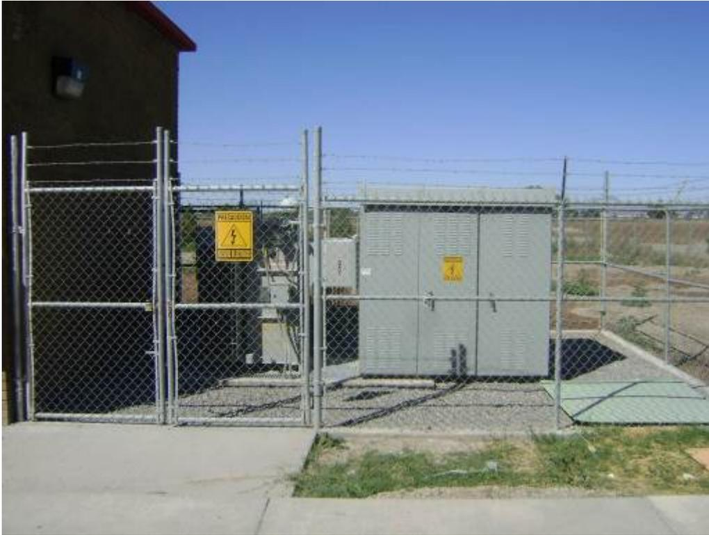
**Figura 2.8 Subestación eléctrica media tensión (13.8 kV) y transformador 750 kVA**
