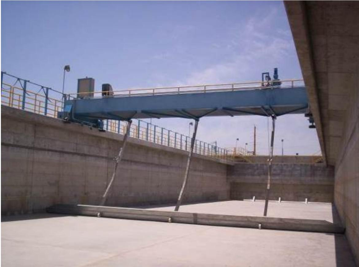
**Figura 1.6 Fondo de sedimentador longitudinal con mecanismo de rastras**
