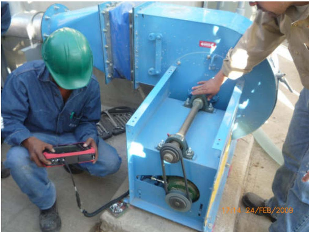
**Figura 5.6 Medición de vibración a un motor acoplado de un ventilador.**
