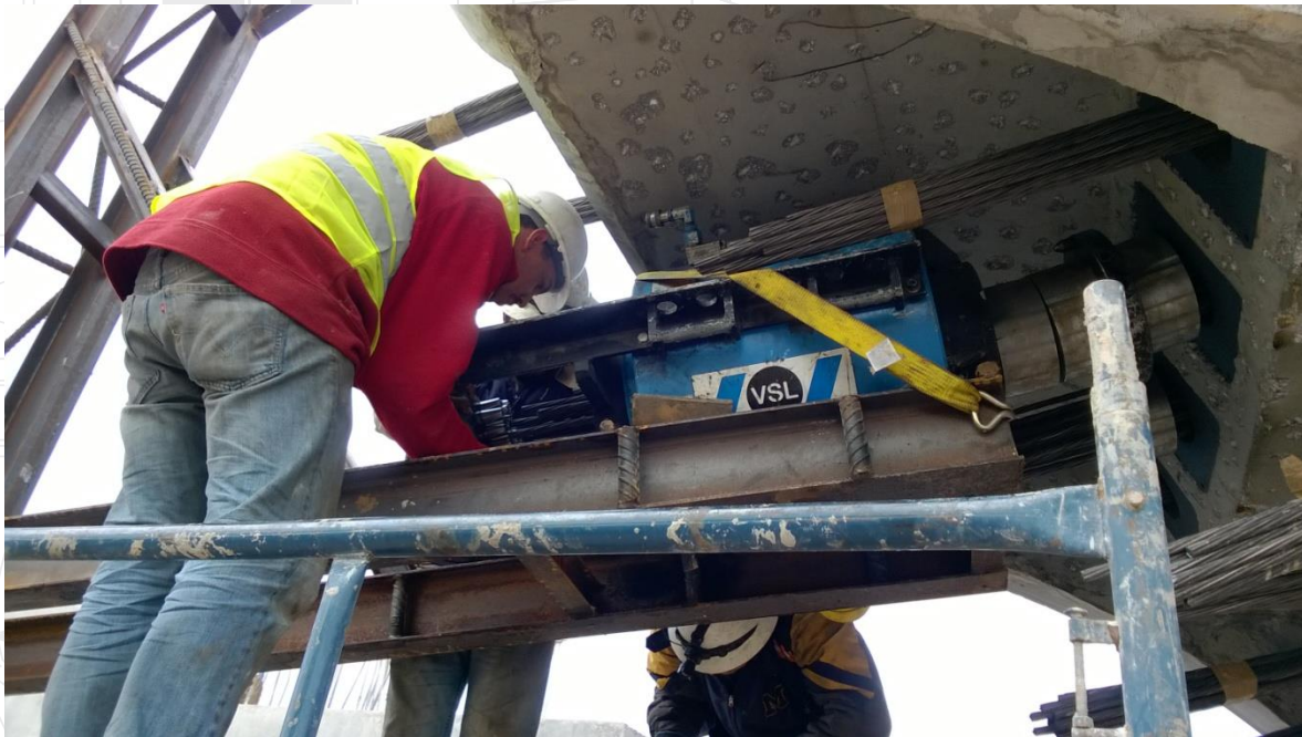
Ilustración 2. Postensado de acero de presfuerzo con gato de tensado tipo multitorón.
