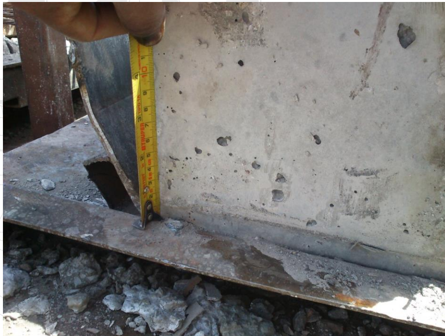
Ilustración 117. Verifico la contraflecha, generada por la transferencia del esfuerzo a los torones.
