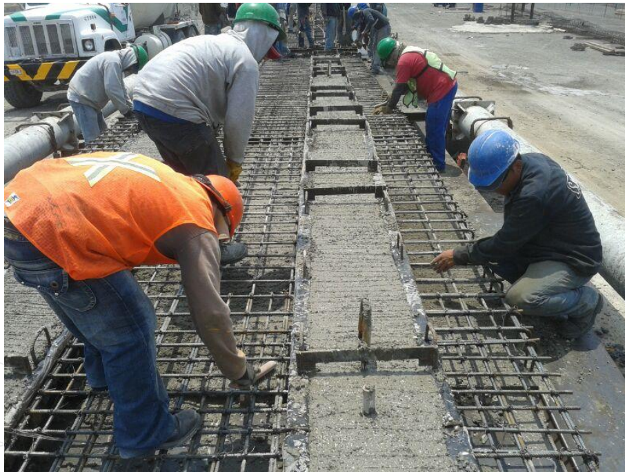
Ilustración 107. Finalmente se limpia el acero de refuerzo con cepillos de cerdas de alambre; para garantizar la adherencia entre el acero de refuerzo y un segundo colado hecho en obra.
