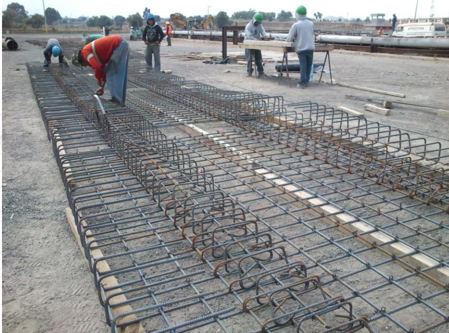
Ilustración 75. Superviso la posición de las nervaduras.
