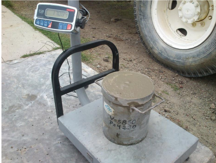
Ilustración 105. Al igual se realizaba la prueba por peso volumétrico del concreto en estado fresco, para cumplir con las especificaciones de proyecto.
