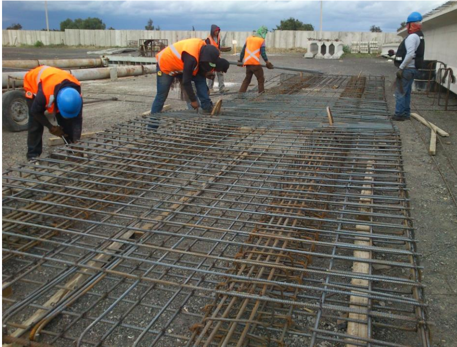
Ilustración 76. Revisión de cantidades de varillas, según su diámetro.
