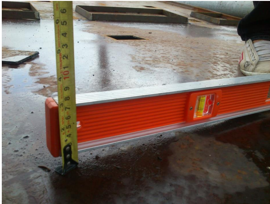
Ilustración 64. Verifico la deformación del lienzo metálico e indico la limpieza y cardeo de molde, para quitar la oxidación que presentan los moldes.
