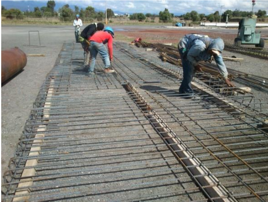
Ilustración 74. Verifico la alineación del acero transversal y longitudinal que conforma la cama inferior de las prelasas.
