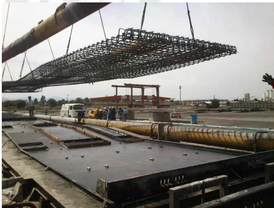
Ilustración 80. Introducción del armado de la prelosa 3TB16-17.
