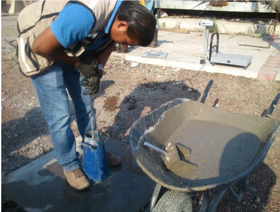
Ilustración 95. Al llegar la primer olla revolvedor, se vacía el concreto fresco en el molde y posteriormente se realiza la prueba de revenimiento, para conocer la consistencia del concreto, dicha prueba se debe efectuar antes y después de la aplicación del aditivo ; el ensaye es realizado por un signatario del laboratorio LACOCS.
