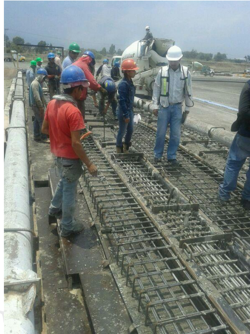
Ilustración 99. En el proceso del colado, las capas de descarga no deben superar los 30cms. de espesor, ni los 30 min. de vaciado entre capa y capa.
