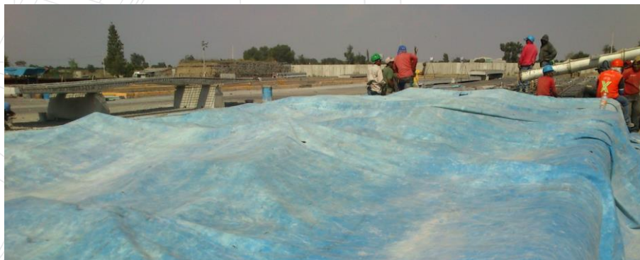
Ilustración 110. Cubiertas las prelosas, sólo superviso que las mismas estén cubiertas al 100%.
