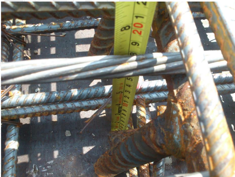
Ilustración 92. Verifico la altura física con la de proyecto; ya que es un factor muy importante, por lo que con ayuda de sargentos de acero garantizan su posición.
