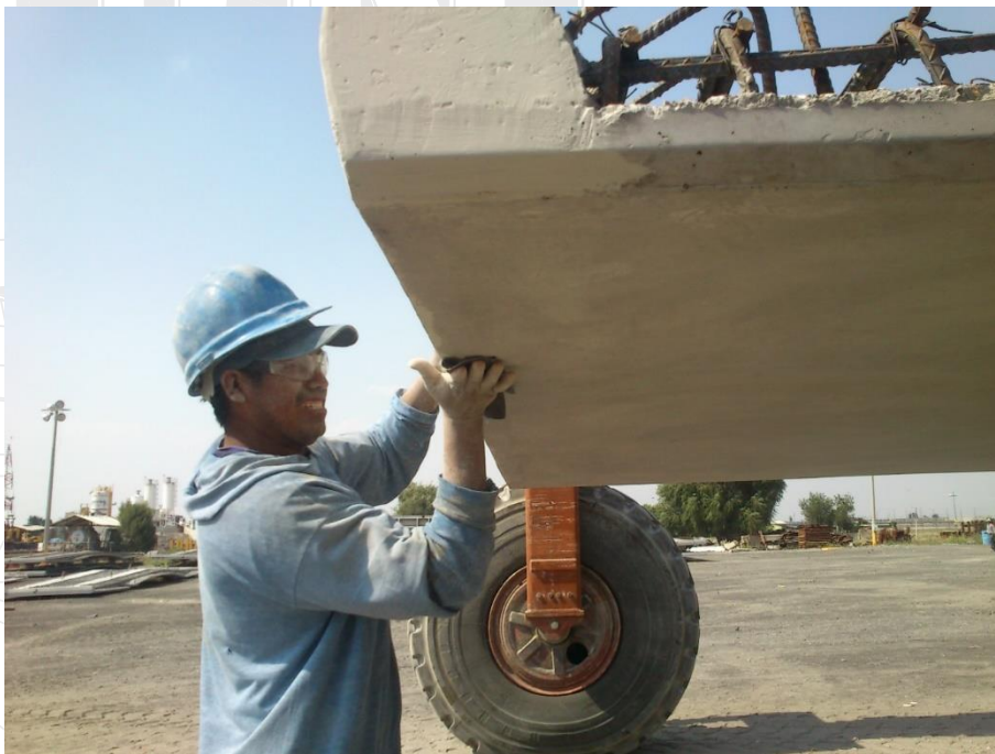
Ilustración 126. Empastado y lijado de la trabe de borde.
