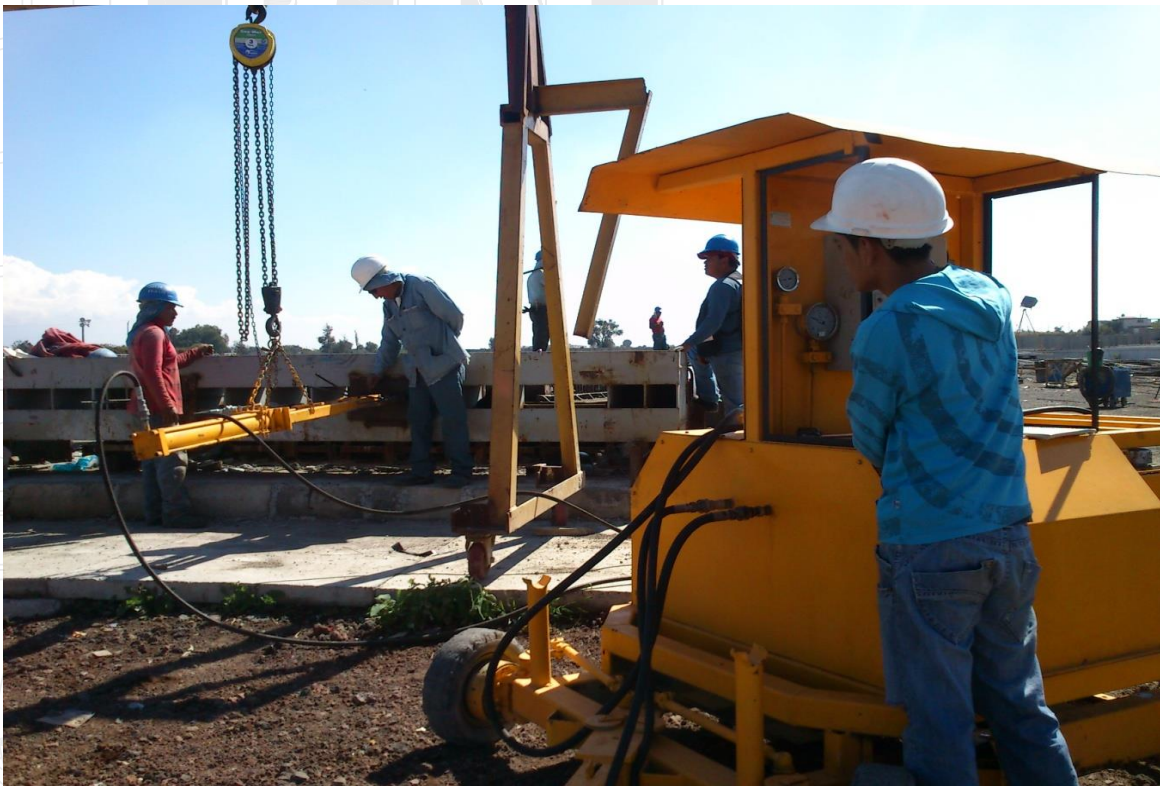
Ilustración 1. Aplicación de carga con gato de tensado tipo monotorón, en tensado del acero de presfuerzo.
