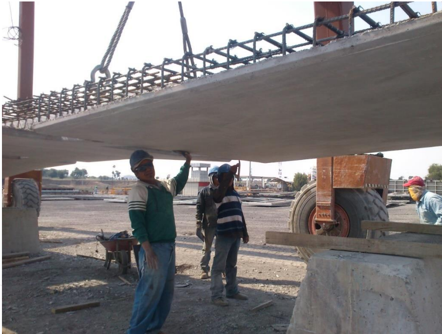
Ilustración 125. Se verifica el acabado aparente en la cara inferior de la losa.
