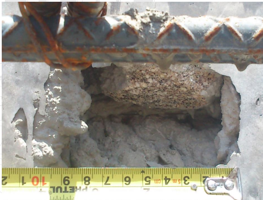
Ilustración 102. Una vez obtenida la resistencia, la falta de retiro de grumos puede causar oquedades, como se muestra en la foto; provocando falta de adherencia del acero de presfuerzo con el concreto.
