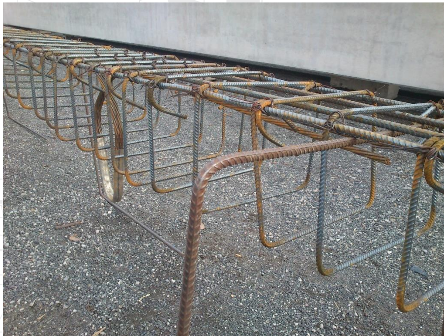
Ilustración 73. Superviso la posición de los ganchos de izaje, las pijas intercaladas de los estribos en la longitud de la nervadura, su desarrollo de habilitado.
