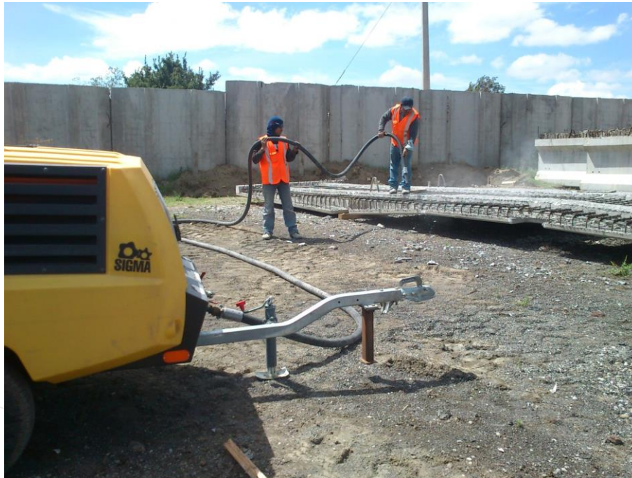
Ilustración 123. Limpieza, para eliminar el cascajo, producto del perfilado de las nervaduras.
