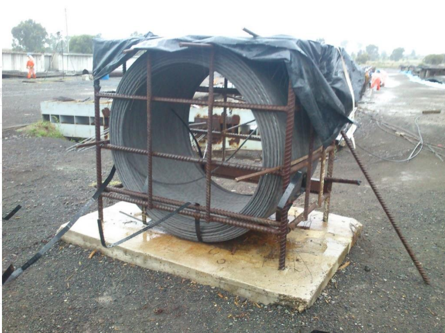
Ilustración 84. El rollo de torón debe estar sobre un firme y cubierto en temporada de lluvias, para evitar la corrosión.
