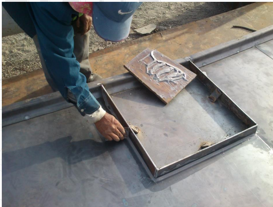
Ilustración 69. Para evitar el acuñamiento del concreto endurecido de la prelosa; la contratista colocaba pasta automotriz, formando un pequeño chaflán entre la base metálica y las soleras metálicas.
