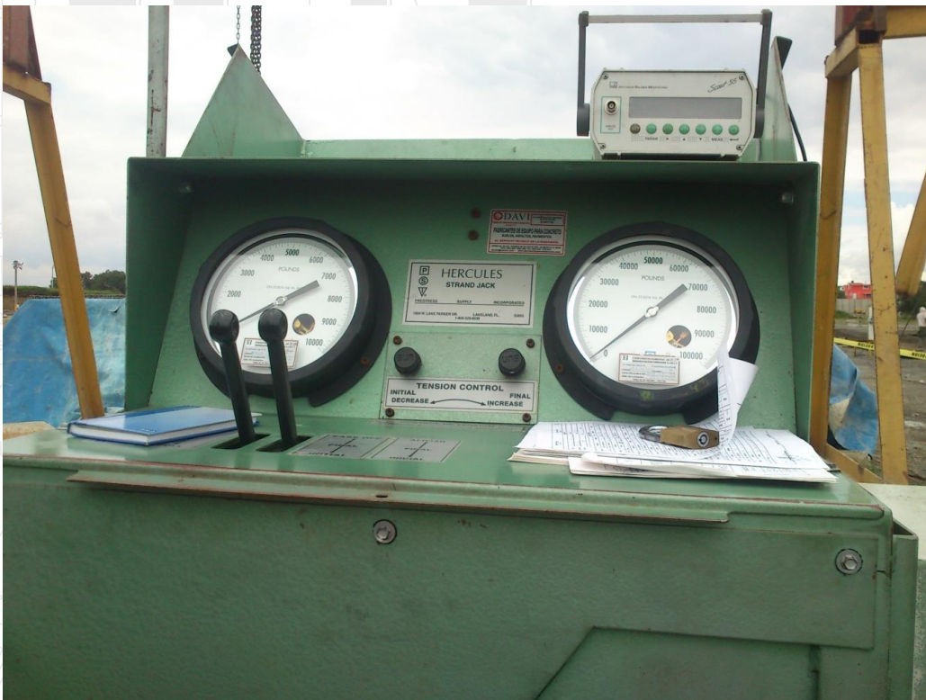
Ilustración 18. Se calibra cada uno de los manómetros y se coloca la etiqueta de calibración.
