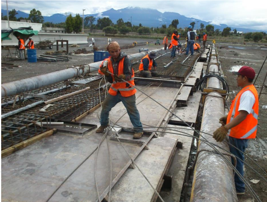
Ilustración 85. Introducción de acero de presfuerzo de 1/2", a las nervaduras del armado.
