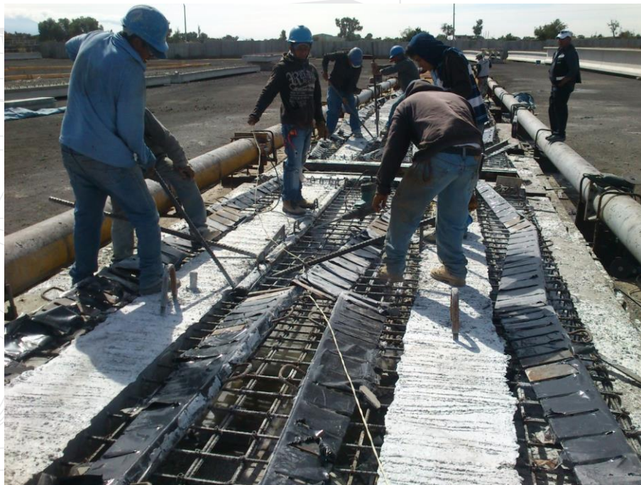
Ilustración 119. Retiro de peines metálicos con barras de acero.
