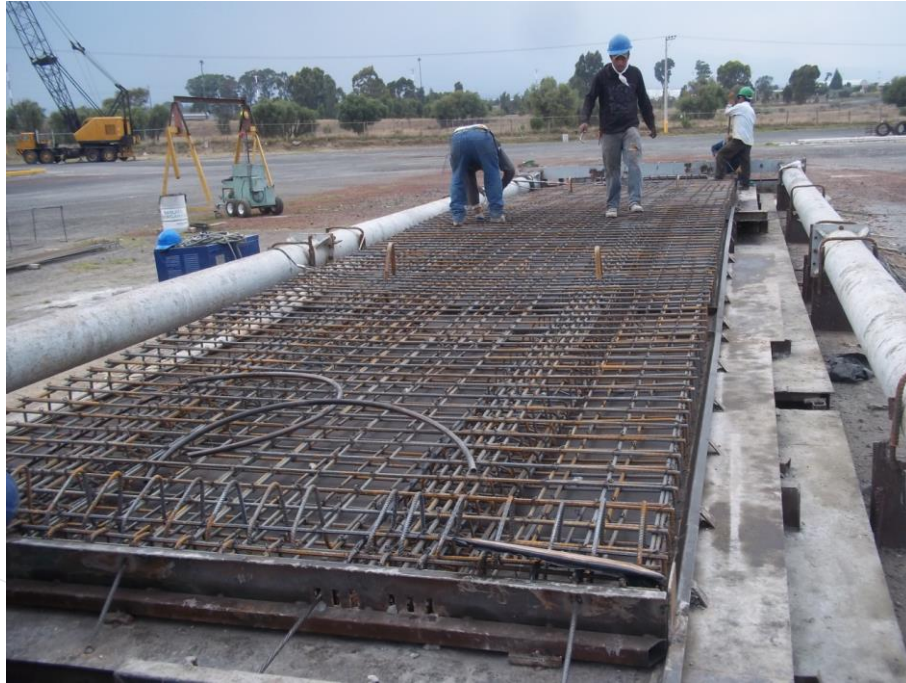
Ilustración 81. Verifico los recubrimientos en la losa.
