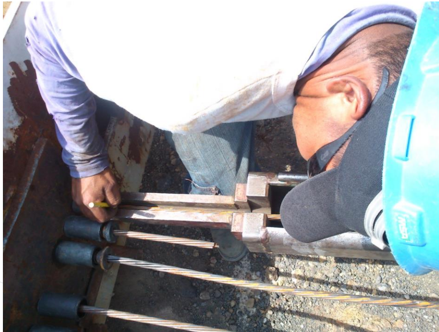
Ilustración 87. Verificación de marca en 5 torones, previo a la aplicación de carga.
