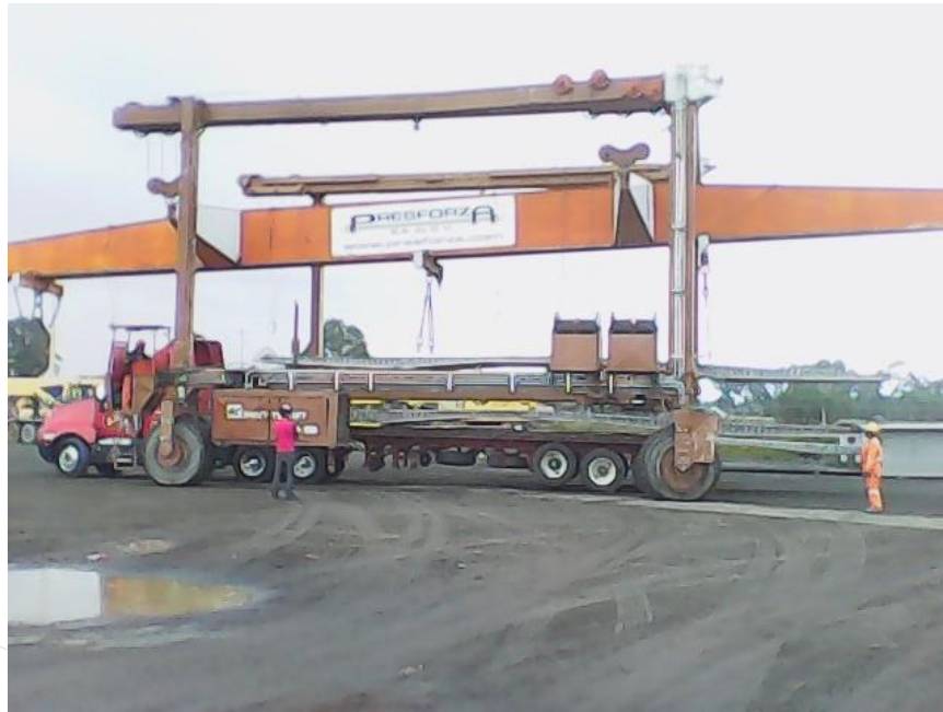
Ilustración 135. Vista lateral de prelosas en el transporte.
