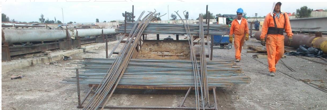
Ilustración 72. Acarreo de acero de refuerzo.
