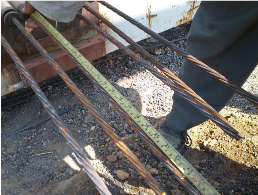
Ilustración 89. Verifico la elongación física con la teórica, una vez aplicada la carga.
