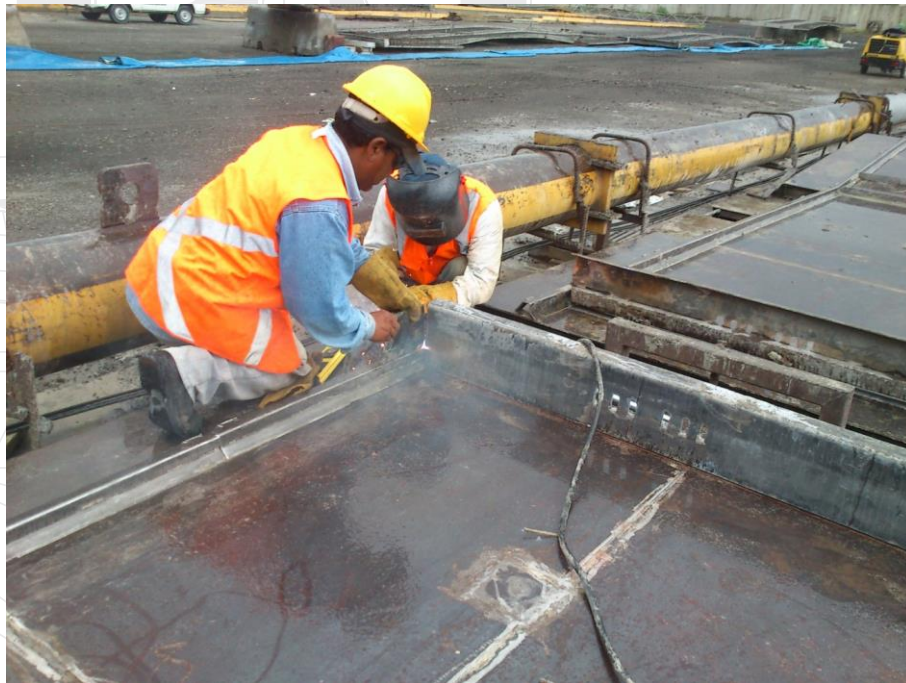
Ilustración 67. Se troquela la cimbra metálica, conforme a trazo.
