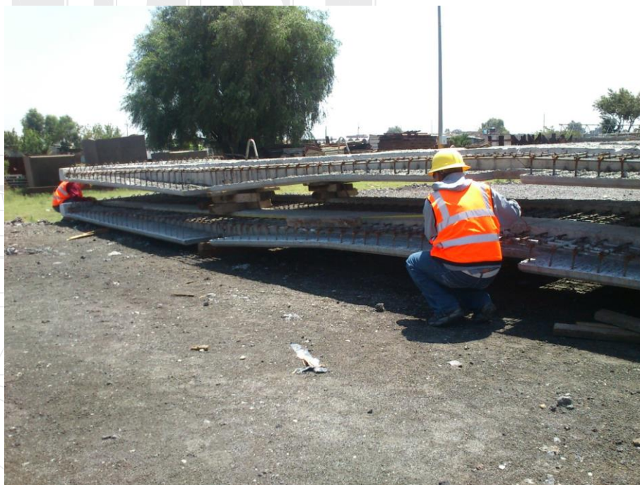
Ilustración 128. Finalmente, topografía realiza un levantamiento, verificando las dimensiones correspondientes de las prelosas, con el plano de fabricación.
