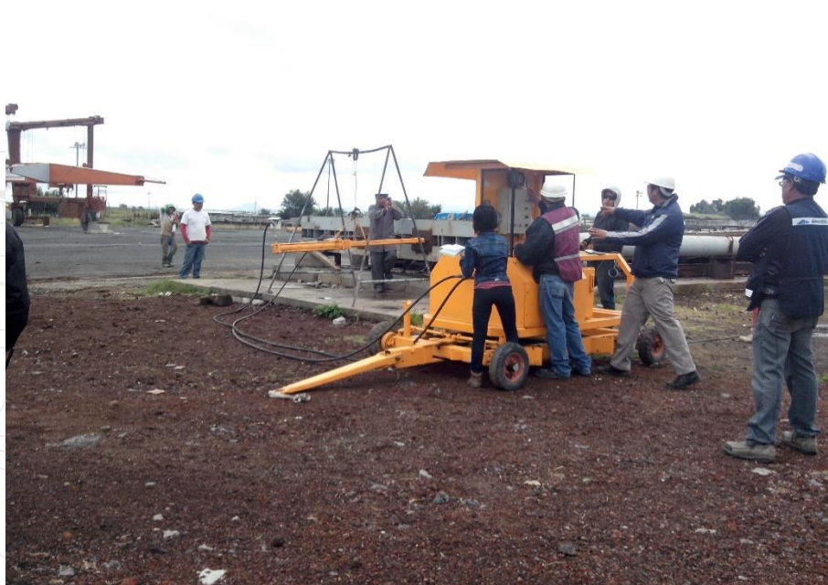
Ilustración 88. Previo al tensado se debe aplicar una carga inicial, con la finalidad de eliminar la catenaria y garantizar que la carga definida en proyecto sea aplicada correctamente sobre el torón.
