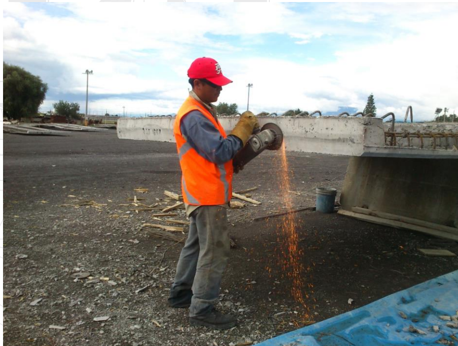
Ilustración 124. Corte de los torones a paño del concreto con disco pulidor para cumplir con lo indicado en las especificaciones de proyecto.
