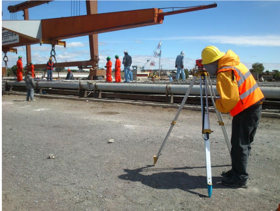
Ilustración 118. Finalmente se verifica topográficamente.
