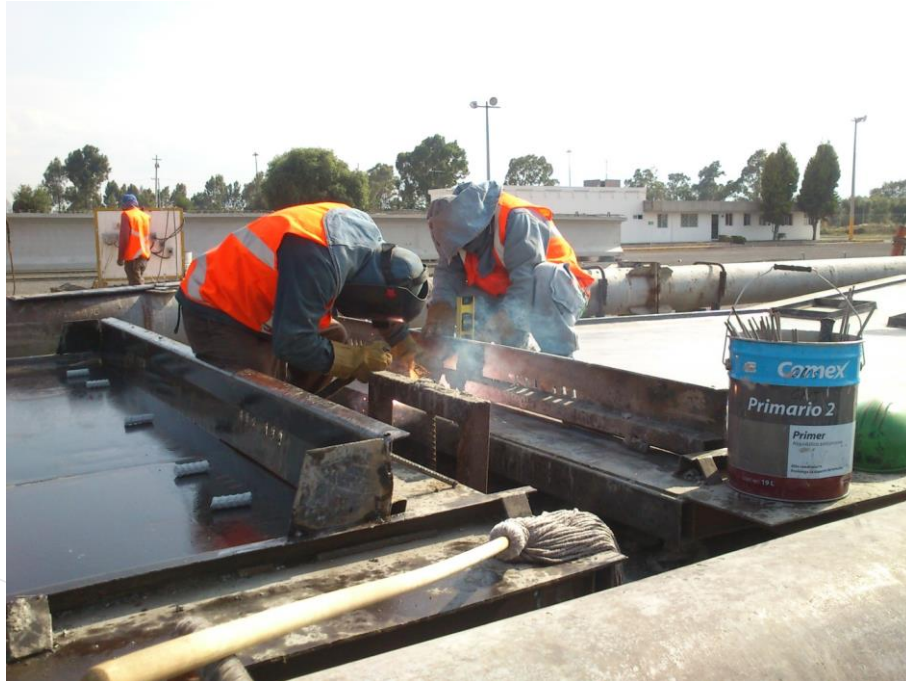
Ilustración 68. Troquelado de fronteras metálicas.
