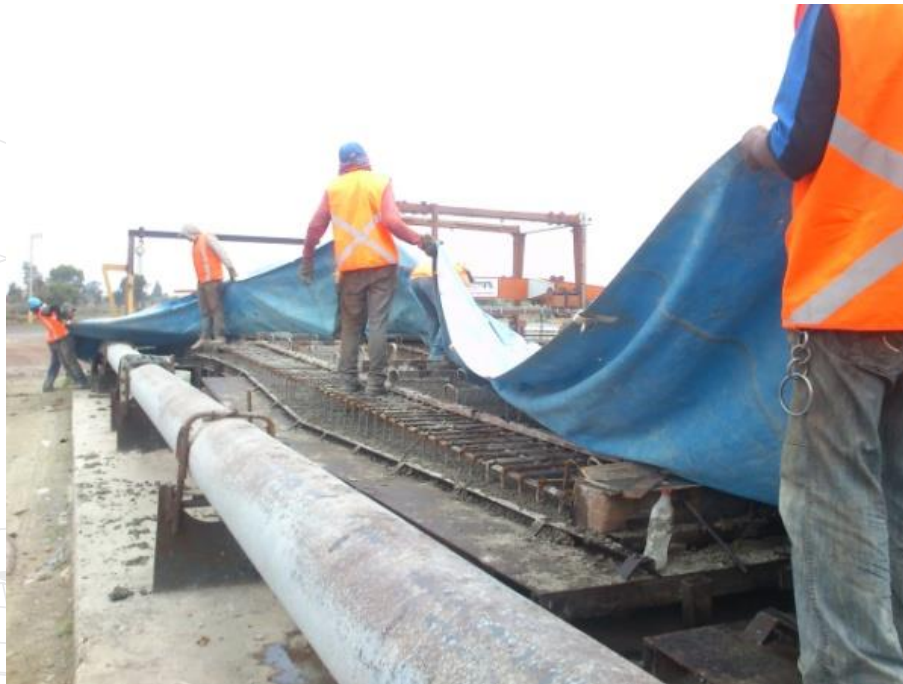
Ilustración 109. Se observa la colocación de la membrana.
