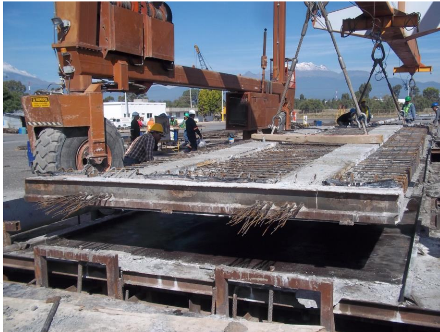
Ilustración 120. Se realizan las extracciones con grúa pórtico con capacidad de 90Ton.
