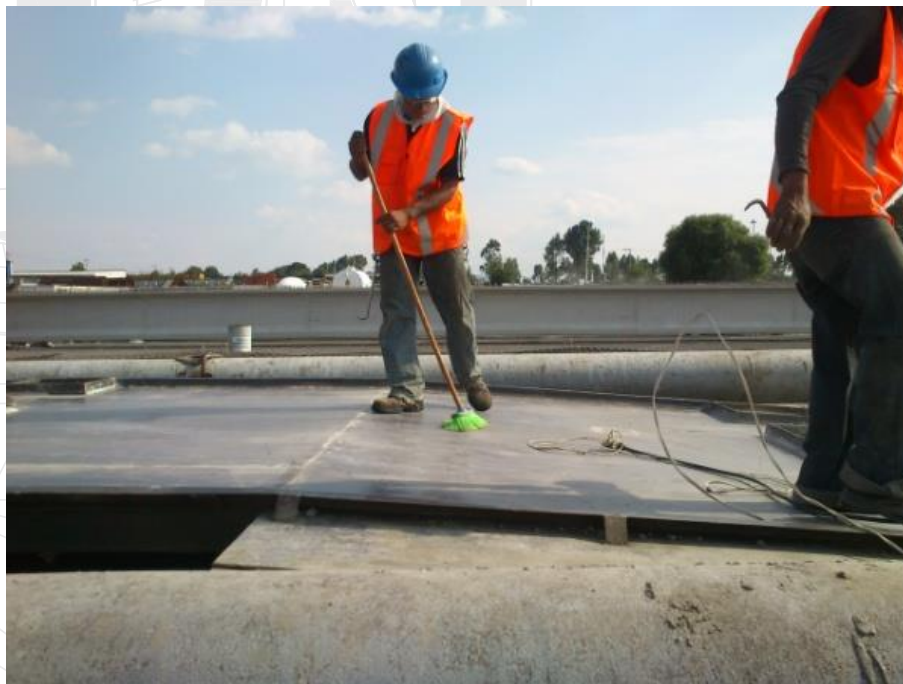
Ilustración 65. Superviso la limpieza básica del molde.
