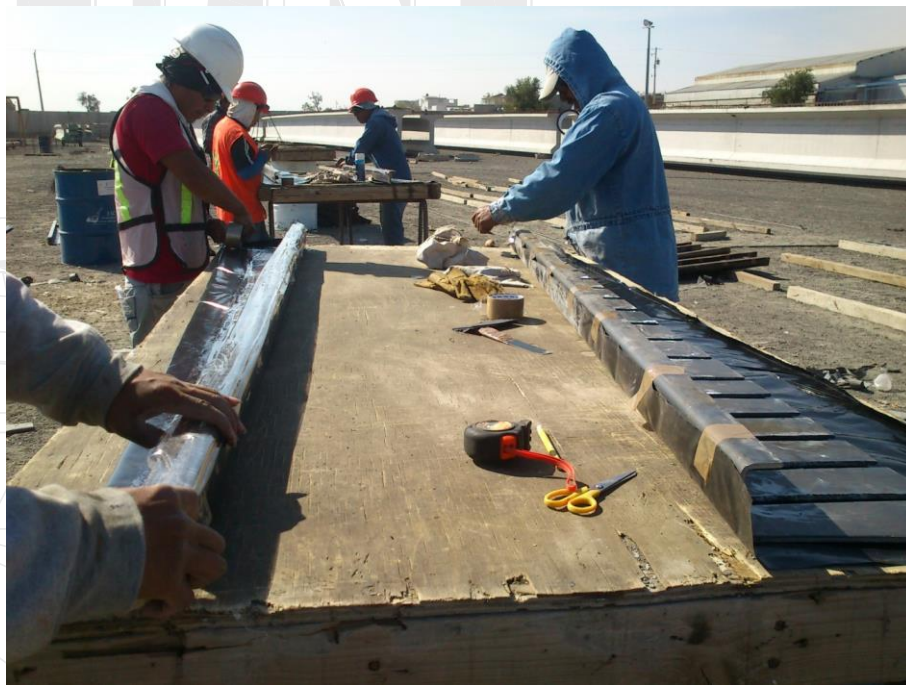
Ilustración 82. Para evitar que la cimbra metálica (peines metálicos) se adhiera al concreto y facilitar su descimbrado, recomiendo forrar los mismos con polietileno.
