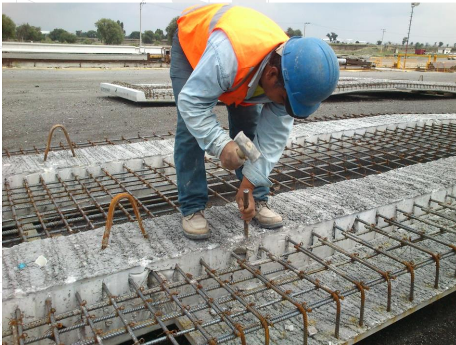
Ilustración 122. Superviso el perfilado de las nervaduras, realizado con herramienta menor, para no dañar las mismas.
