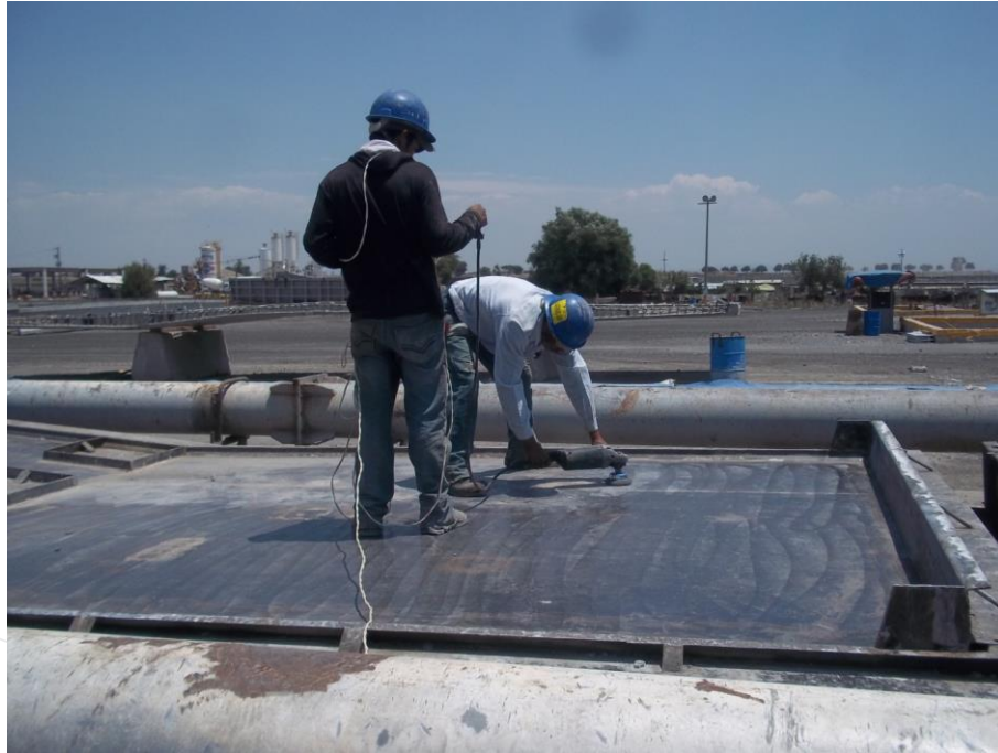
Ilustración 66. Verifico el cardeo de toda la superficie del molde, para eliminar la oxidación y partículas que se le puedan adherir durante la fabricación y eliminación de puntos de soldadura que interrumpen el acabado aparente de las prelosas.
