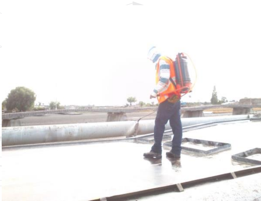
Ilustración 78. Verifico la aplicación del desmoldante; se realiza con aspersor para evitar el acumulado del mismo en las esquinas de las pendientes del molde.
