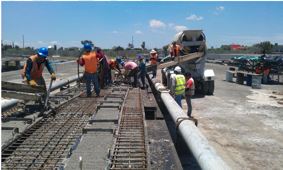
Ilustración 106. El acabado debe ser rugoso aproximadamente de 6mm de profundidad; en las áreas de contacto donde posteriormente habrá colado en obra.
