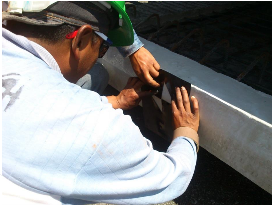
Ilustración 127. Rotulación del eje de la prelosa.
