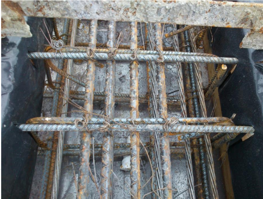
Ilustración 91. Finalmente superviso la trayectoria de los torones, los cuales deben estar libres, para que trabajen correctamente en adherencia al concreto en su vida de servicio.
