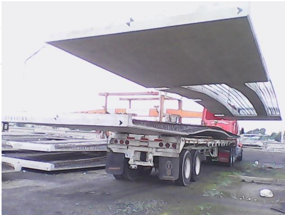
Ilustración 134. Supervisión de carga de prelosas.
