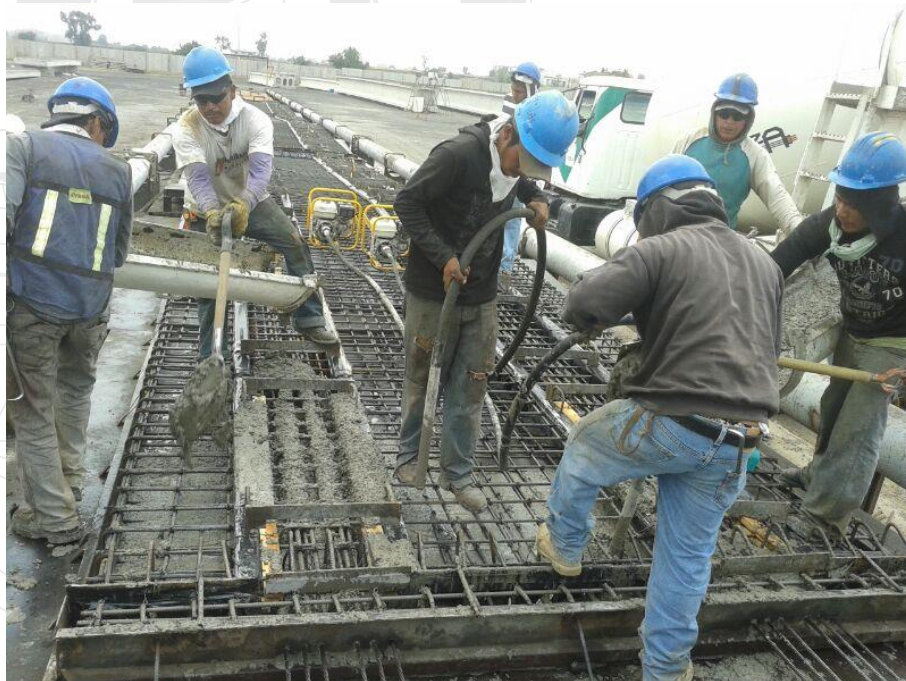
Ilustración 100. Para facilitar el acomodo del concreto, los trabajadores usaban vibradores de inmersión, durante mi supervisión verificaba que su uso fuera usado de manera vertical, como se muestra en la foto y sin abusar del tiempo en la misma sección, para evitar la segregación del concreto.
