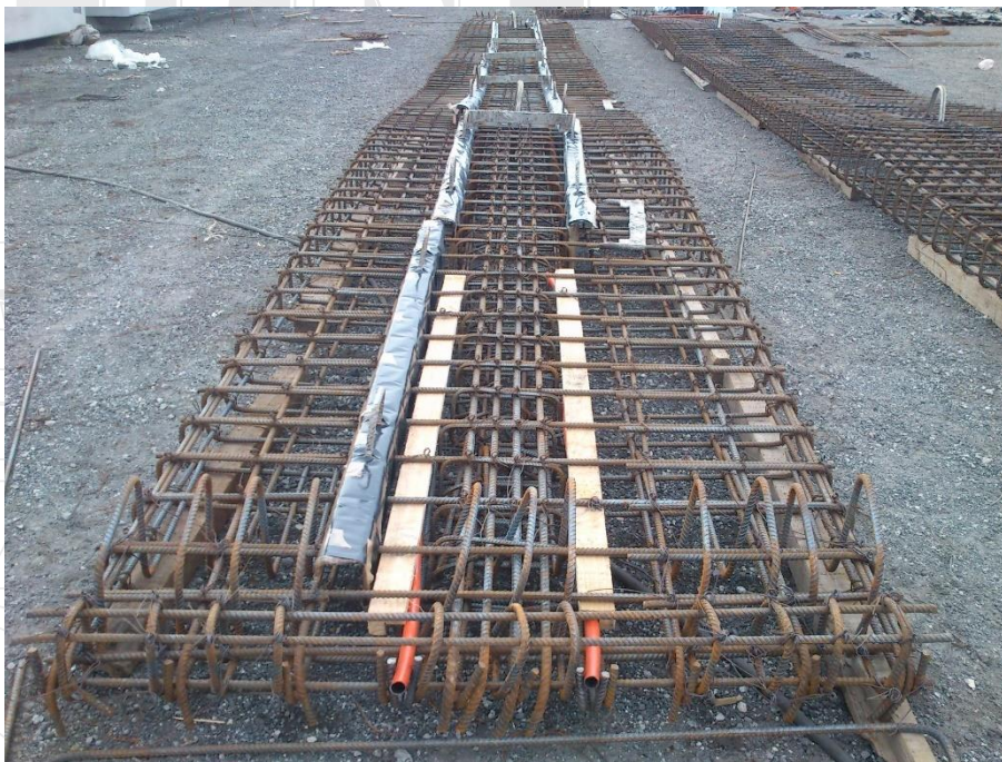
Ilustración 77. Verifico la longitud del engrase o enductado para el paso de los torones.
