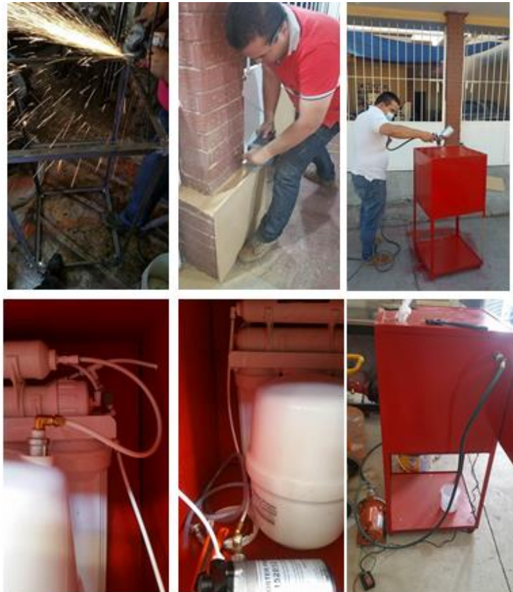
Figura 26. Construcción de la cubierta del dispositivo de ósmosis inversa.
