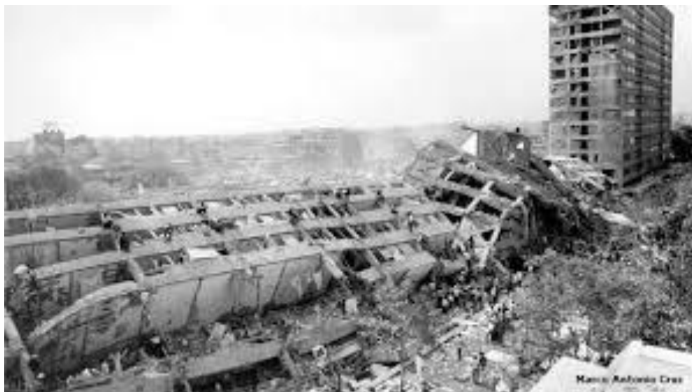
Figura 1.3.: Edificio Nuevo León en Tlatelolco, destrozado por el sismo de 1985.
