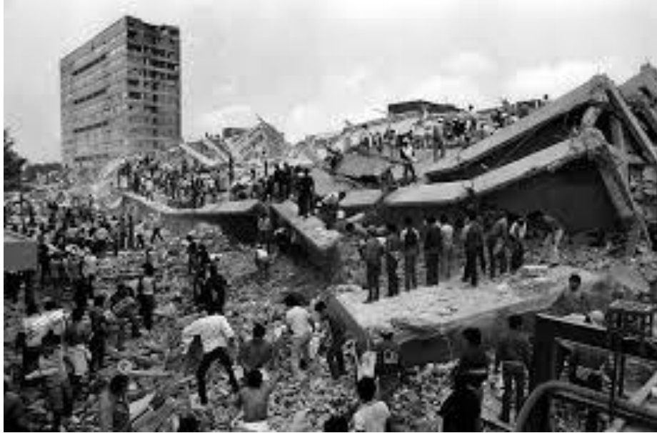
Figura 1.1: Destrucción Edificio en Tlatelolco, en el sismo de 1985.
