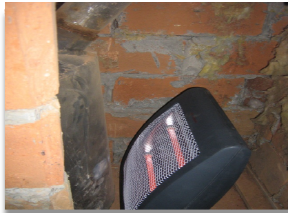
Figura 2.21 interior del cubo de ladrillo con la ubicación del calentador de cuarzo a un costado del Biodigestor.
