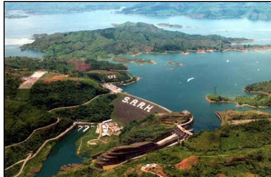
Figura A.4 Central de Malpaso
