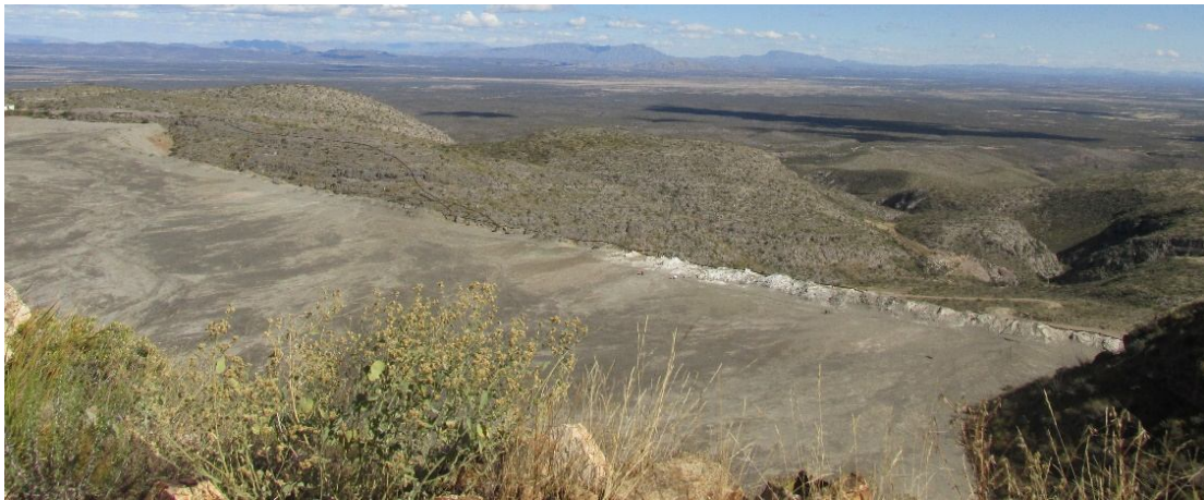
Figura 4.4 Vista de "aguas arriba" de la cortina del depósito actual. Flopac, 2015a.
