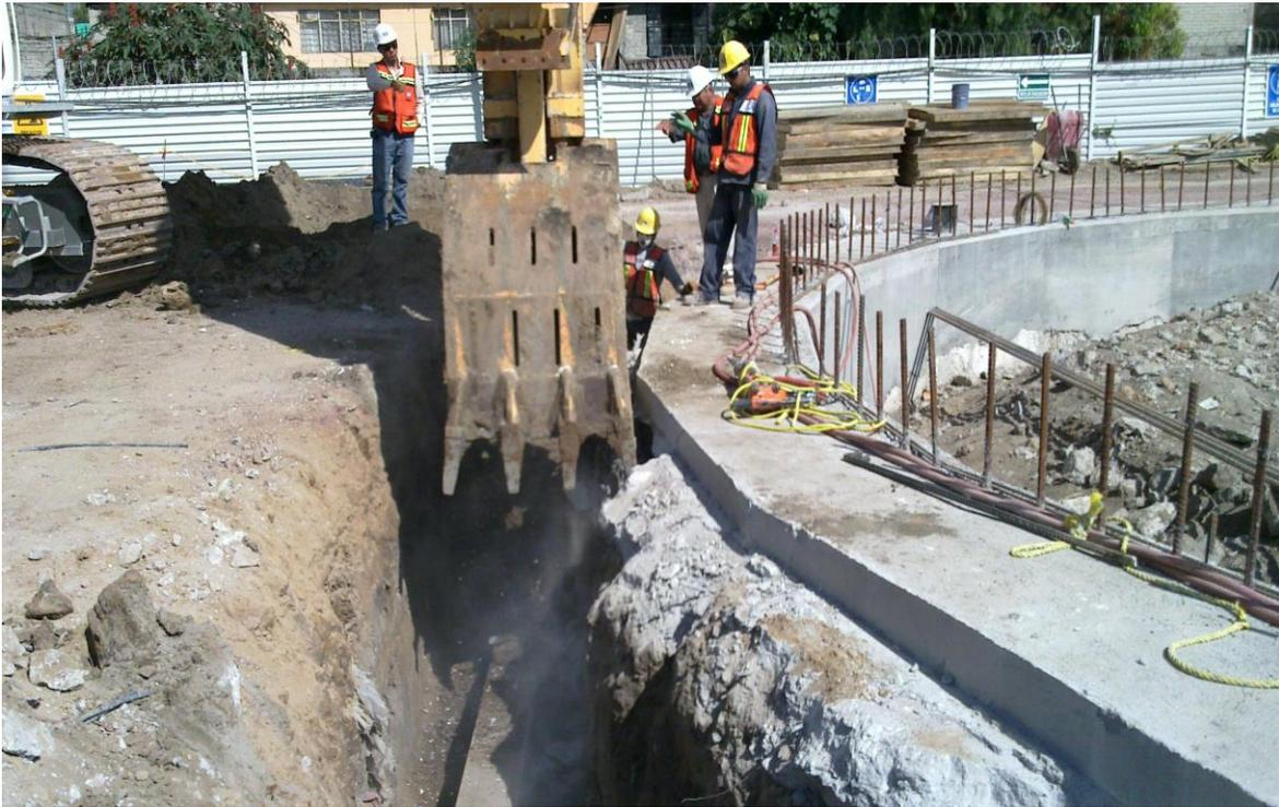
**Fig.3.21. Retiro y Demolición del Brocal Exterior L3-A**
