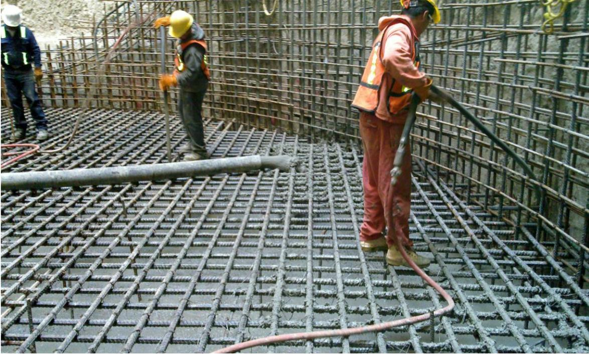
**Fig.5.9. Vibrado Para La Colocación De Concreto De La Losa De Fondo L3-A**
