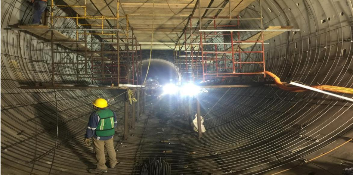
**Fig.10.3. Armado De Acero De Refuerzo Primer Lecho Cubeta Para El Revestimiento Definitivo De Túnel L3 A L3-A**
