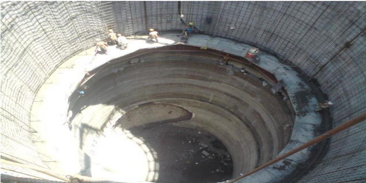
**Fig.6.3. Colado Del Revestimiento Definitivo Con Cimbra Deslizante En L3-A
