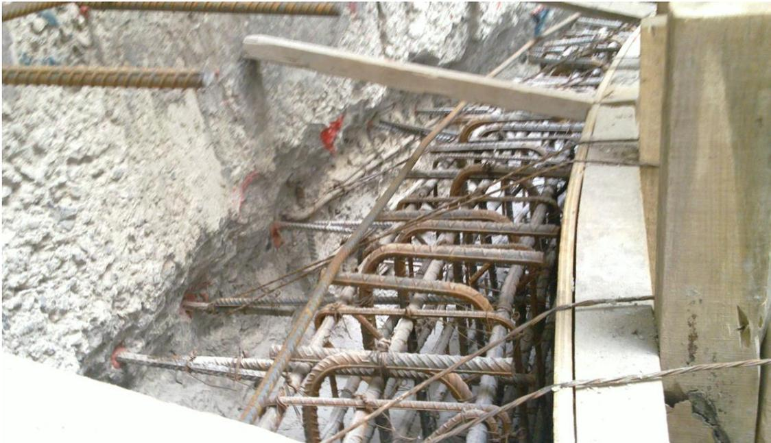
**Fig.5.4. Anclaje Del Muro Milán Con El Acero De Refuerzo Del Anillo De Rigidez
