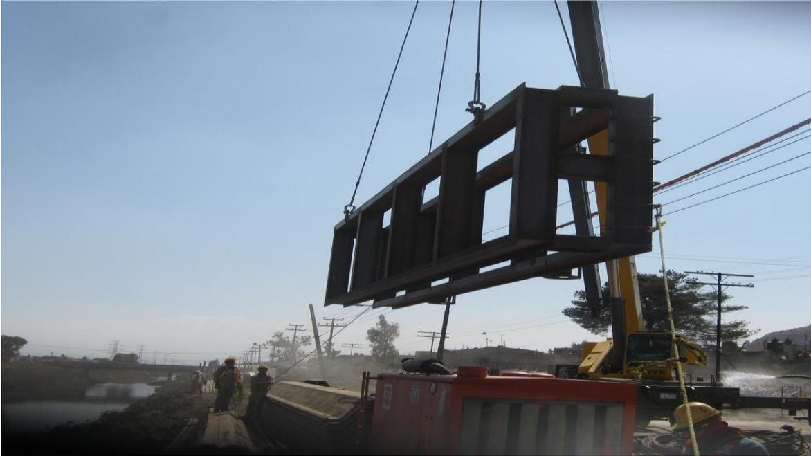
**Fig.2.6. Izaje Para La Colocación De Escantillón Para El Hincado De Tablestaca
