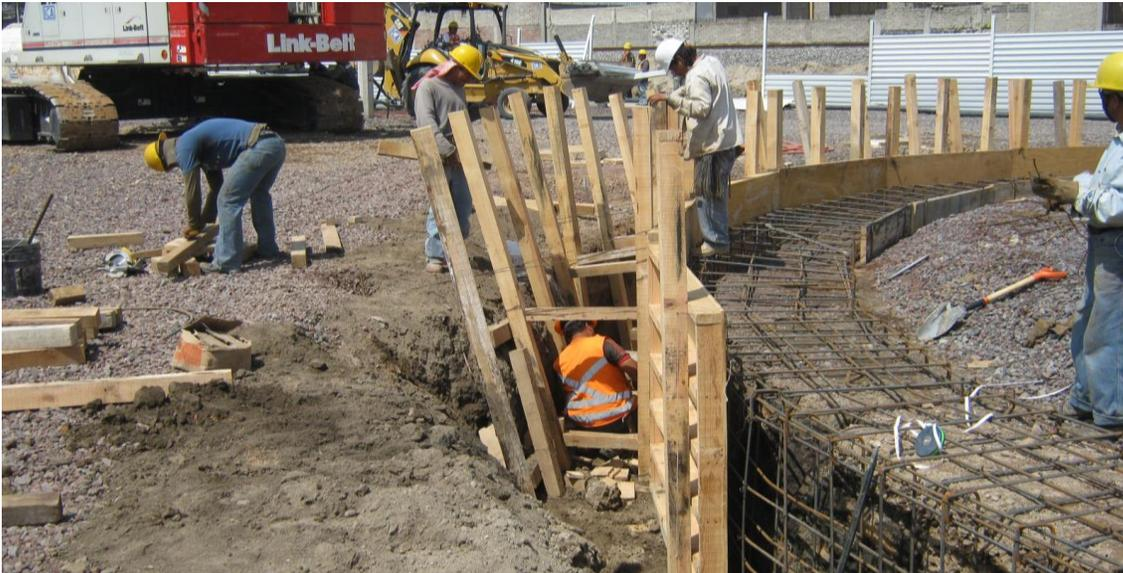
**Fig.3.6. Colocación De Cimbra En Brocal Interior**
