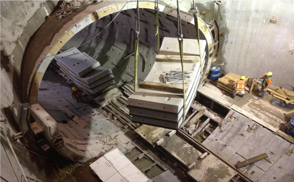
**Fig.8.14. Descenso De Dovelas Al Fondo De Lumbra 3 Para Su Traslado Al Frente De Trabajo Fuente. Lumbra 5 Túnel Emisor Oriente**
