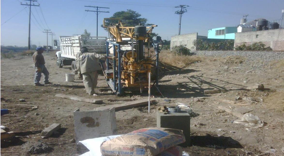
**Fig.11.1. Instalación De Piezómetro En Superficie De Lumbrera 3-A Antes Del Inicio De Los Trabajos
