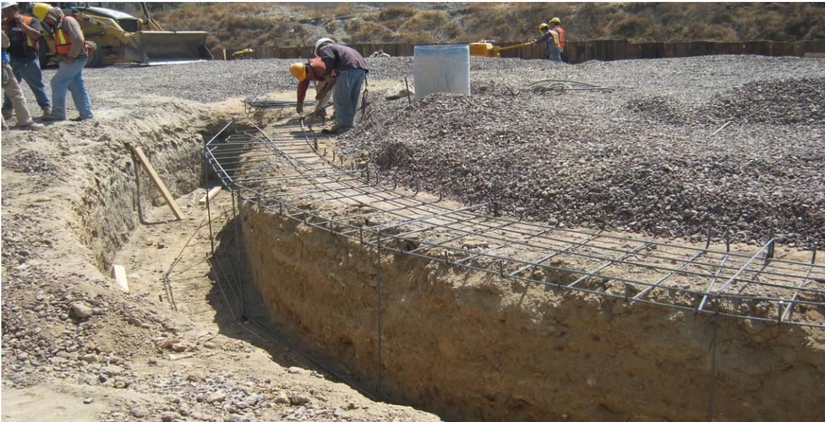
**Fig.3.5. Armado De Acero De Refuerzo Para Brocal Interior L3-A
