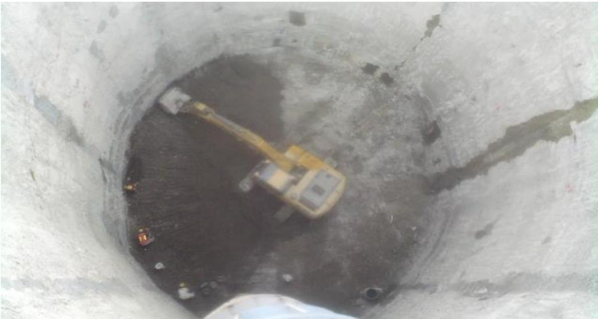
**Fig.5.2. Planta, Excavación Del Núcleo De Lumbrera 3-A
