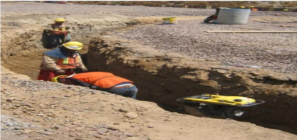
**Fig.3.3. Compactación De Plantilla En Excavación Para La Construcción De Brocales En L3-A
