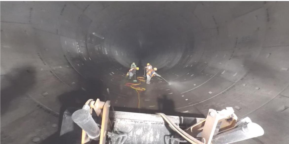
**Fig.10.1. Limpieza Fina Del Revestimiento Primario Del Túnel
