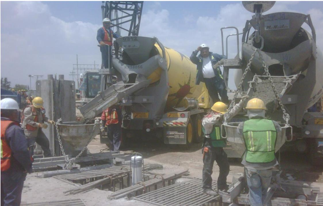
**Fig.3.19. Colado Con 2 Líneas De Tubería Tremie Para Muro Milán L3-A
