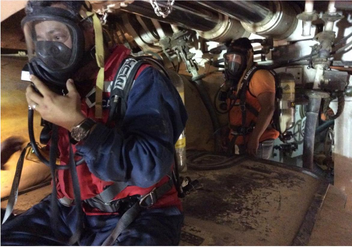
**Fig.12.3. Verificación De Niveles De Oxígeno Y Gas En El Frente De Excavación Por Medio De Equipo De Respiración Autónomo**
