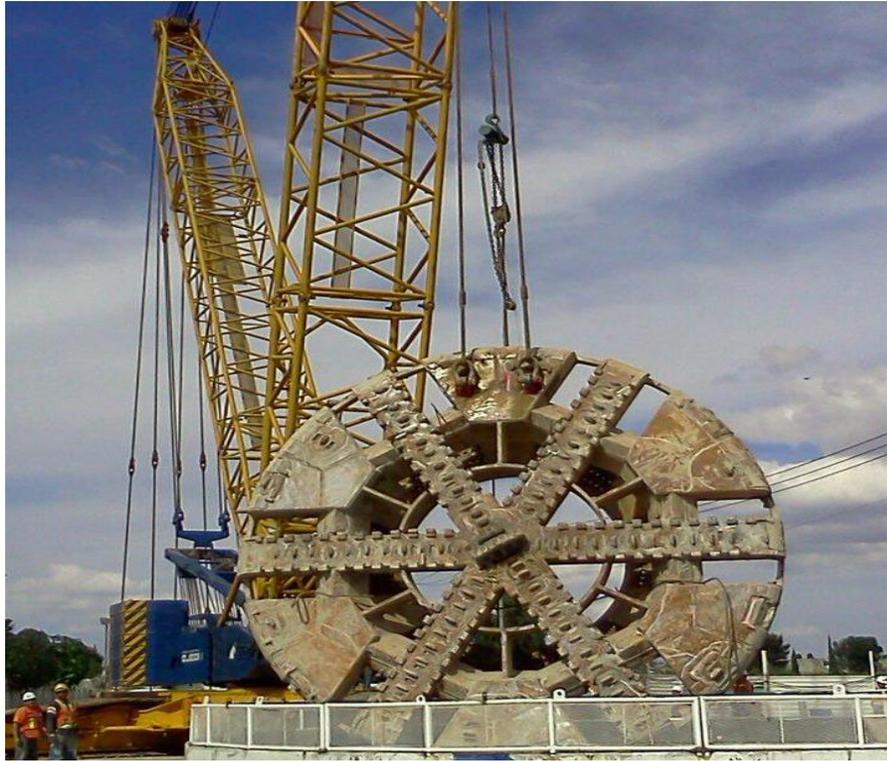
**Fig.9.4. Extracción De La Rueda De Corte Del Escudo Robbins Morelos
