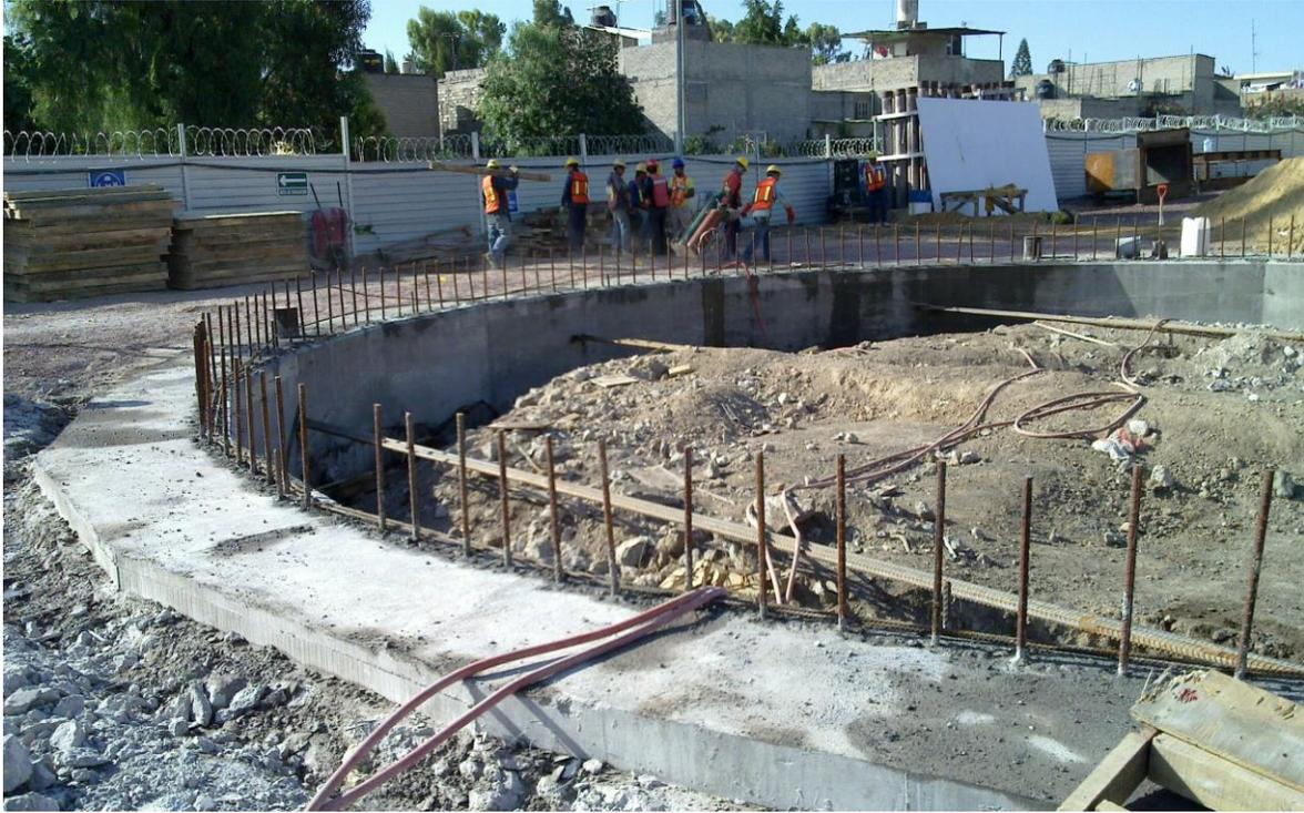
**Fig.3.23. Trabe de Coronamiento L3-A**
