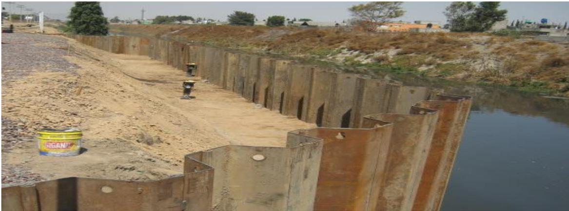
**Fig.2.11. Relleno Y Compactado Para Mejoramiento De La Plataforma De Trabajo Fuente. Lumbrera 5 Túnel Emisor Oriente.**
