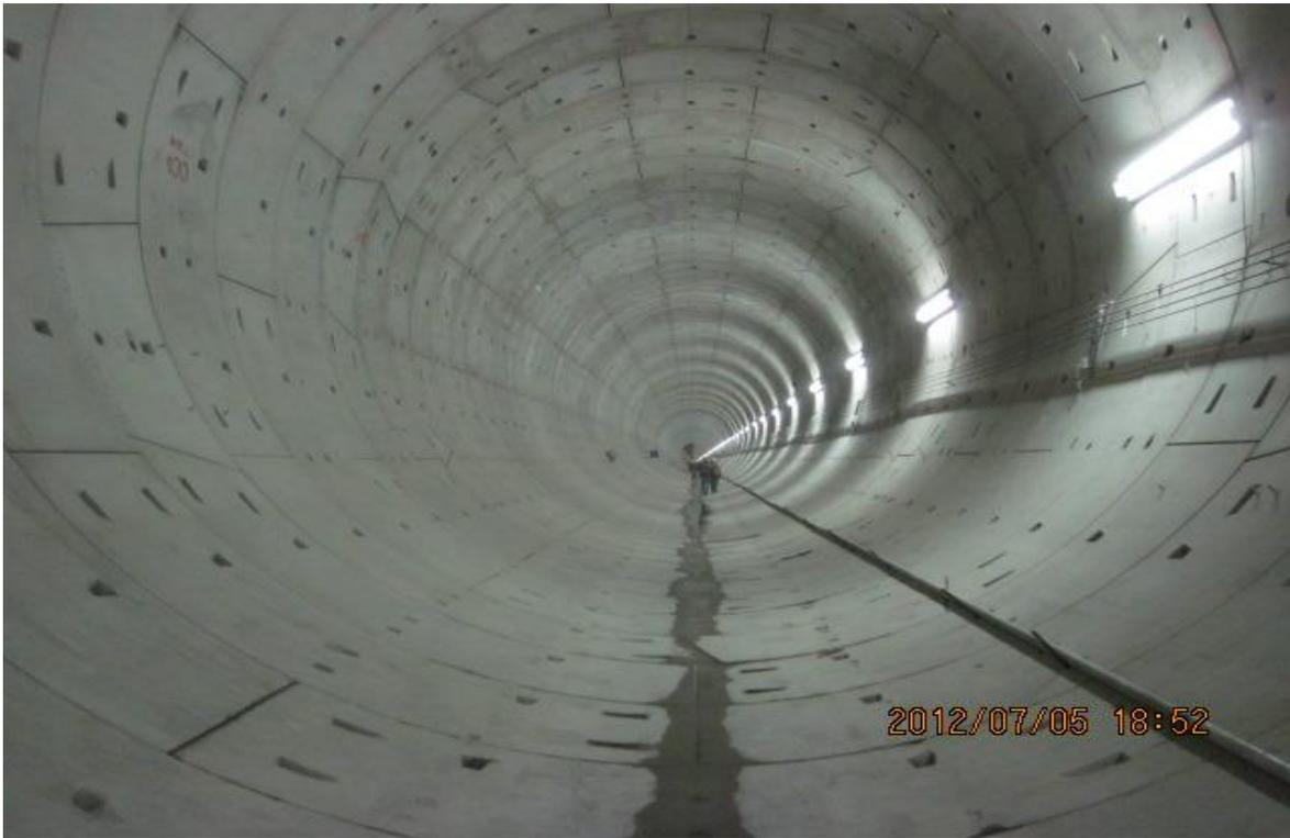
**Fig.10.12 Revestimiento Primario, Endovelado.**
