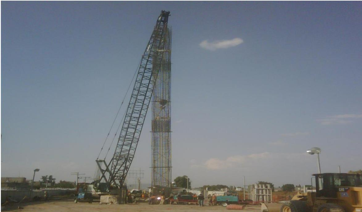
**Fig.3.18. Izaje De Armado De Acero De Refuerzo Para Muro Milán De L3-A
