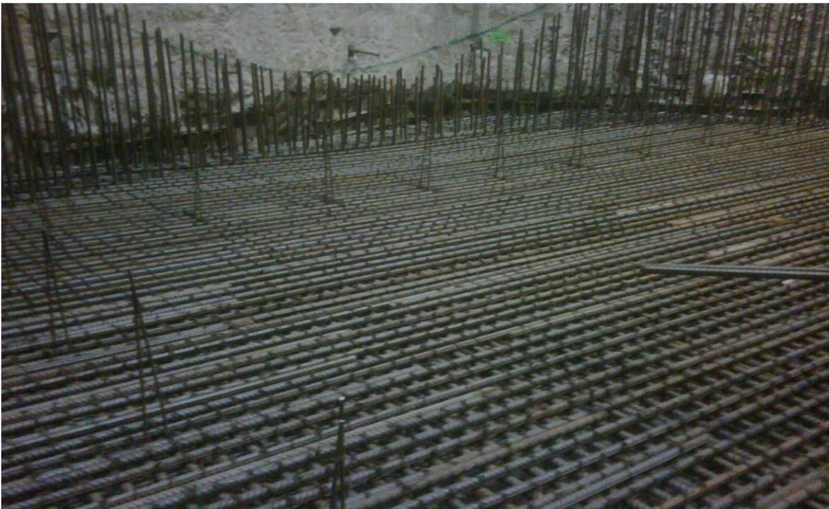
**Fig.5.6. Armado De Acero De Refuerzo Losa De Fondo L3-A
