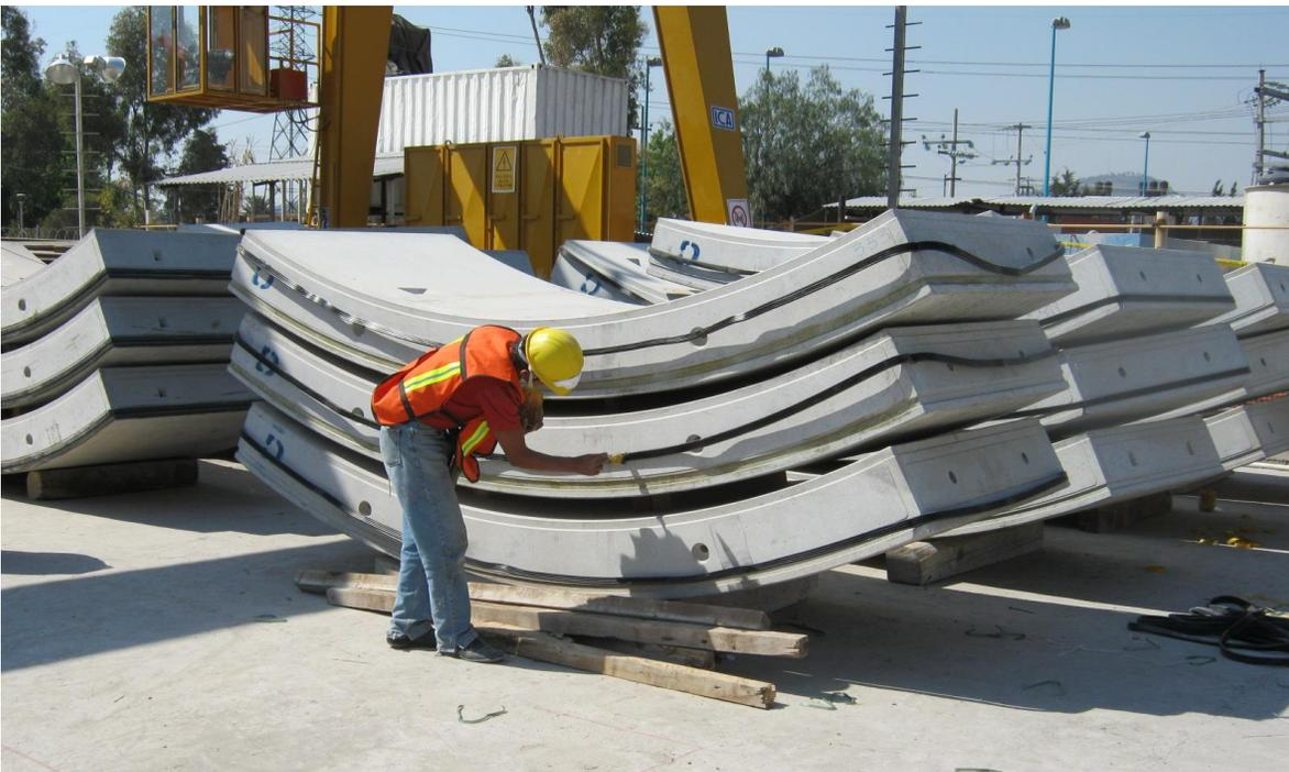
**Fig.8.15. Colocación de Juntas de Estanqueidad en el Endovelado. Fuente. Lumbra 5 Túnel Emisor Oriente**
