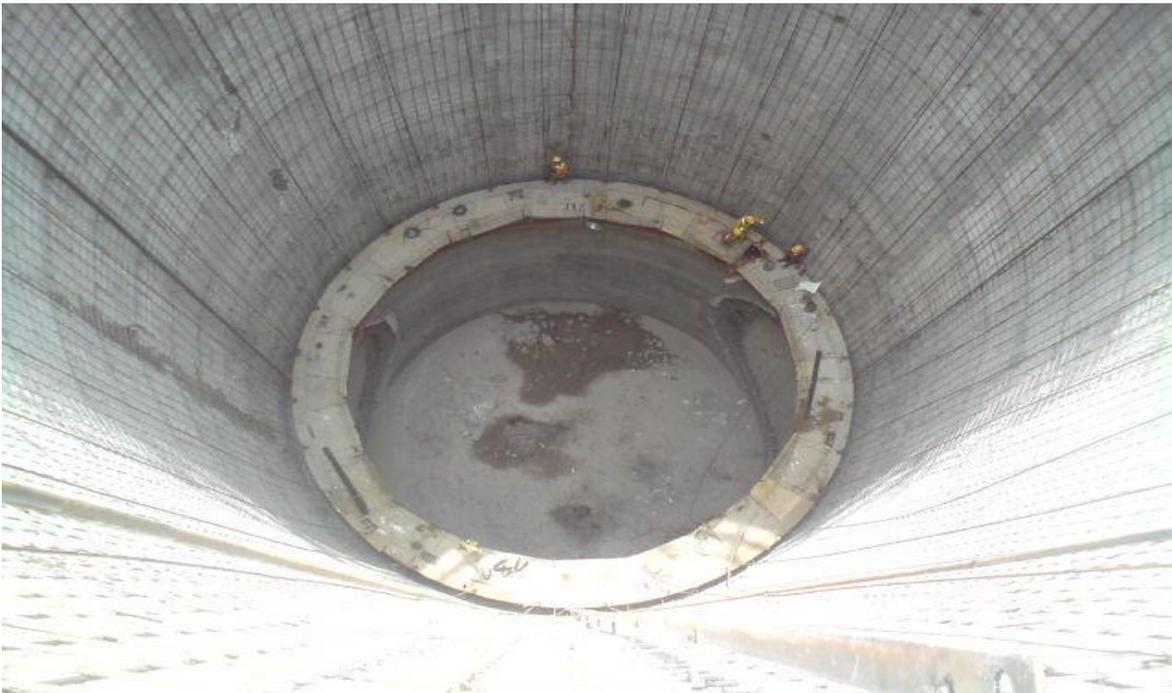
**Fig.6.1. Planta, Armado De Acero De Refuerzo Del Revestimiento Definitivo De L3-A**
