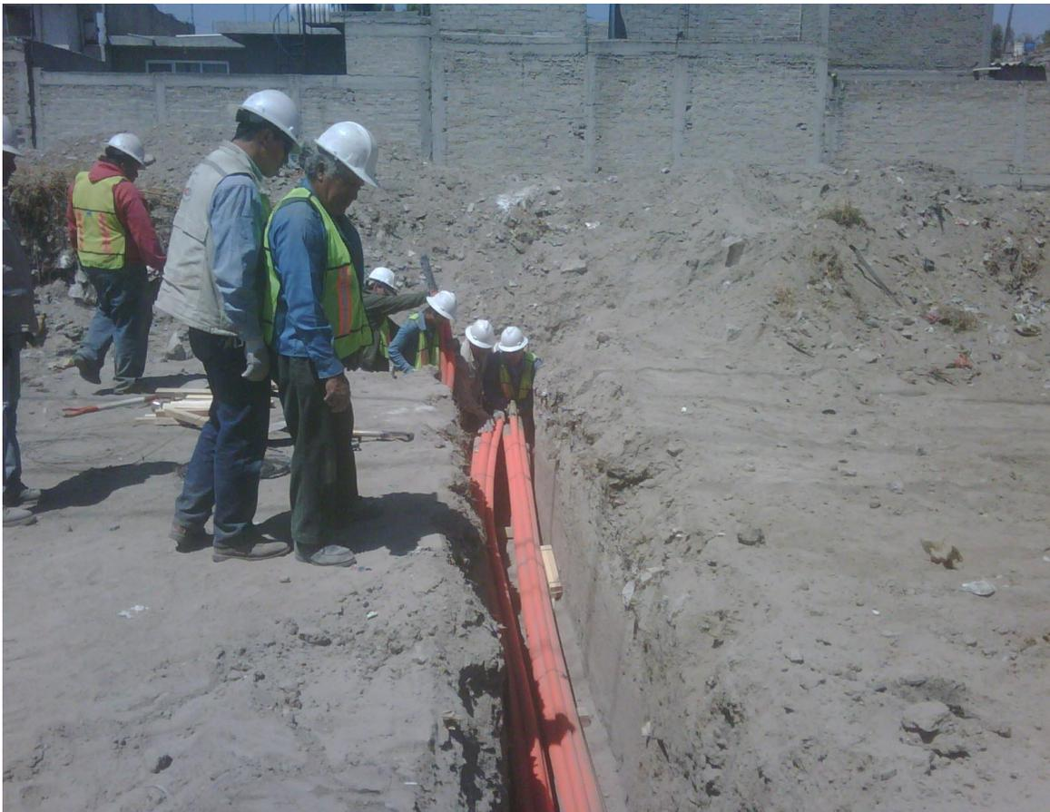
**Fig.2.3 Canalización Para Desvío De Líneas Eléctricas**
