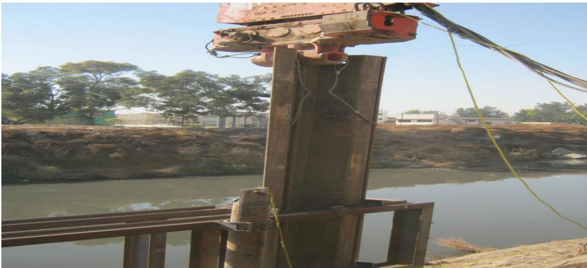
**Fig.2.8. Hincado De Tablestaca En Talud**
