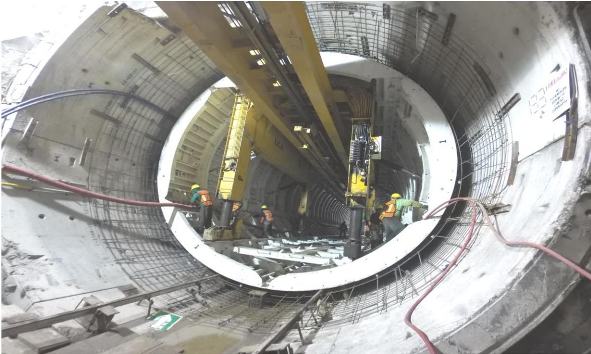
**Fig.10.6. Cimbrado De Clave De Túnel Para Revestimiento Definitivo L3 A L3-A
