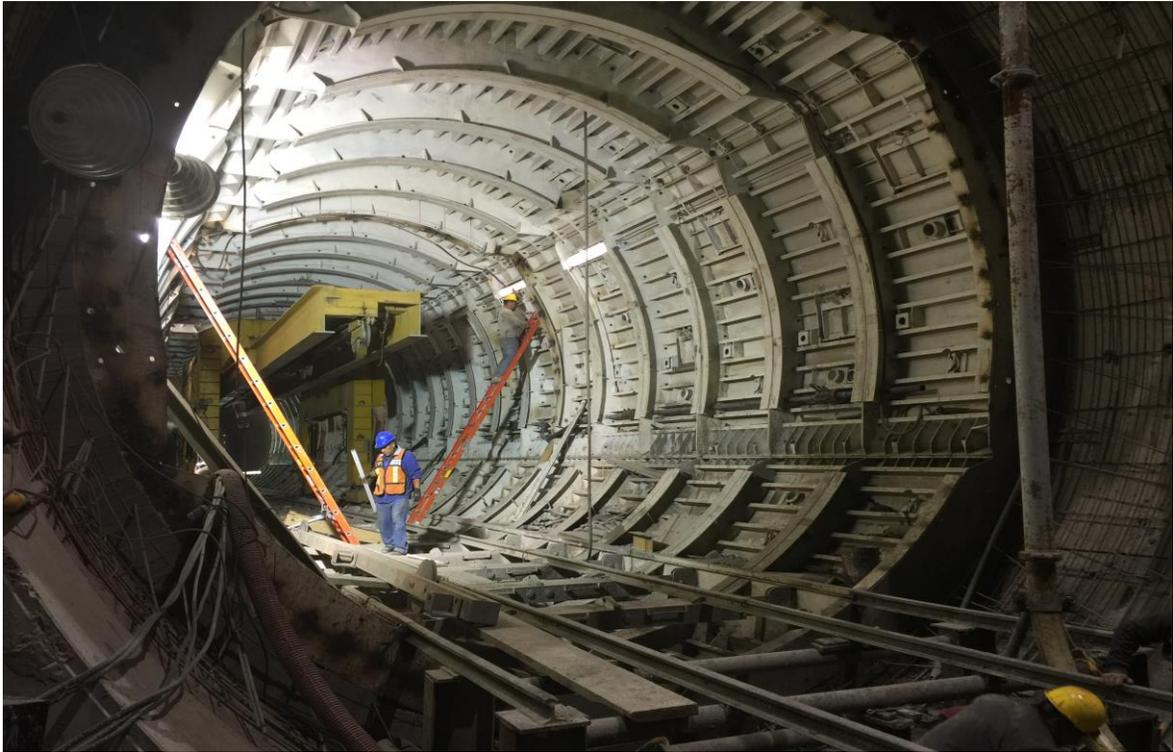
**Fig.10.10 Vista Interior de la Cimbra Metálica Durante Los Trabajos Complementarios**
