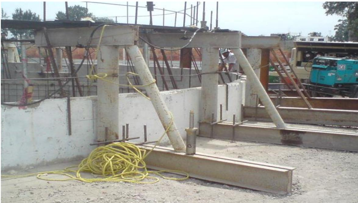
**Fig.6.2. Estructura De Soporte De Gatos Hidráulicos En Superficie De Lumbra**
