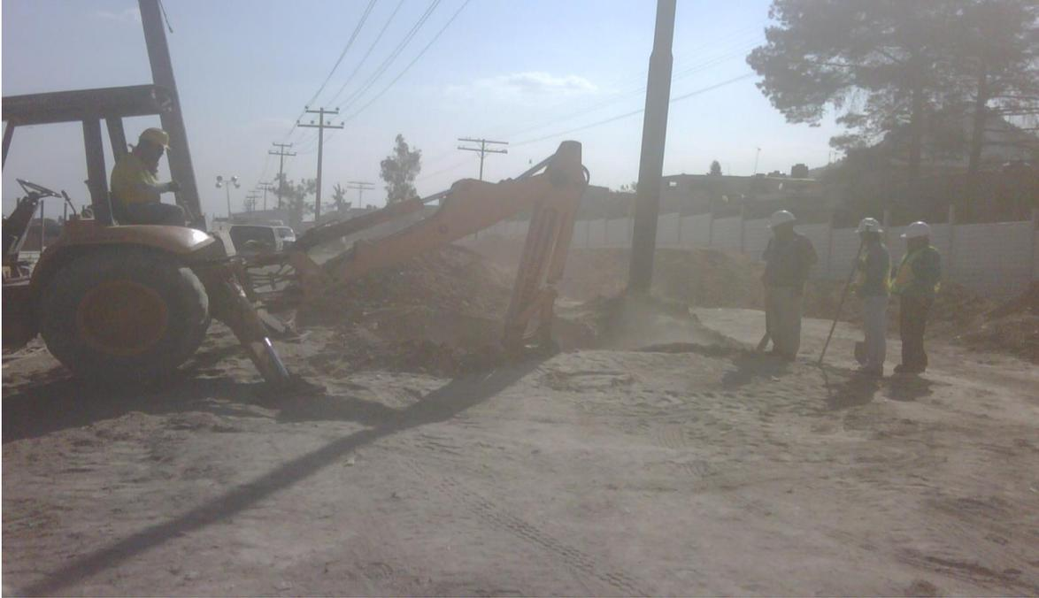
**Fig.2.5. Excavación Para Reubicación De Poste De Alta Tensión
