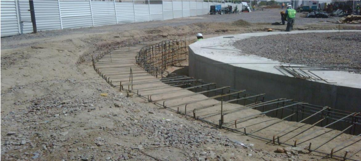
**Fig.3.9. Armado De Acero De Refuerzo Del Brocal Exterior L3-A**
