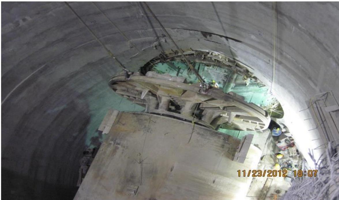
**Fig.9.5. Extracción De La Rueda De Corte Del Escudo Hk-S497
