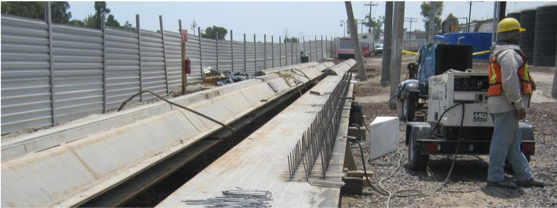
**Fig.3.16. Colocación De Clavos En Junta Metálica**
