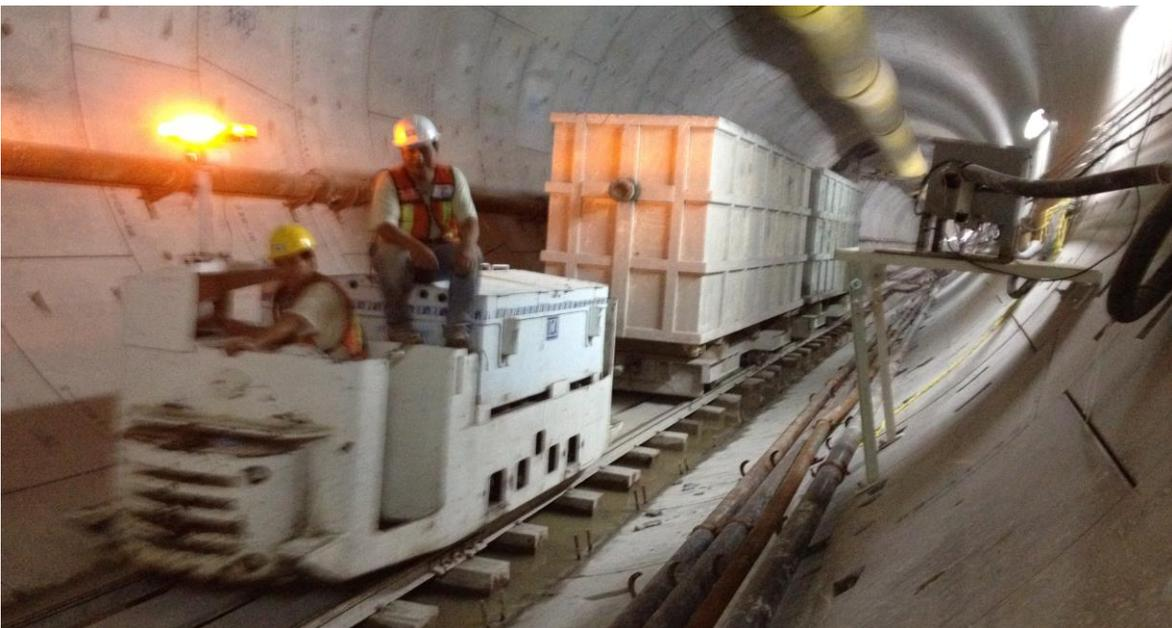
**Fig.8.9. Traslado De Material De Rezaga Por Medio De Vagonetas Al Fondo De Lumbrera**
