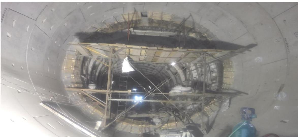
**Fig.10.8. Vista De Cimbra Tapón Al Final Del Módulo No 5 De La Cimbra Metálica**
