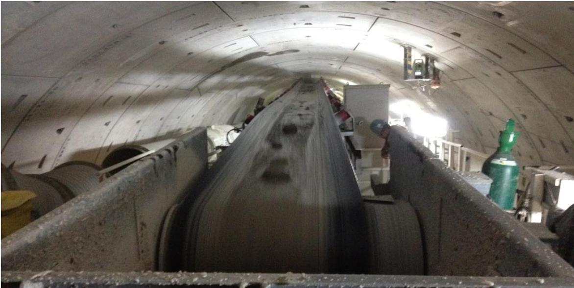
**Fig.8.8. Rezagado De Material De Excavación Por Medio De Banda De Transporte**
