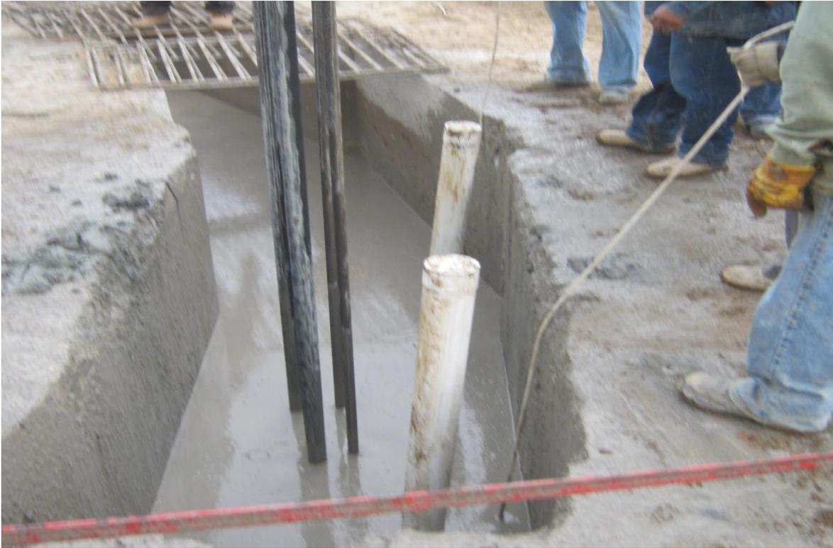
**Fig.3.15. Verificación De Verticalidad De La Excavación Por Medio De Boyas**
