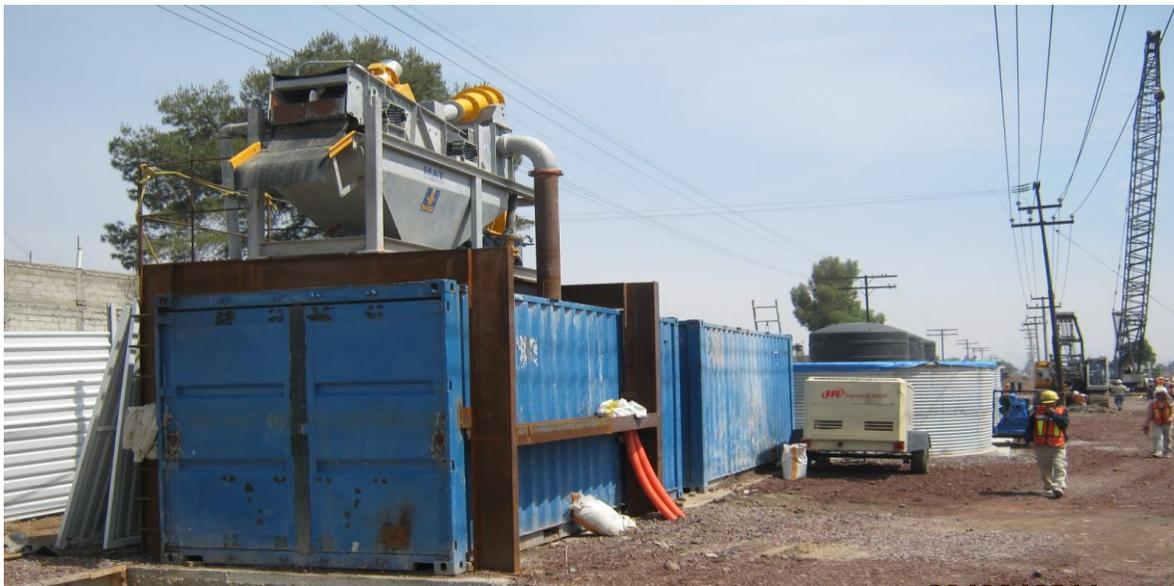
**Fig.3.12. Planta De Lodos En Lumbrera 3-A
