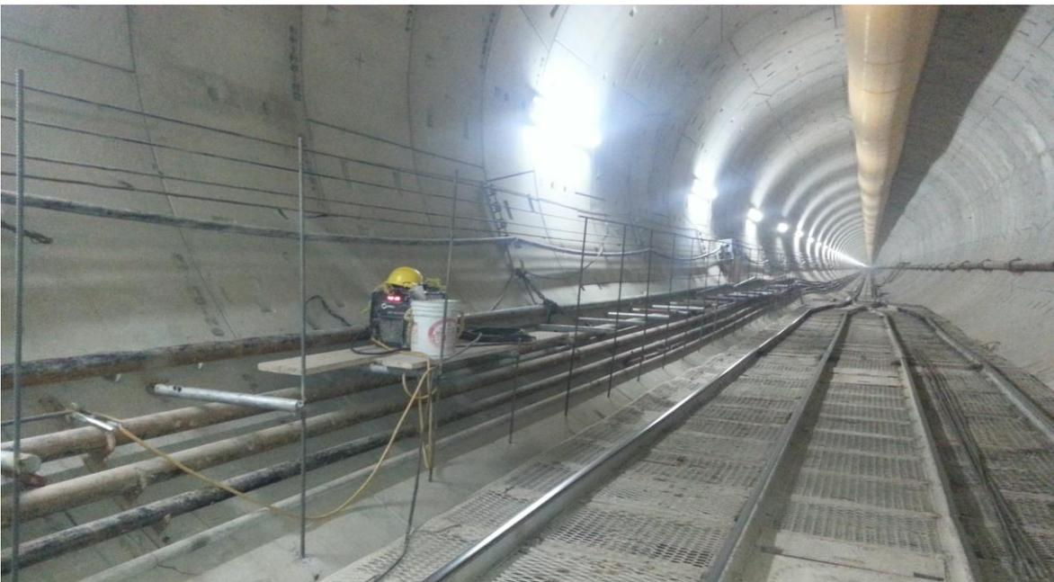
**Fig.12.4. Instalación De Andadores De Seguridad Para El Personal**
