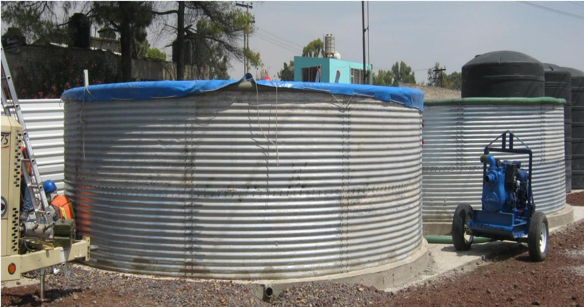
**Fig.3.11. Tanque Chino Utilizado Para La Hidratación Del Lodo Bentonítico
