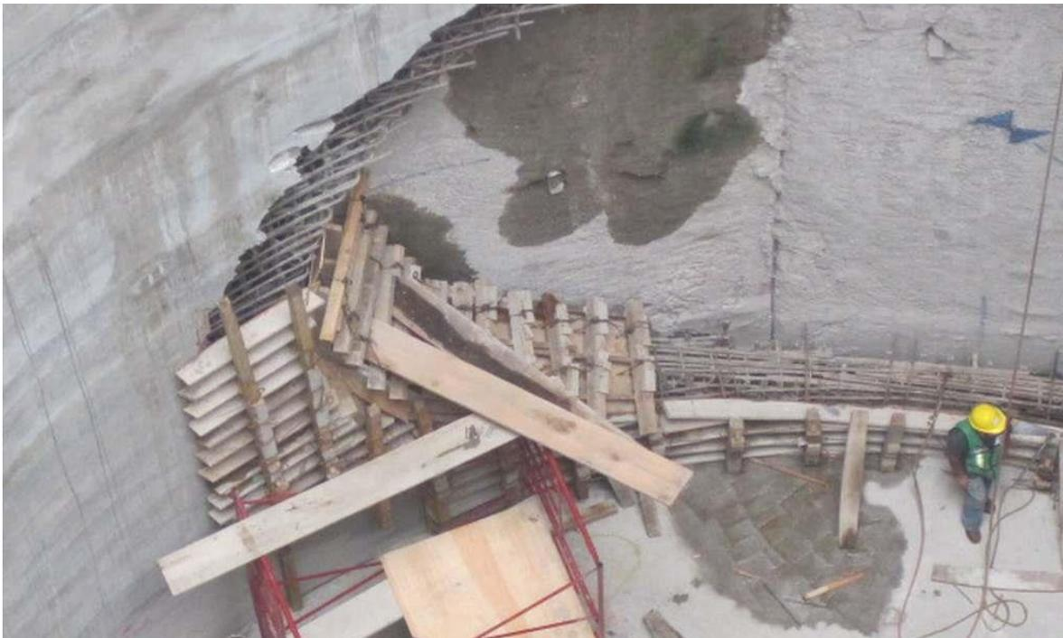
**Fig.7.4. Colocación De Cimbra De Contacto Portal De Entrada L3-A
