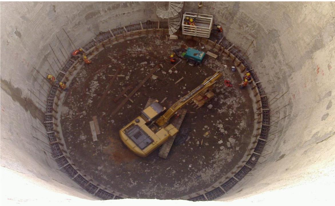
**Fig.5.5. Planta, Armado De Acero De Refuerzo Y Cimbrado Del Anillo De Rigidez**
