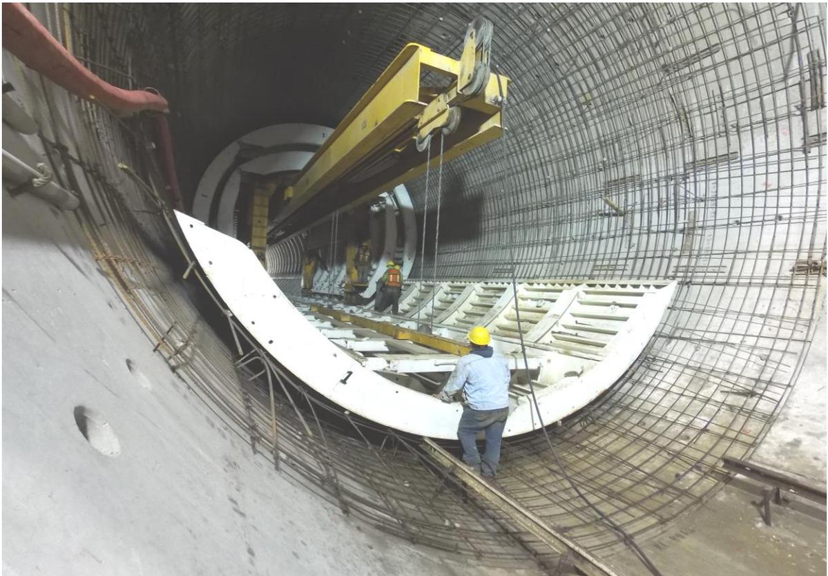
**Fig.10.5. Cimbrado De Cubeta De Túnel Para Revestimiento Definitivo
