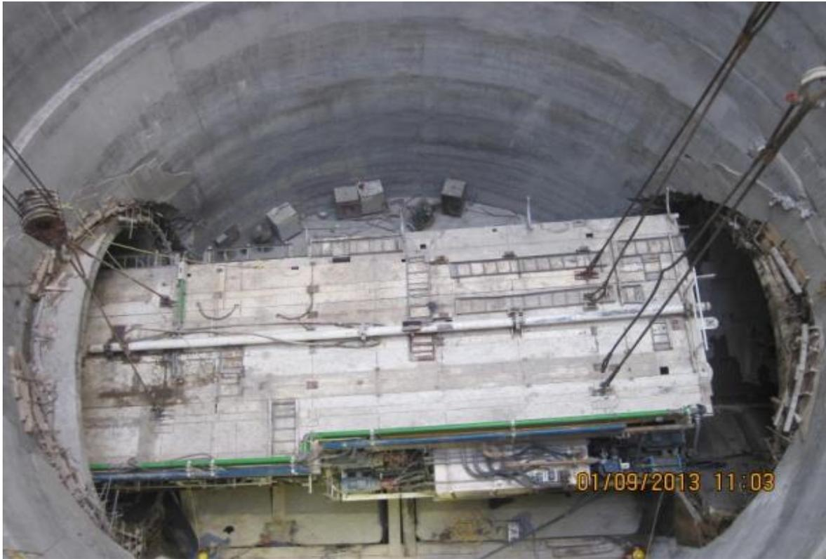
**Fig.9.6. Extracción De La Estructura Del Carro No 3 Del Escudo Hk-S497**
