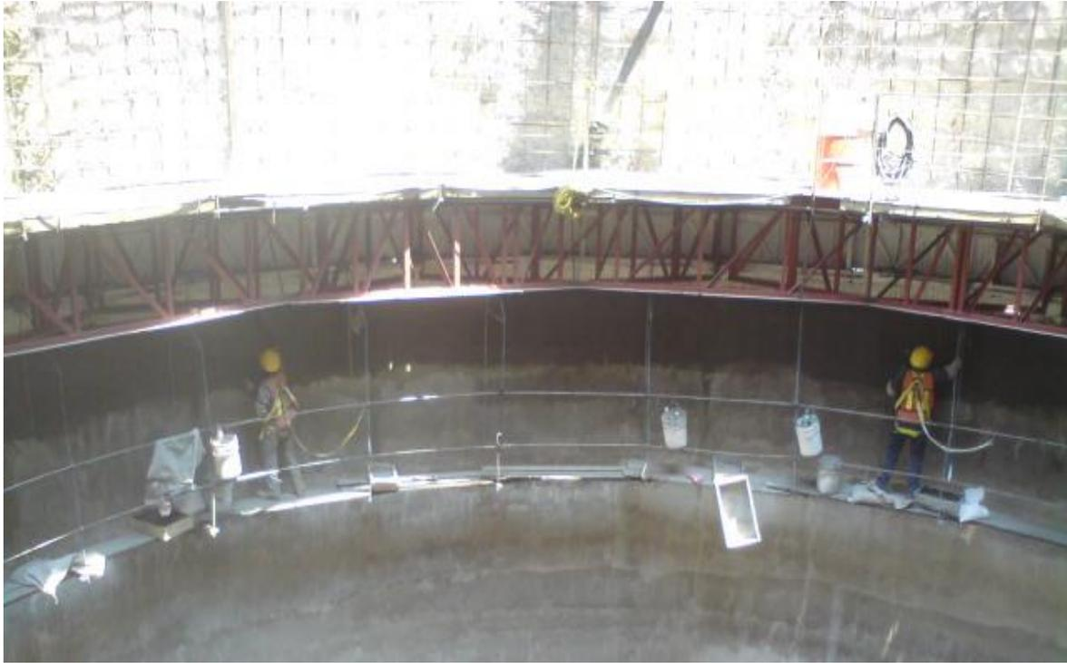
**Fig.6.5. Chuleado Del Revestimiento Definitivo En L3-A
