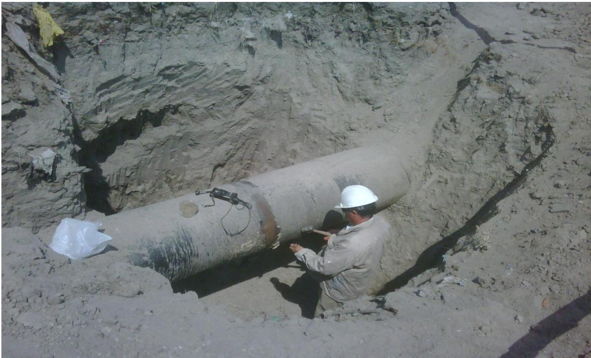
**Fig.2.2. Verificación De Ductos De 24 “ De Pemex Para Su Extracción
