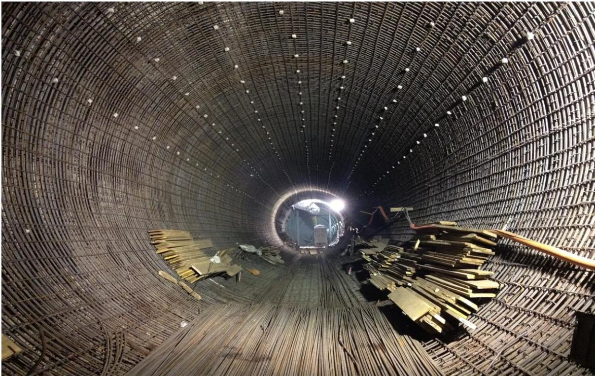
**Fig.10.11 Acero De Refuerzo Dos Lechos Y Separadores De Concreto Para Revestimiento Definitivo**
