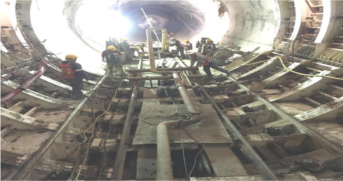
**Fig.10.9. Recorrido Del Snorkel Para El Cambio De Boquilla Durante El Desarrollo Del Colado Del Revestimiento Definitivo De Túnel**
