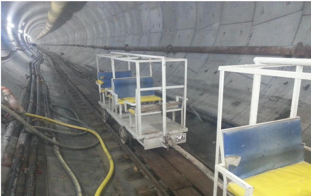
**Fig.12.2. Carros Para El Traslado De Personal De Lumbra Al Frente De Excavación**
