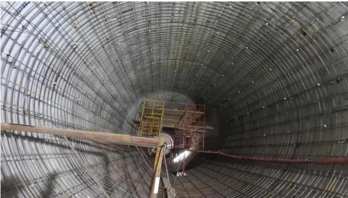
**Fig.10.4. Armado De Acero De Refuerzo Segundo Lecho Sección Completa Para El Revestimiento Definitivo De Túnel De L3 A L3-A**
