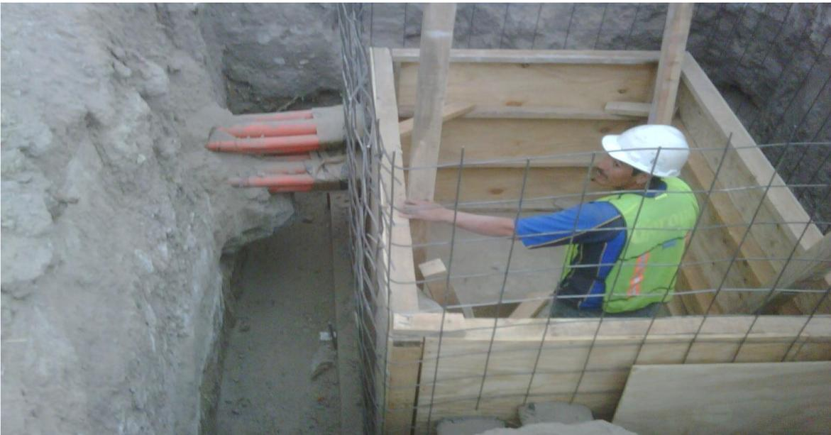
**Fig.2.4. Construcción De Registros Para Desvío De Líneas Eléctricas**
