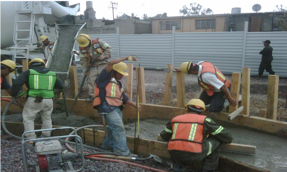
**Fig.3.8. Colocación Y Vibrado De Concreto Para El Colado De Brocal Interior**
