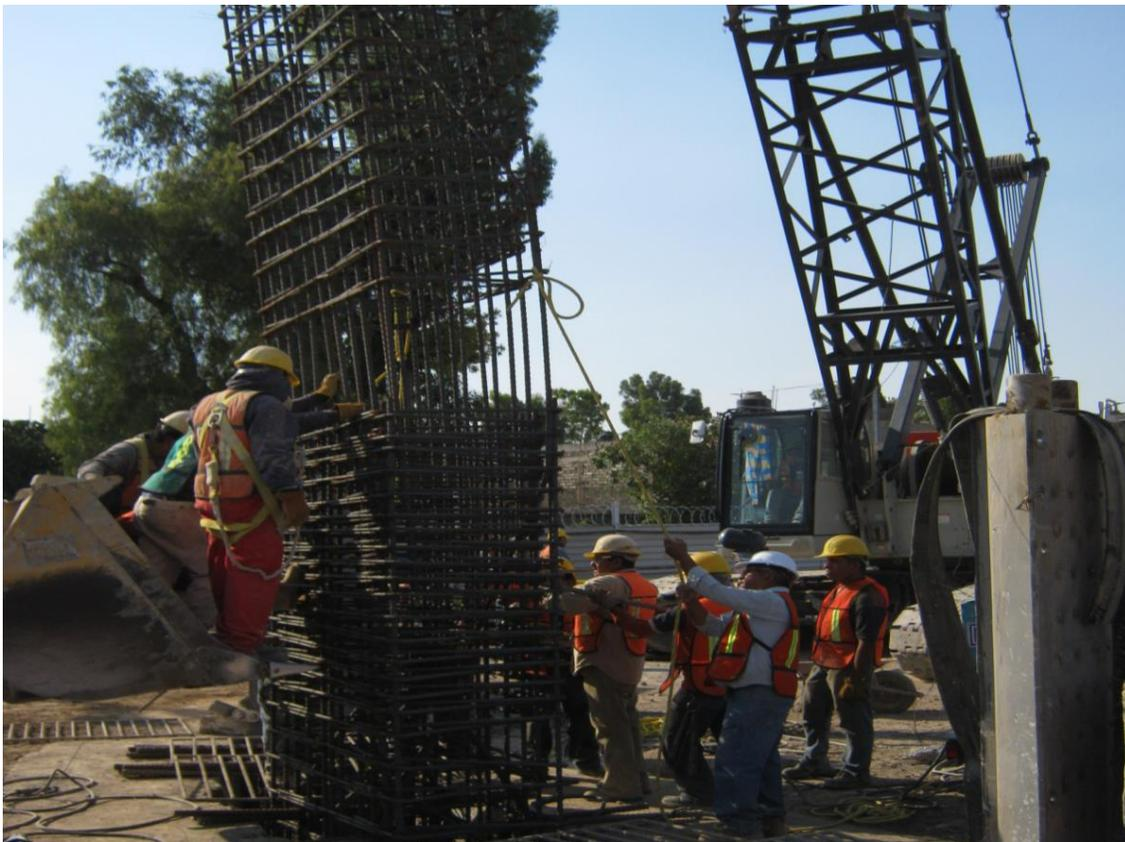
**Fig.3.17. Empate De Las Dos Secciones De Armado Para Muro Milán L3-A**
