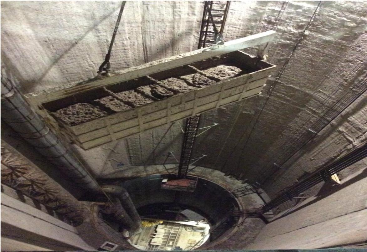
**Fig.8.10. Extracción De Rezaga Del Fondo De Lumbra A Superficie**
