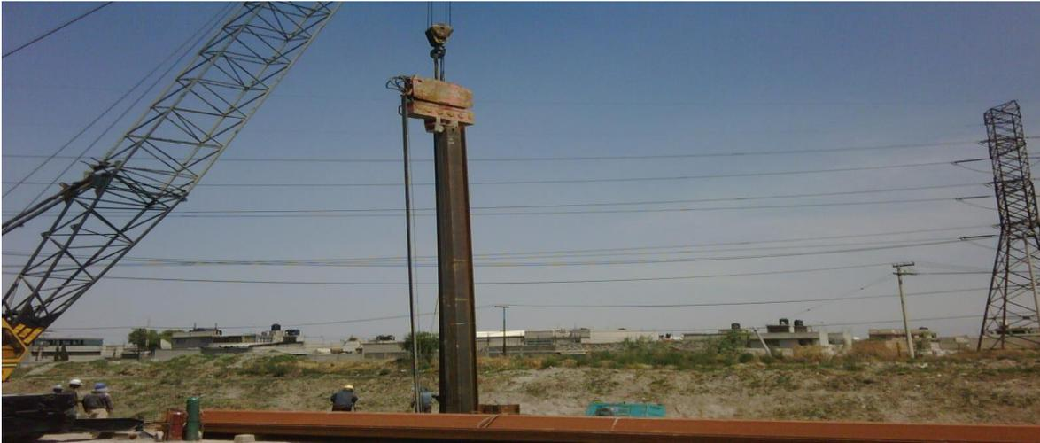
**Fig.2.7. Hincado De Tablestaca En Talud Para Extensión De La Plataforma De Trabajo**
