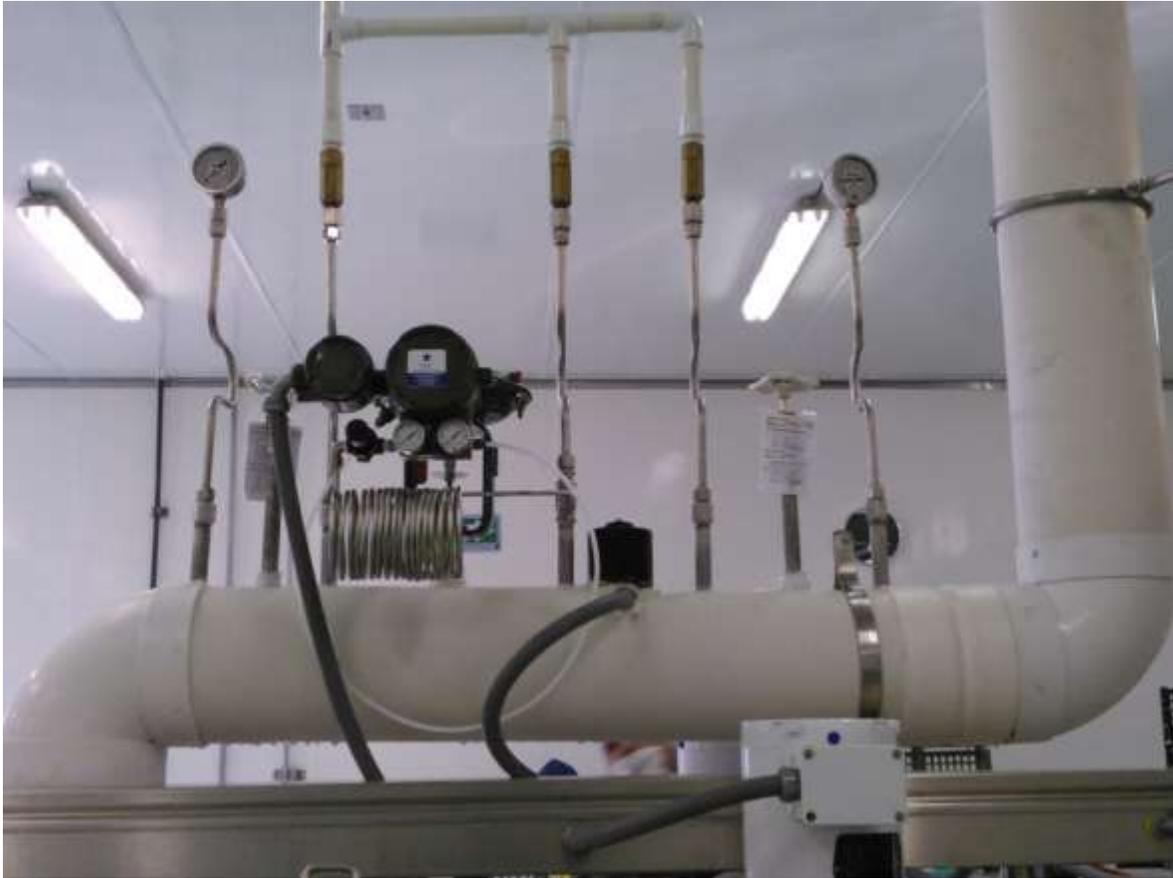
Figura 1.22 Instrumentación de la alimentación del Nitrógeno líquido.
