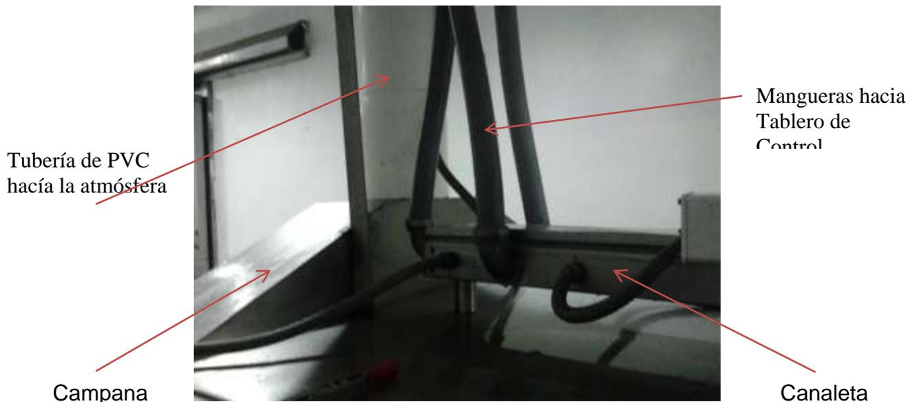
**Figura 1.7 Canaleta y Campana Instaladas**
