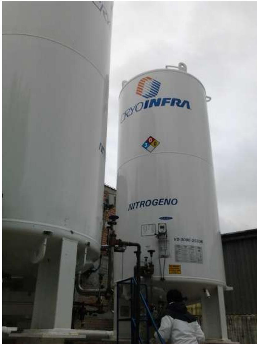
**Figura 1.21 Tanque de Nitrógeno Líquido**
