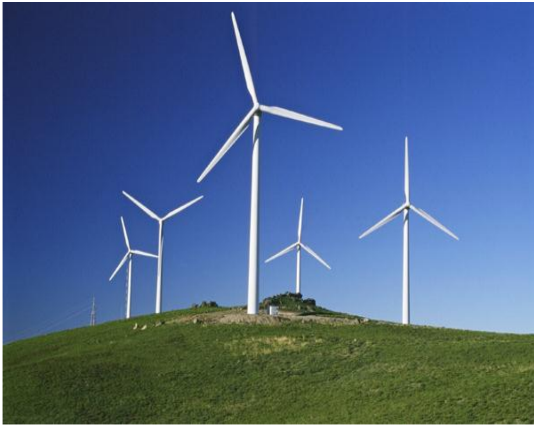
Fig.-1. 2 Parque Eólico.
