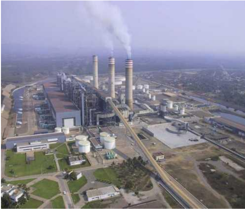
Fig.-1. 7 Central termoeléctrica de Petacalco.
