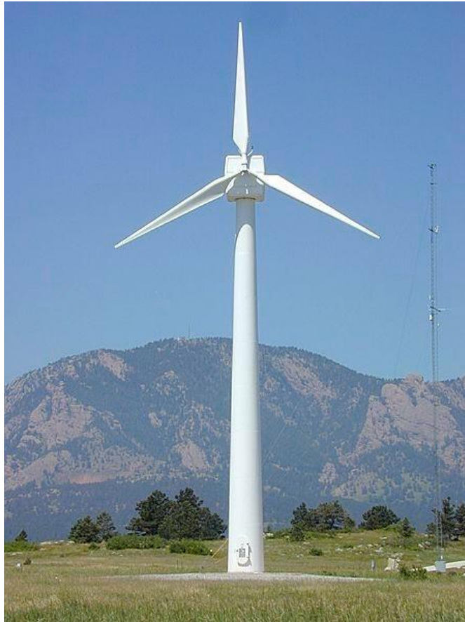
Fig.-2. 3 Aerogeneradores de potencia media
