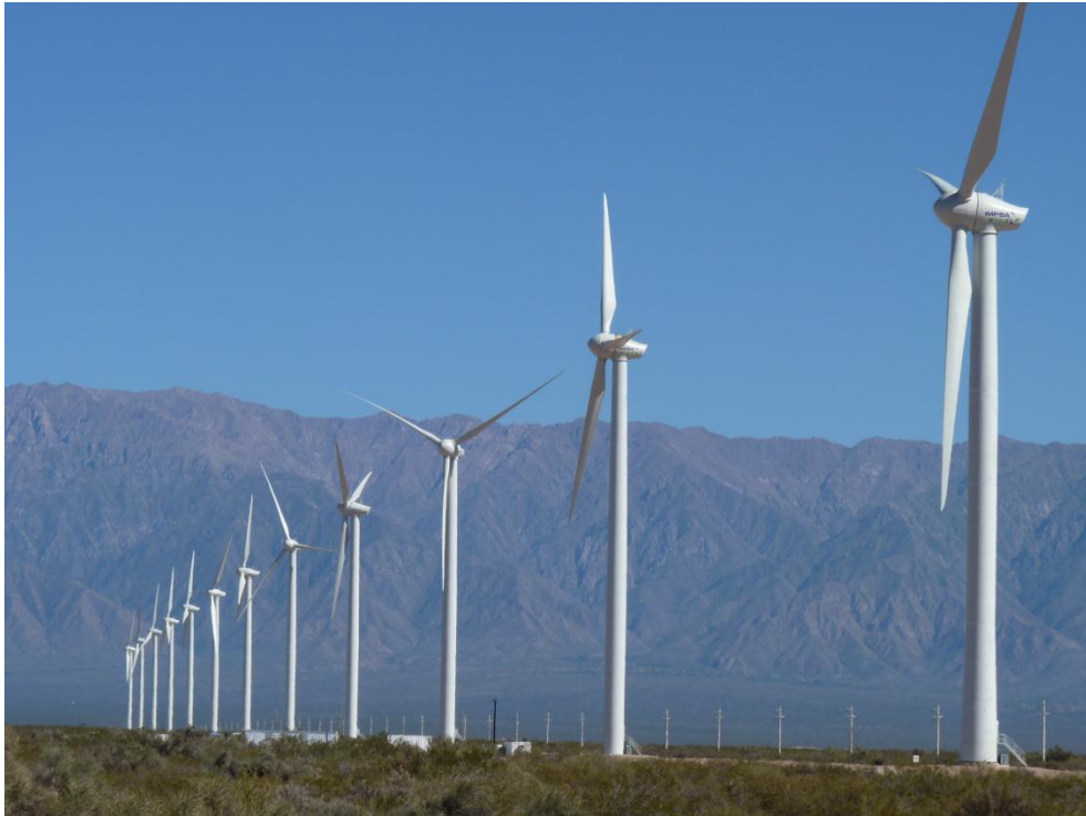
Fig.-1. 12 Parque eólico.
