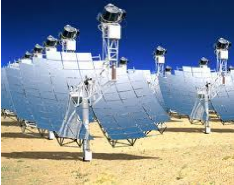
Fig.-1. 5 Central termosolar de colectores distribuidos.
