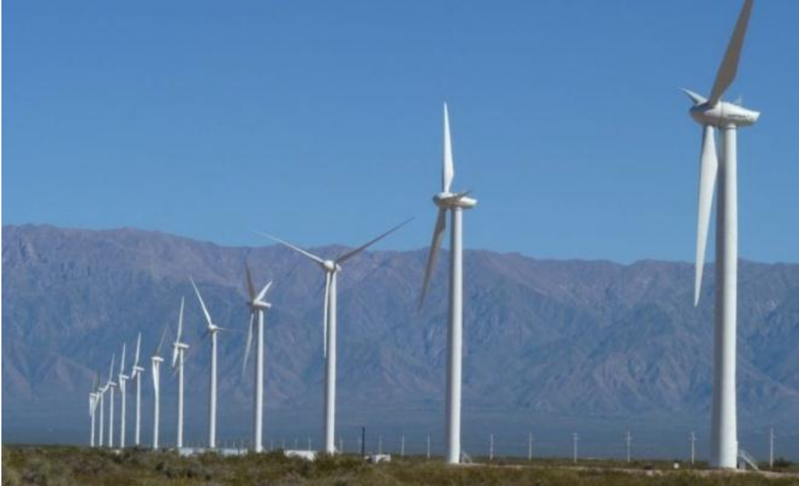
Fig.-2. 4 Aerogeneradores de potencia alta.
