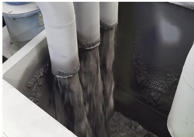
Fig. 9. Sobre-flujo de los ciclones del Molino SAG
