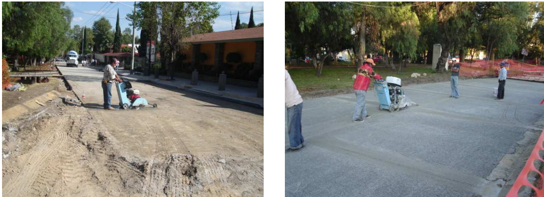
Cortadoras con disco de diamante para realizar el aserrado del concreto.
