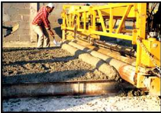
Rodillos compactadores de concreto sobre cimbra fija.
