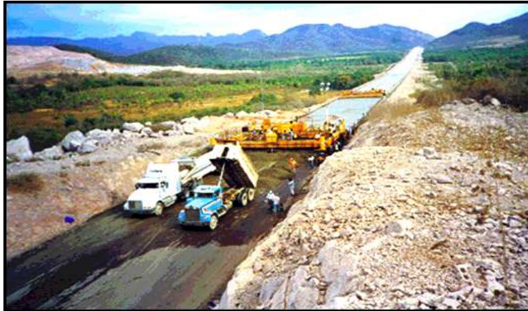
Pavimentación de una carretera con equipo de cimbra deslizante.
