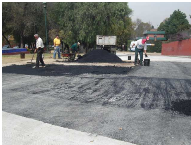
Reencarpetamiento de un pavimento con carpeta asfáltica.
