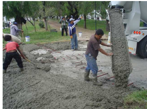
Barras pasajuntas a lo largo de una junta transversal.
