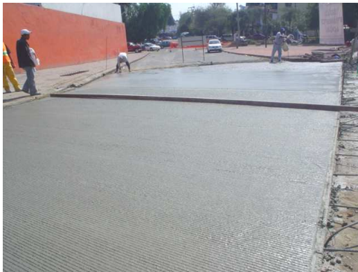
Barras de amarre a lo largo de una junta longitudinal.
