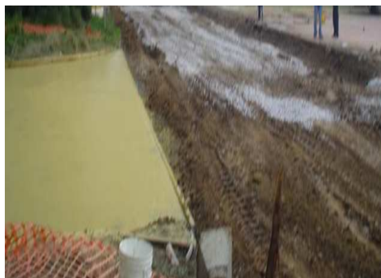
Trabajos de mejoramiento para la capa subrasante.
