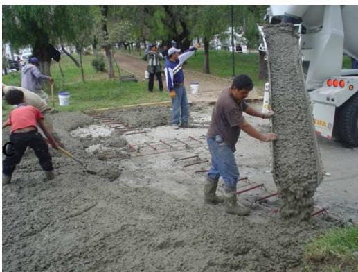
Colocación manual del concreto.
