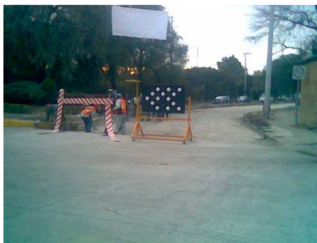
Figura 98.- Dispositivos de señalamiento provisional.
