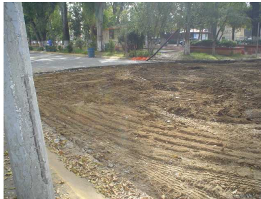
Nivel de desplante sin mejorar ni compactar para la capa subrasante.
