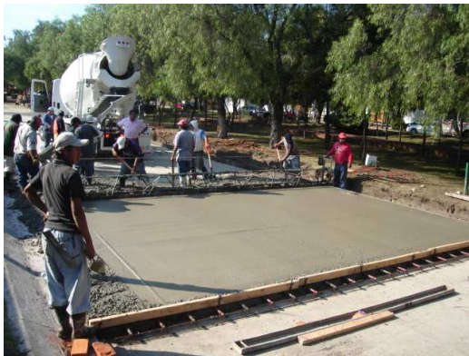
Barras pasajuntas a lo largo de una junta transversal.
