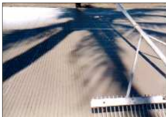
Peine con dientes metálicos para texturizado transversal manual.
