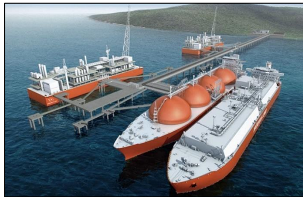
Figura 3.12. Unidad Flotante de Almacenamiento y Regasificación de Gas Natural Licuado (FSRU) [67].
