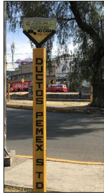
Figura 2.41. Poste de señalización de ducto de transporte (foto original tomada en campo).
