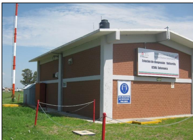
Figura 2.23. Edificio de una estación de compresión (foto original tomada en campo).
