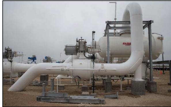
Figura 2.25. Tanque separador de líquidos [44].
