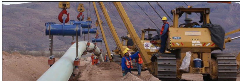
Figura 2.20. Tendido de un ducto de transporte de gas natural [42].
