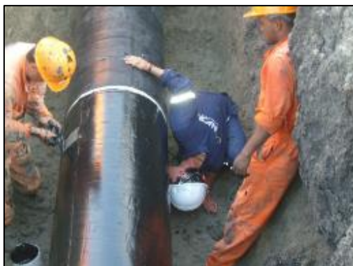
Figura 2.34. Recubrimiento anticorrosivo aplicado en campo [45].
