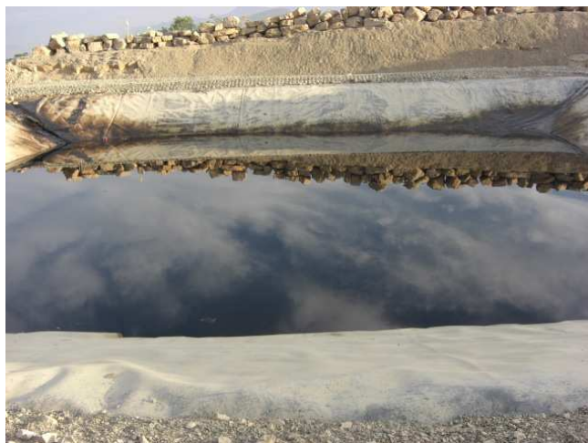
Figura 17.- Laguna de lixiviados construida expresamente para el saneamiento del tiradero.
