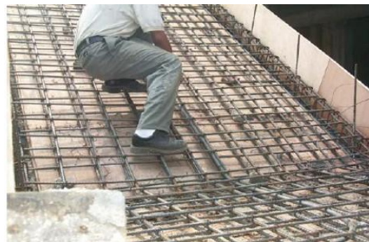
Ilustración 43 Emparrillado de Losa (Manual de procesos constructivos, 2005)
