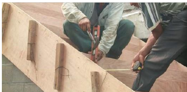
Ilustración 44 Moldeado de huella y Peralte (Manual de procesos constructivos, 2005)
