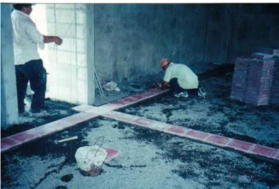
Ilustración 39 Colocación de piezas (Manual de Procesos Constructivos, 2005)
