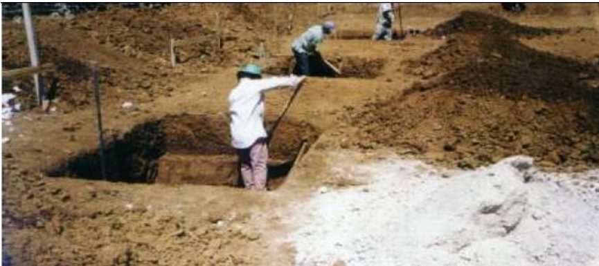
Ilustración 17 Excavación Manual (Manual de Procesos Constructivos, 2005)
