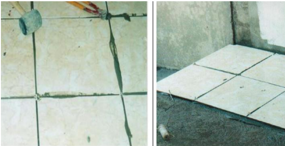
Ilustración 41 Colocación de Pisos cerámicos (Manual de Procesos Constructivos, 2005)
