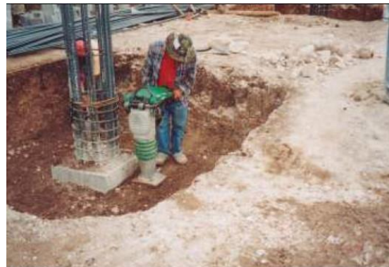
Ilustración 19 Compactación con "bailarina" (Manual de Procesos Constructivos, 2005)
