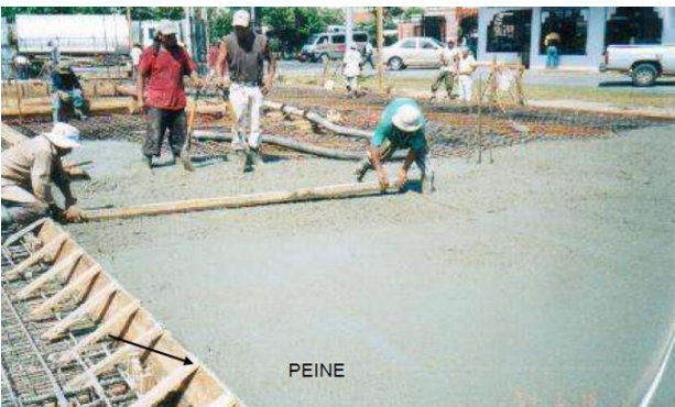
Ilustración 33 Colado de Losa (Manual de Procesos Constructivos, 2005)
