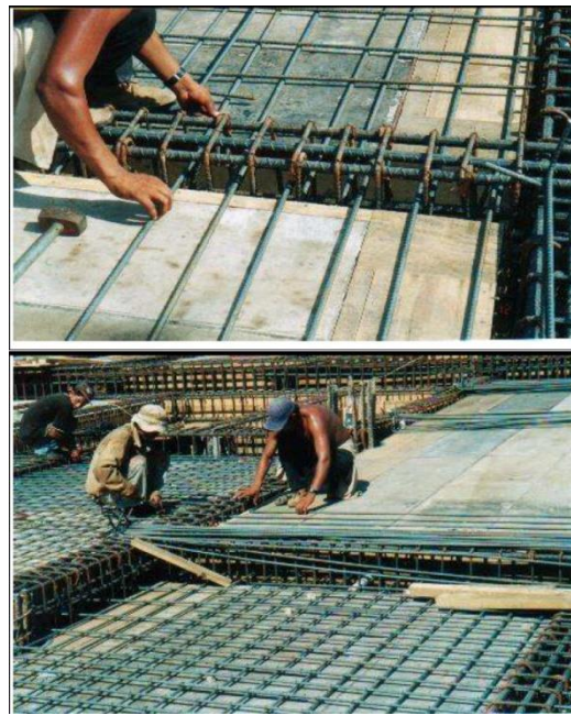
Ilustración 32 Armado de parrilla de Losa Densa (Manual de Procesos Constructivos, 2005)
