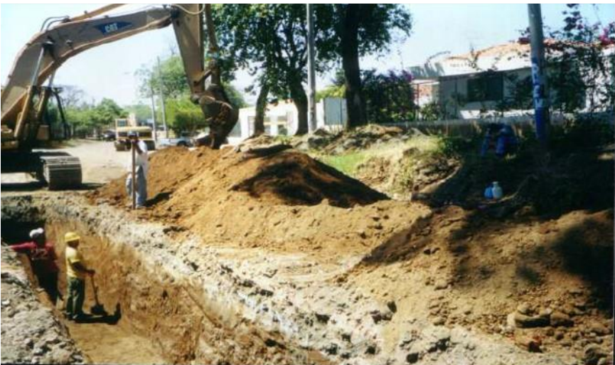
Ilustración 18 Excavación con Maquinaria (Manual de Procesos Constructivos, 2005)
