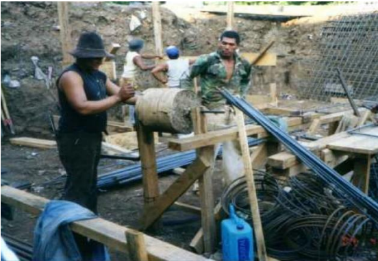
Ilustración 12 Taller de Armaduría (Manual de Procesos Constructivos, 2005)
