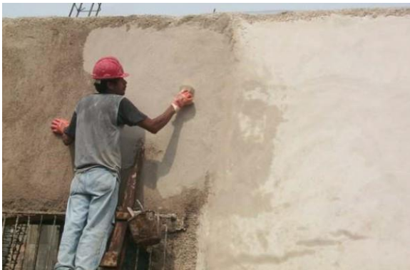
Ilustración 35 Afinado en muro (Manual de Procesos Constructivos, 2005)
