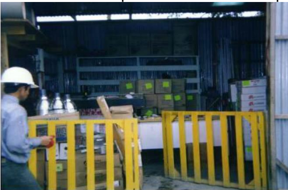
Ilustración 10 Bodega con Estantes (Manual de Procesos Constructivos 2005)
