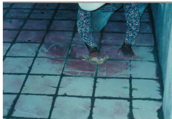
Ilustración 40 Limpieza de piezas (Manual de Procesos Constructivos, 2005)
