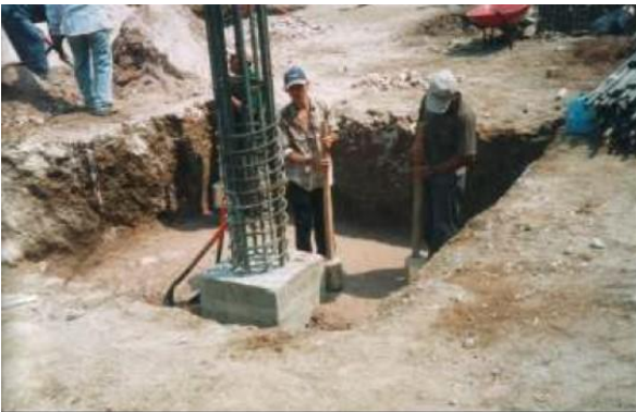
Ilustración 20 Compactación Manual (Manual de Procesos Constructivos, 2005)
