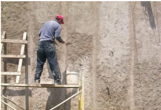
Ilustración 36 Azotado de Mortero en muro (Manual de Procesos Constructivos, 2005)
