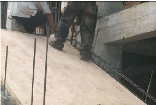
Ilustración 42 Asiento de Losa (Manual de procesos constructivos, 2005)
