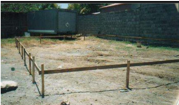
Ilustración 15 Trazo en Obra (Manual de Procesos Constructivos, 2005)
