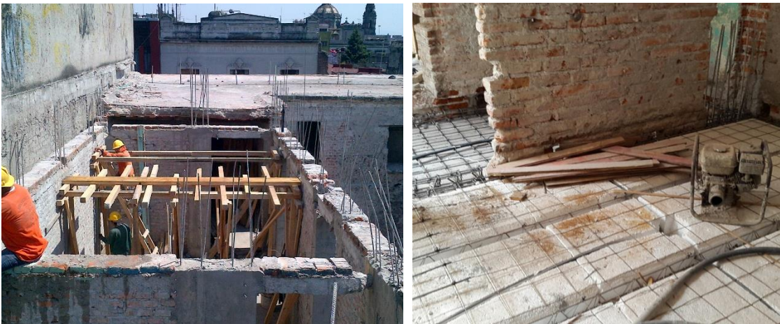
Imagen 40 y 41. Retiro de entrepisos a base de vigas de madera y sustitución de los mismos por vigueta y bovedilla de poliestireno expandido. Fuente: Instituto de Vivienda de la Ciudad de México. Fecha de consulta 15 dic 2018
