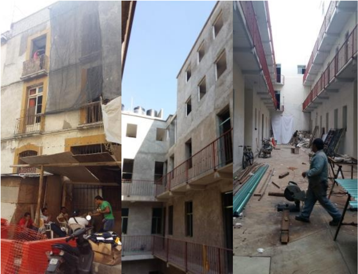
Imagen 46, 47 y 48. Etapa final de la rehabilitación del inmueble academia Fuente: Instituto de Vivienda de la Ciudad de México. Fecha de consulta 15 dic 2018
