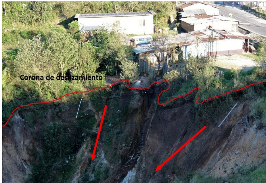
Figura 46. Deslizamiento recurrente cercano a zonas pobladas en la zona noroeste de la cuenca de Motozintla.
