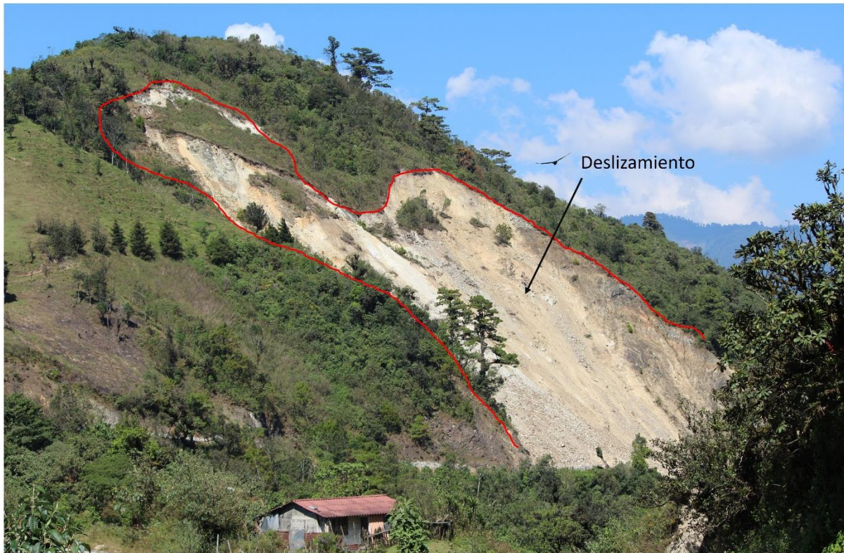
Figura 33. Deslizamiento producto de construcción de camino.
