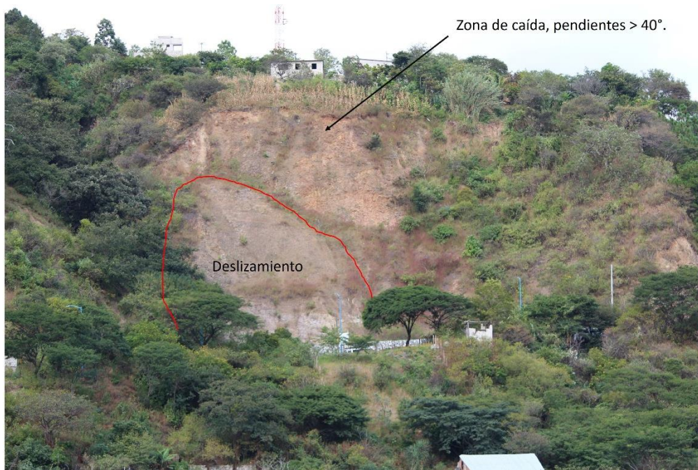
Figura 31. Procesos de caídas sobre la carretera que va de Motozintla a la localidad de Buenos Aires, frente a las oficinas de Protección Civil.
