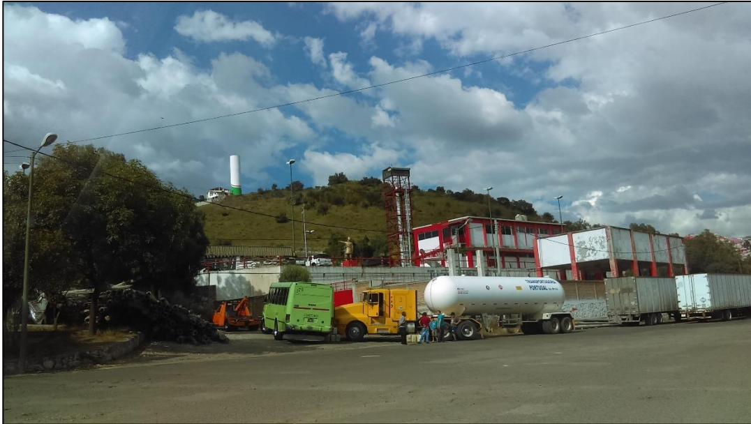
Foto 18. Fraccionamiento Industrial La Presa, en la cual se observa un auto tanque de almacenamiento de gas L.P.
