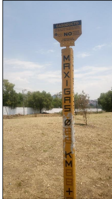
Foto 27. Ductos de gas que se encuentran en el área de estudio.
