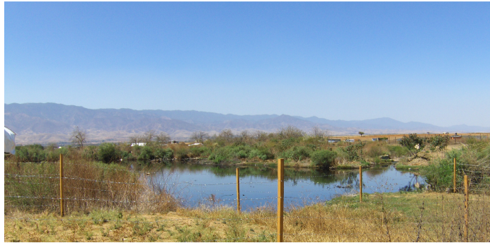
Figura 56. Laguna de lixiviados.
