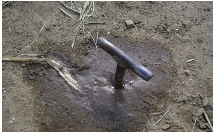
Figura 60. Electrodo en terreno humedecido con agua y NaCl.
