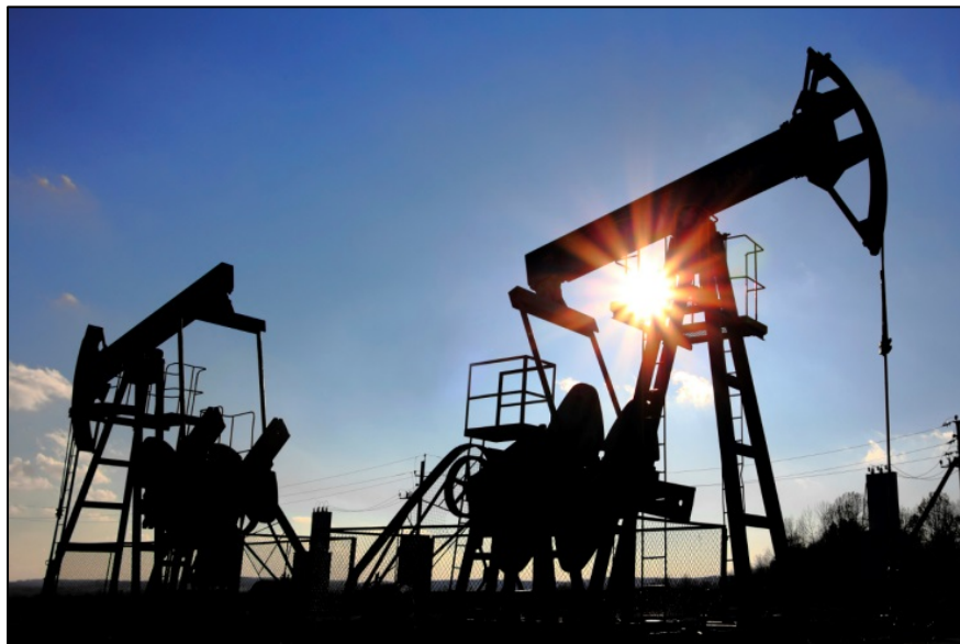
Figura 1.2 Instalación de planta para la extracción del petróleo
