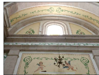
Humedad en cornisas y arcos. Perdida de juntas en elementos de cornisa labrada.
