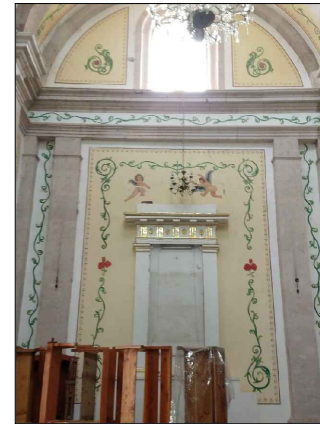
Humedad en cornisas y arcos. Perdida de juntas en elementos labrados de cantera. Grietas en muros.
