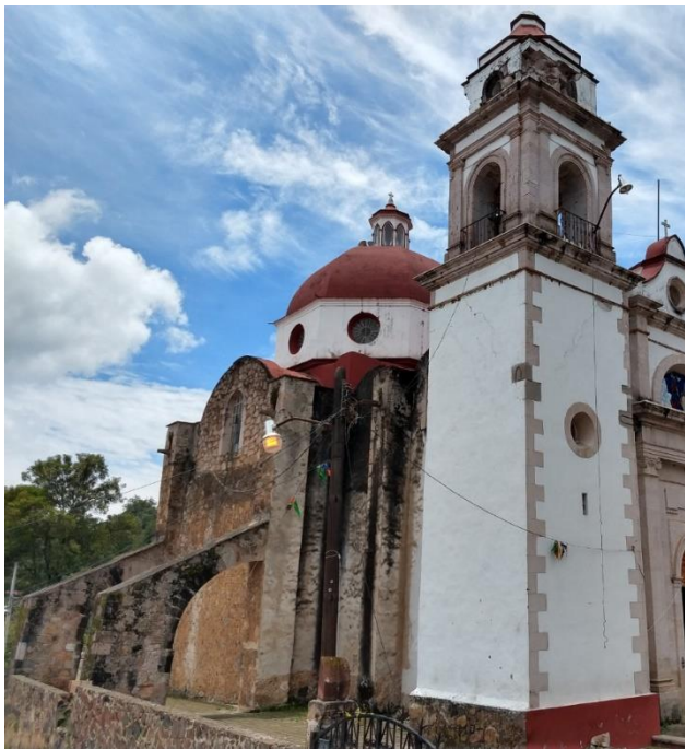
FIG. 23 Vista de la fachada lateral norte del templo del Señor de Acatzingo, Acatzingo de la Piedra, Tenancingo. Se observa en primer plano, la torre campanario, y en segundo plano, se aprecia la fachada lateral norte del templo. Imagen: Jessica Salazar. Consulta 13-11-2018.
