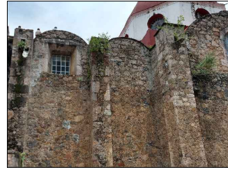
Flora parasita en gargolas y juntas de piedra de mamposteria.
