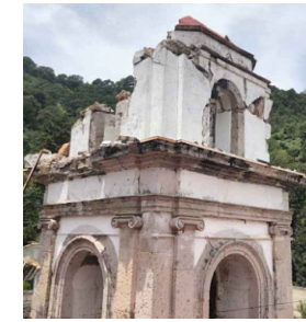
Perdida total de cupulin y perdida parcial de segundo cuerpo de torre. Fractura y grietas en muros. Desprendimiento de piezas de cantera en cornisa. Perdida de juntas en elementos de cantera labrada.
