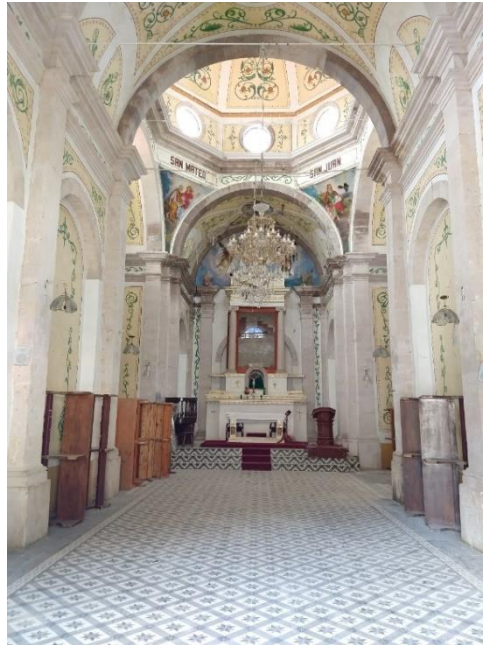
FIG. 19 Vista desde la nave hacia el ábside. Estado actual posterior al sismo de septiembre de 2017. En primer plano, se observa la nave del templo, y en segundo plano, destaca el ábside con el altar mayor. Imagen: Jessica Salazar. Consulta 12-11-2018.
