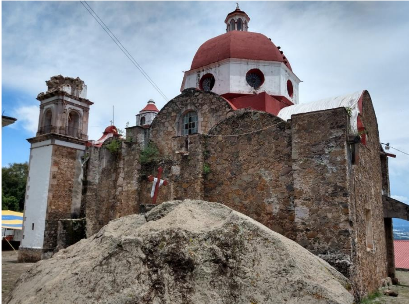
FIG. 24 Vista de la fachada lateral sur del templo del Señor de Acatzingo, Acatzingo de la Piedra, Tenancingo. Se observa en primer plano, la fachada lateral sur del templo, y en segundo plano, se aprecia la fachada posterior oriente del templo. Imagen: Jessica Salazar. Consulta 13-11-2018.
