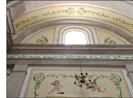
Humedad en cornisas y arcos. Perdida de juntas en elementos labrados de cantera. Grietas en muros.
