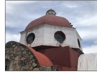
Fisuras, aplanados flojos y humedad en tambor de cúpula.
