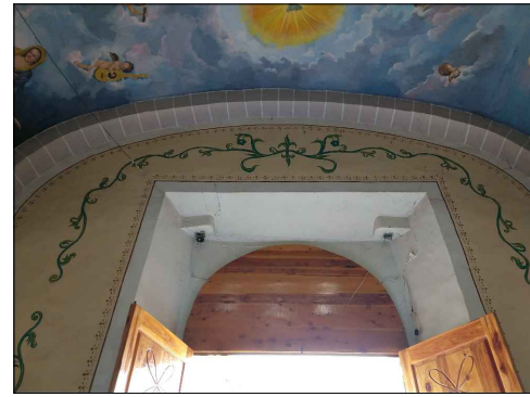
Grietas en muro de sotocoro.
