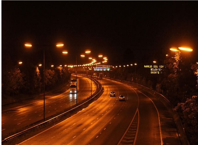
Figura 3.4 Alumbrado público operando lámparas de Vapor de Sodio en Baja Presión (VSBP).
