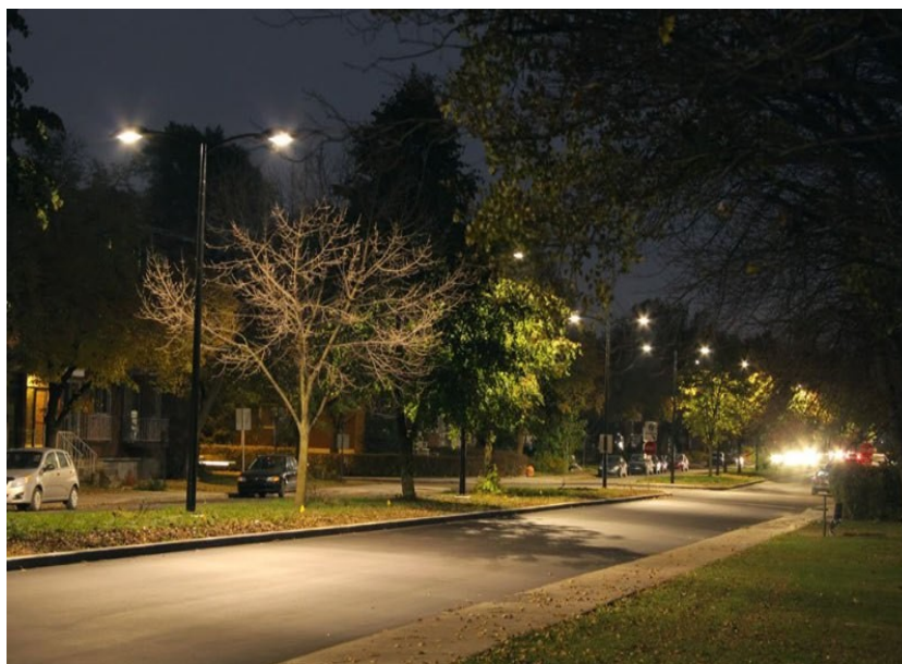
Figura 3.8 Alumbrado público operando lámparas Aditivos Metálicos Cerámicos (AMC).
