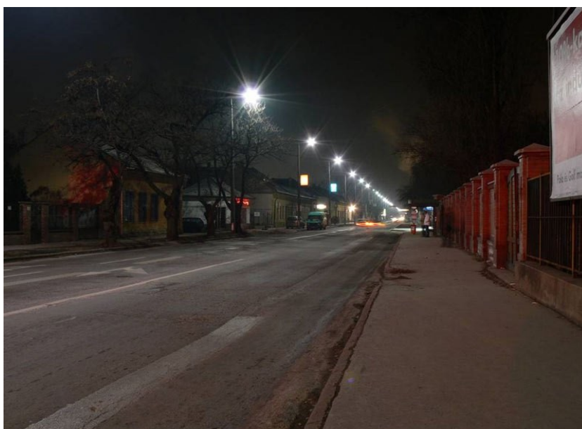
Figura 3.5 Alumbrado público operando lámparas de Aditivos Metálicos (AM).
