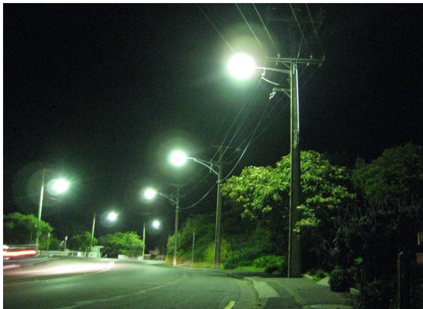
Figura 3.2 Alumbrado público operando lámparas de Vapor de Mercurio (VM) con color corregido.
