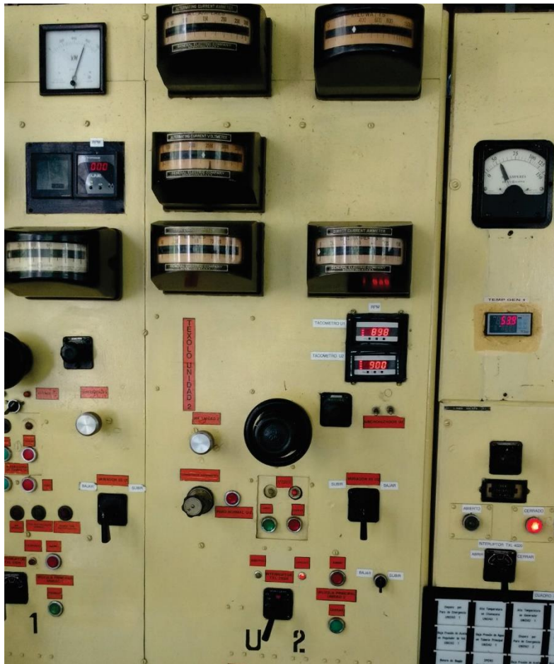
Figura 3.2: Sincronizador para los generadores que se encuentran en la central hidroeléctrica Texolo. La sincronización se realiza en los tableros de la central.
