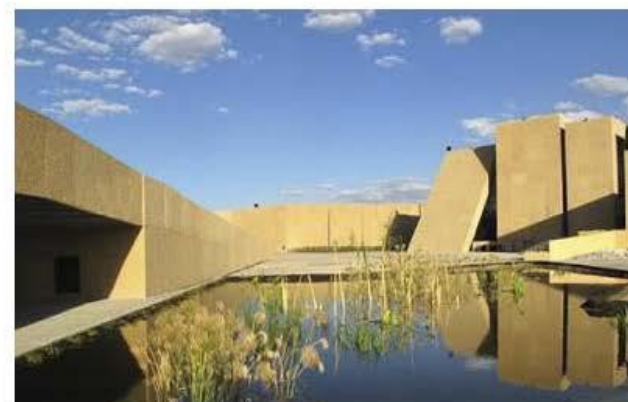
Edificio de talleres
