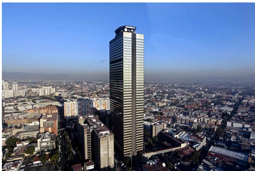
Foto tomada desde las alturas a la torre ejecutiva Pemex
