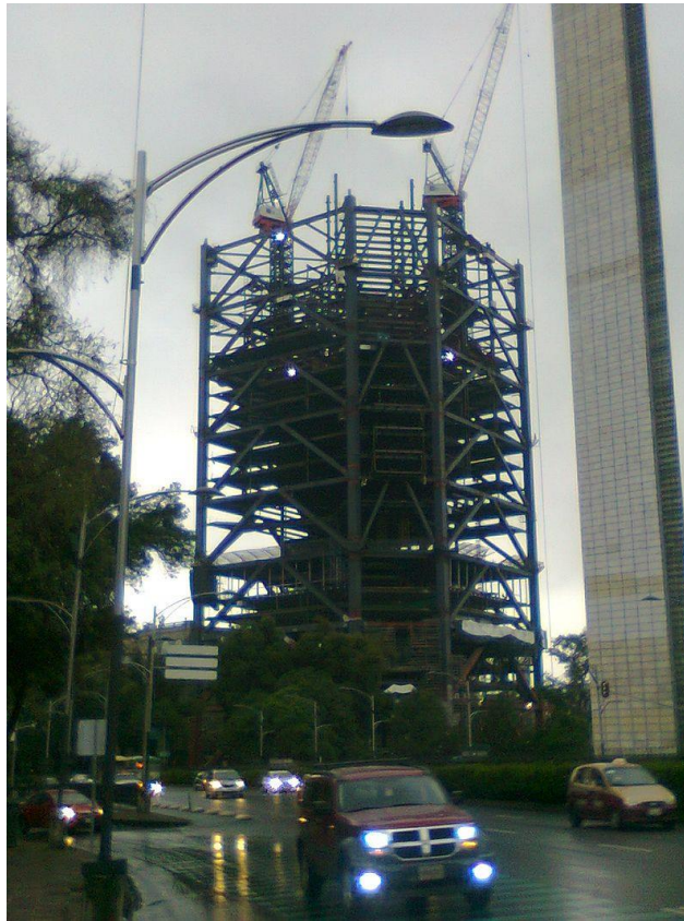
Foto de la torre BBVA BANCOMER en el proceso de construcción.
