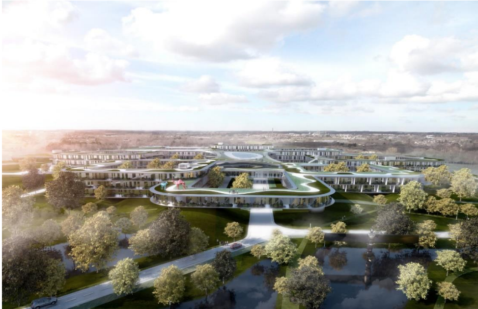
Imagen 18. Nyt Hospital Nordsjælland, Copenhagen (2013)
