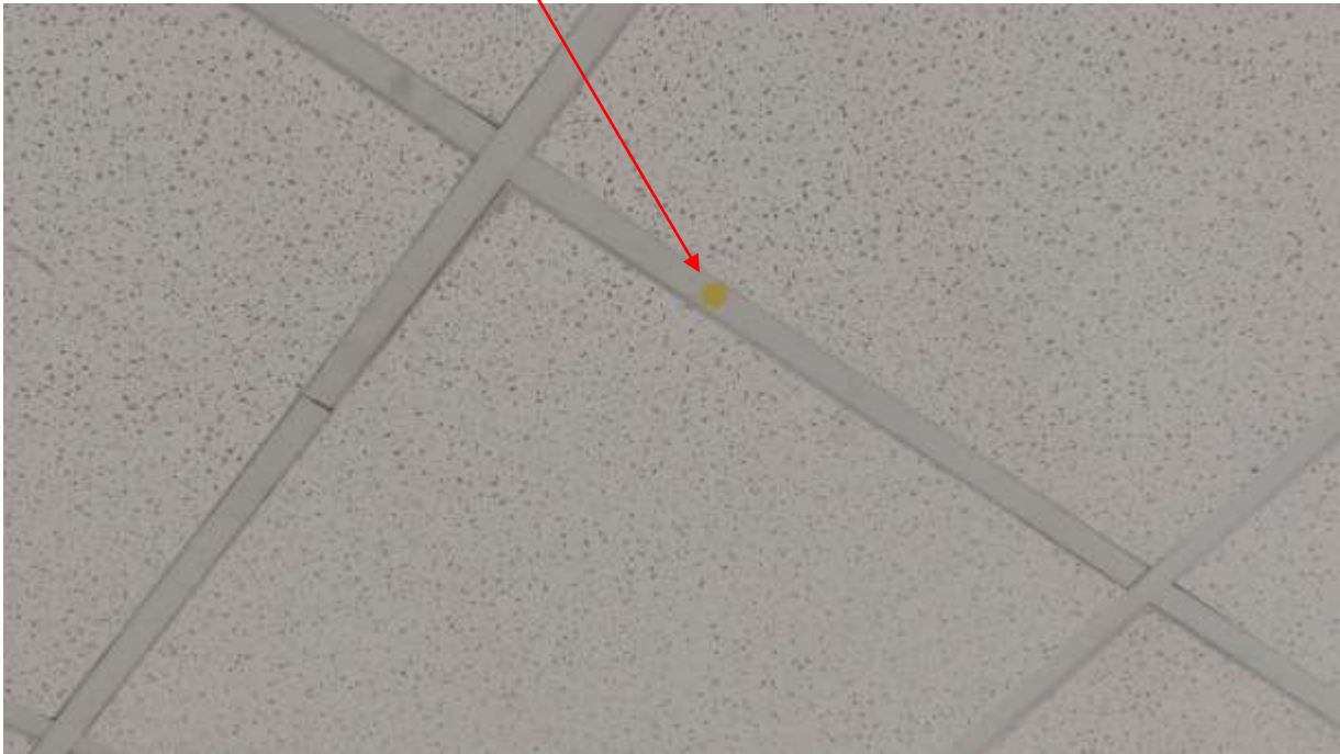
Figura 3.3.- Ubicación de los nodos del edificio Z, marcados con una etiqueta amarilla
