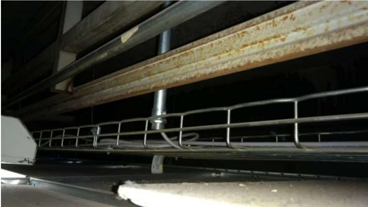
Figura 3.2.- Muestra el techo del edificio Z al levantar los plafones
