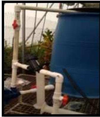
*Figura 3. 16 Instalación de filtro.*
