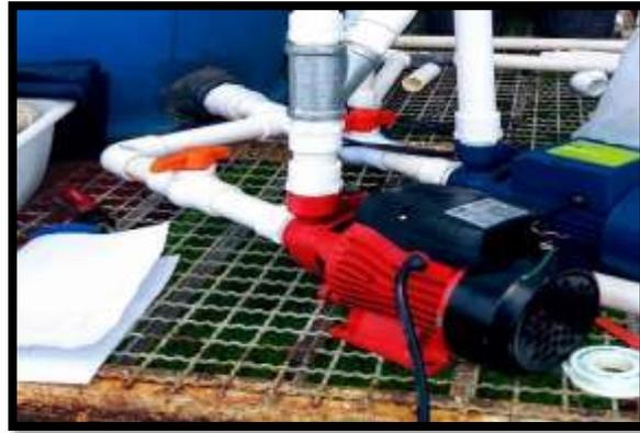
*Figura 3. 15 Conexión física de tinaco con bomba.*
