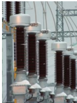
Figura 1.15. Transformador de potencial inductivo.
