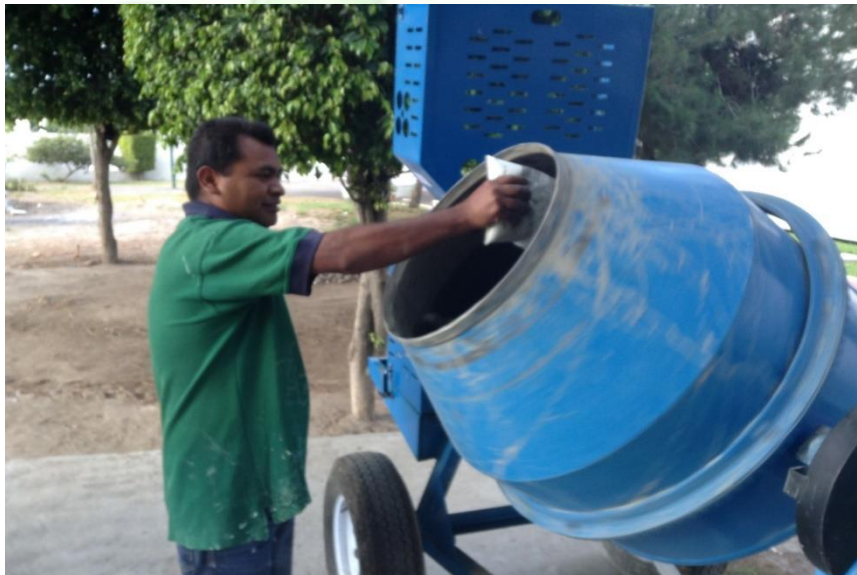
Fig. 30. Incorporación de CPC mecano activado previamente dosificado, al CPC normal
